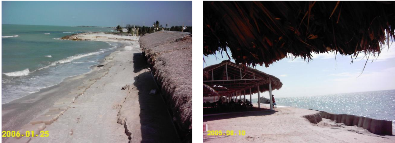
Figura 100. Efectos de la erosión en Club de Playa
