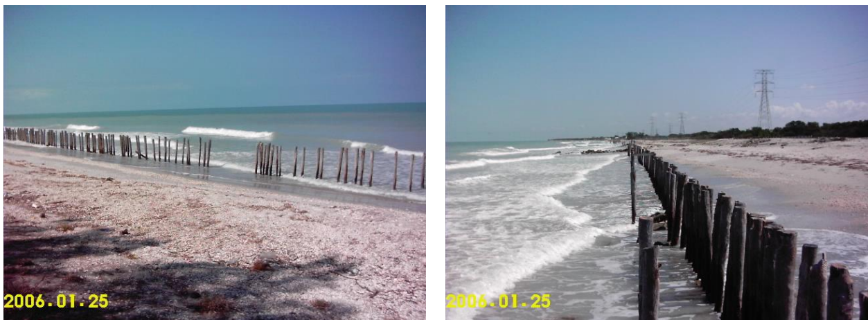
Figura 103. Protección de playas con cerco de palos localizados en algunos sitios en la parte Oeste de la Isla del Carmen.
