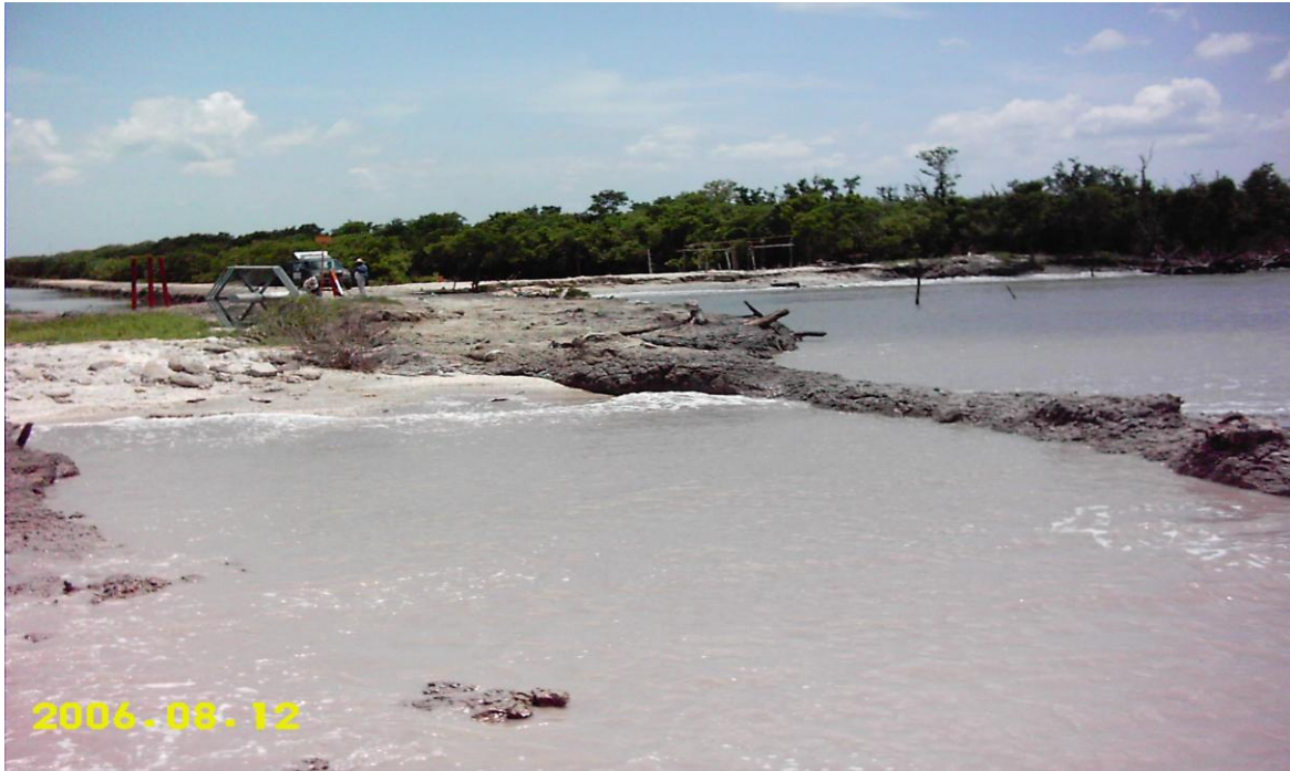
Figura 21. Erosión en la Playa del Centro de Proceso y Transporte de Gas Atasta.
