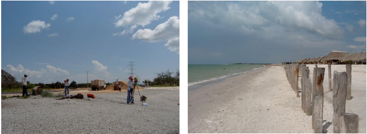
Figura 102. Playa Bahamita con aporte de material de construcción y protección de barrera de palos de madera.
