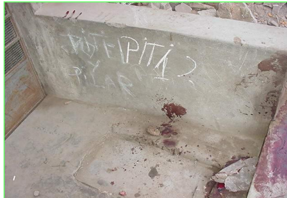
Figura.2.8. Mancha por goteo. PGR, 2009.
