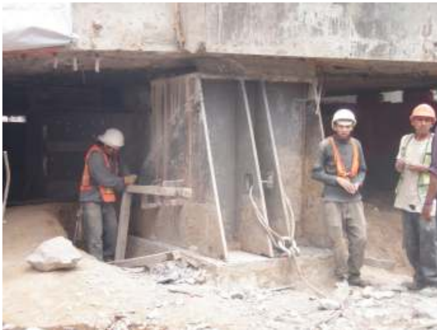
Figura 38c. Detalle de uno de los apoyos temporales, obsérvese la altura.
