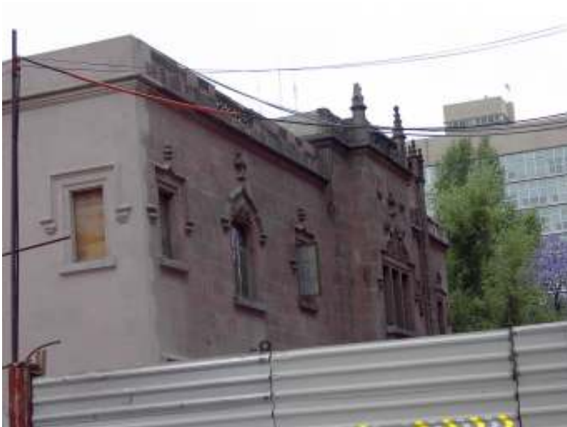
Figura 11. Fachada Poniente sobre Río Elba.
