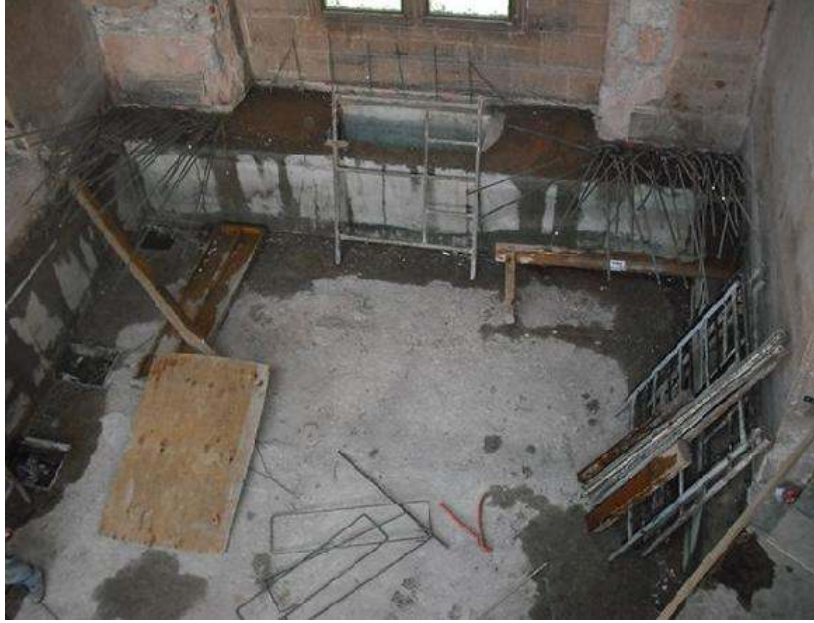
Figura 24a. Losa terminada.
