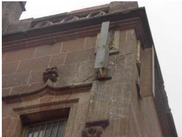
Figura 61. Placas y elementos metálicos para rigidizar fachada.
