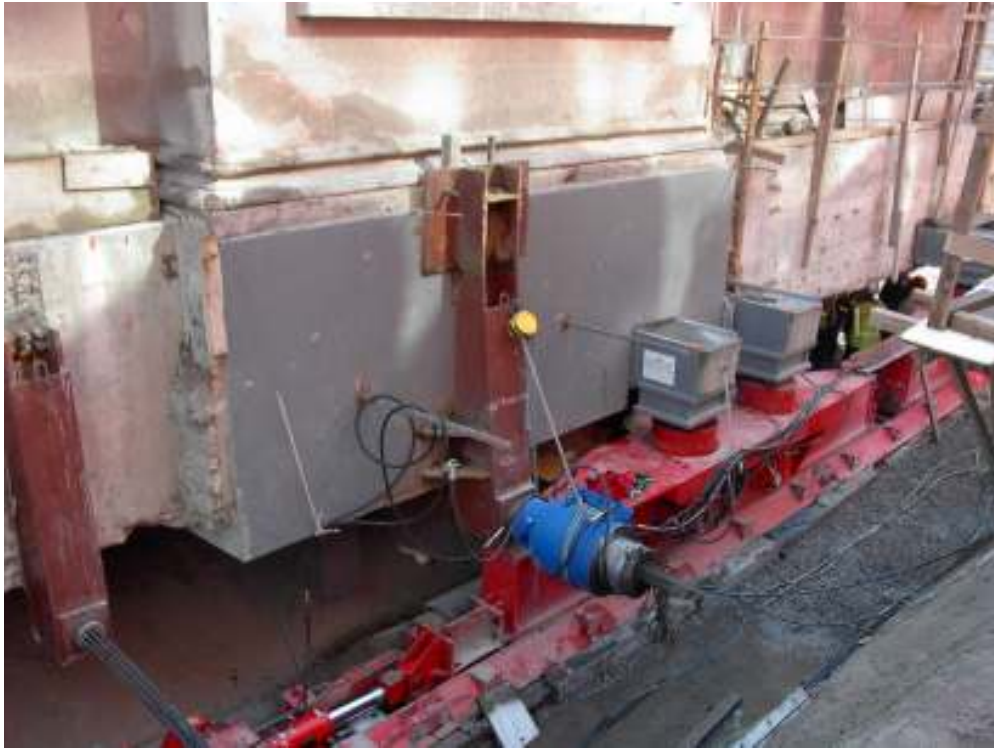
Figura 54. Tensión aplicada a cables de presfuerzo.
