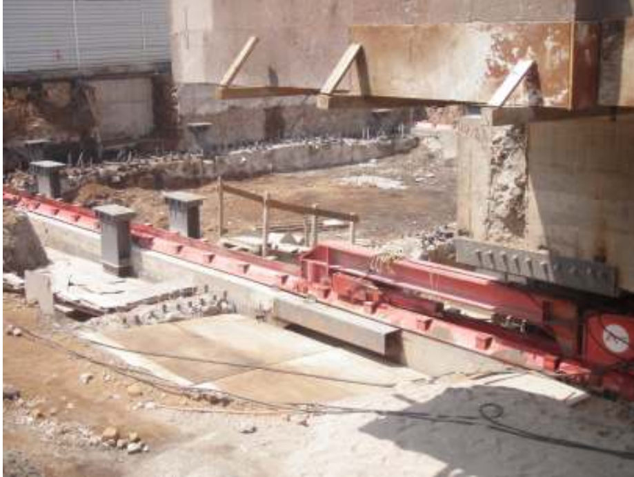
Figura 63a. Apoyos metálicos, al fondo se observa el muro Milán terminado.
