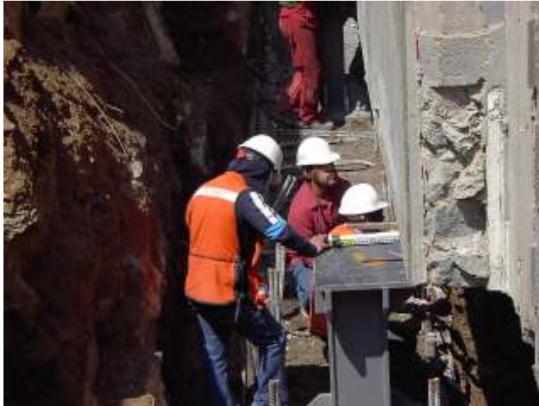
Figura 73. Mediciones previas para alinear la casa sobre Av. Reforma.
