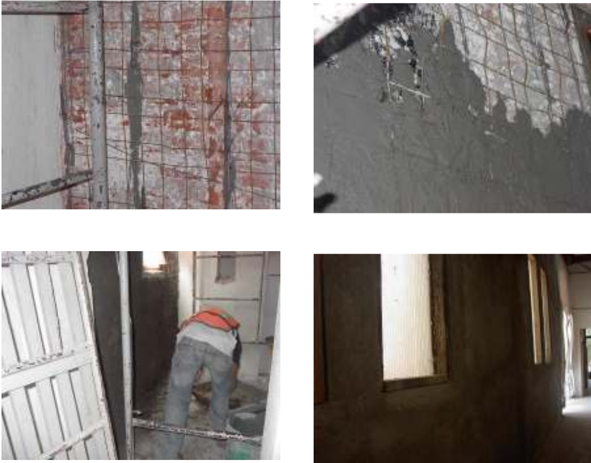
Figura 17. Reforzamiento de muros interiores con malla electrosoldada y repellado con mortero.
