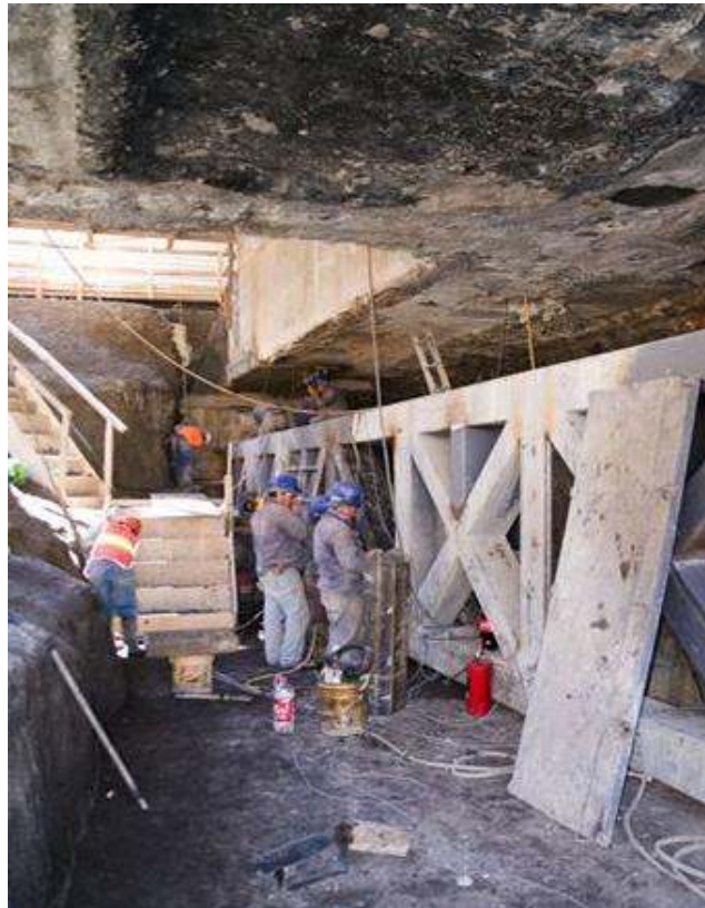
Figura 26c. Colocación de armaduras bajo la casa.
