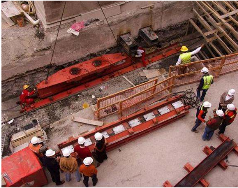
Figura 32b. Maniobras para colocar los skidshoes bajo las ménsulas (cleopatras).
