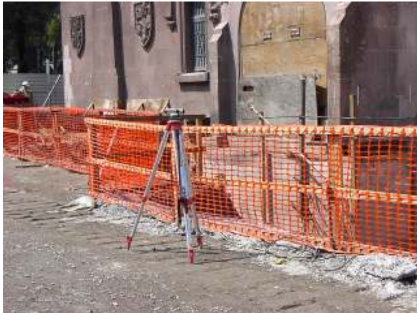
Figura 67. Verificaciones topográficas periódicas durante el movimiento de la casa.
