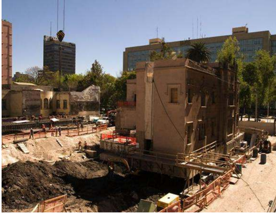
Figura 31b. Trabajos de excavación.
