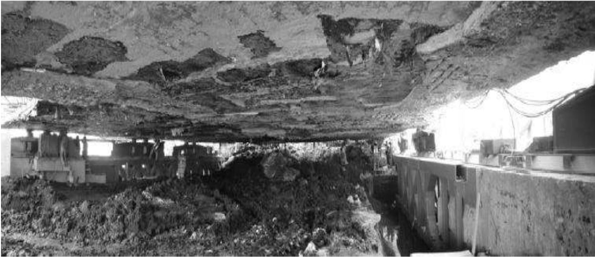
Figura 30. Vista panorámica bajo la cimentación de la casa una vez apoyada sobre los gatos hidráulicos, lista para el movimiento.
