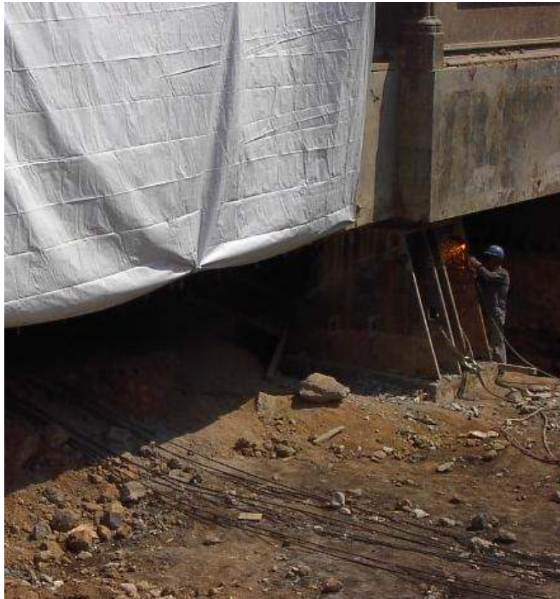
Figura 59. Retiro de apoyos temporales.
