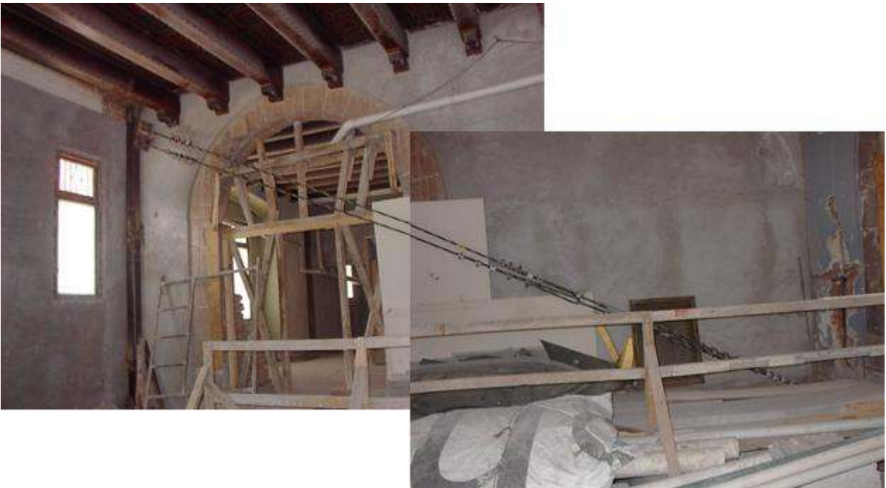
Figura 13. Tensores para rigidizar la estructura.
