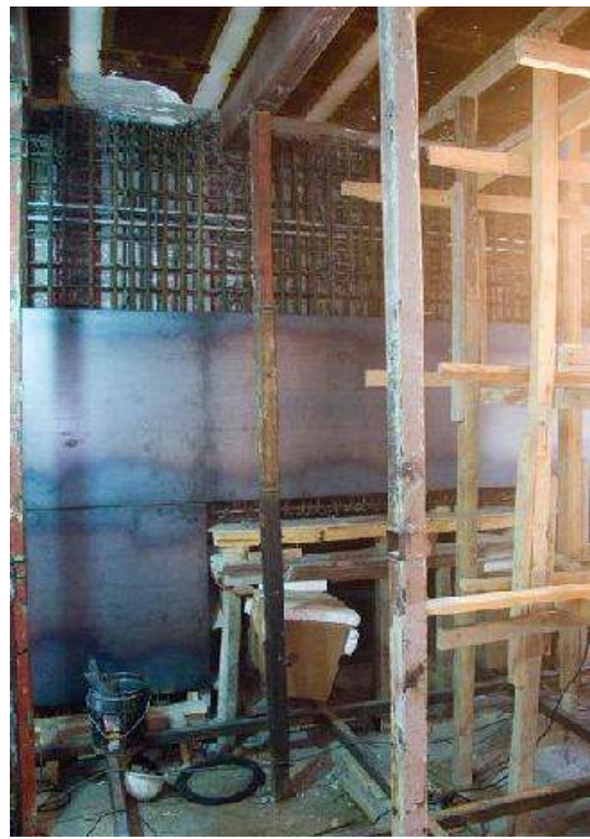
Figura 16b. Reforzamiento de muros con concreto armado y placa metálica.
