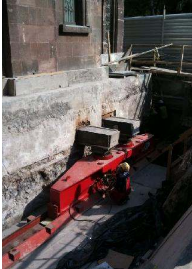
Figura 28. Ménsulas (cleopatras) empotradas en la losa de recimentación.
