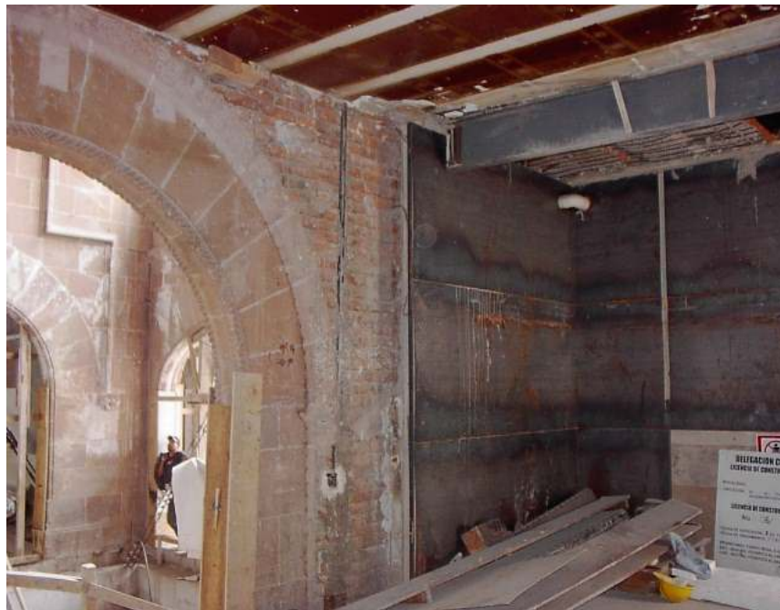
Figura 18. Reforzamiento de losas empleando vigas metálicas.
