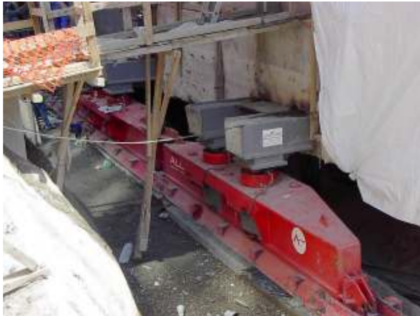
Figura 40. Sistema SKS1000 integrado por rieles modulares y patines de deslizamiento ( skidshoes ).
