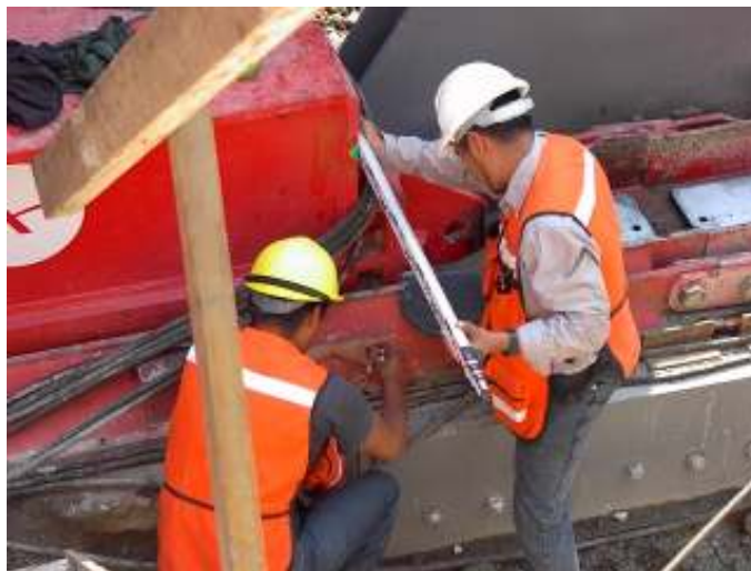
Figura 68. Cada 2 o 3 metros de avance se realizaron mediciones topográficas.
