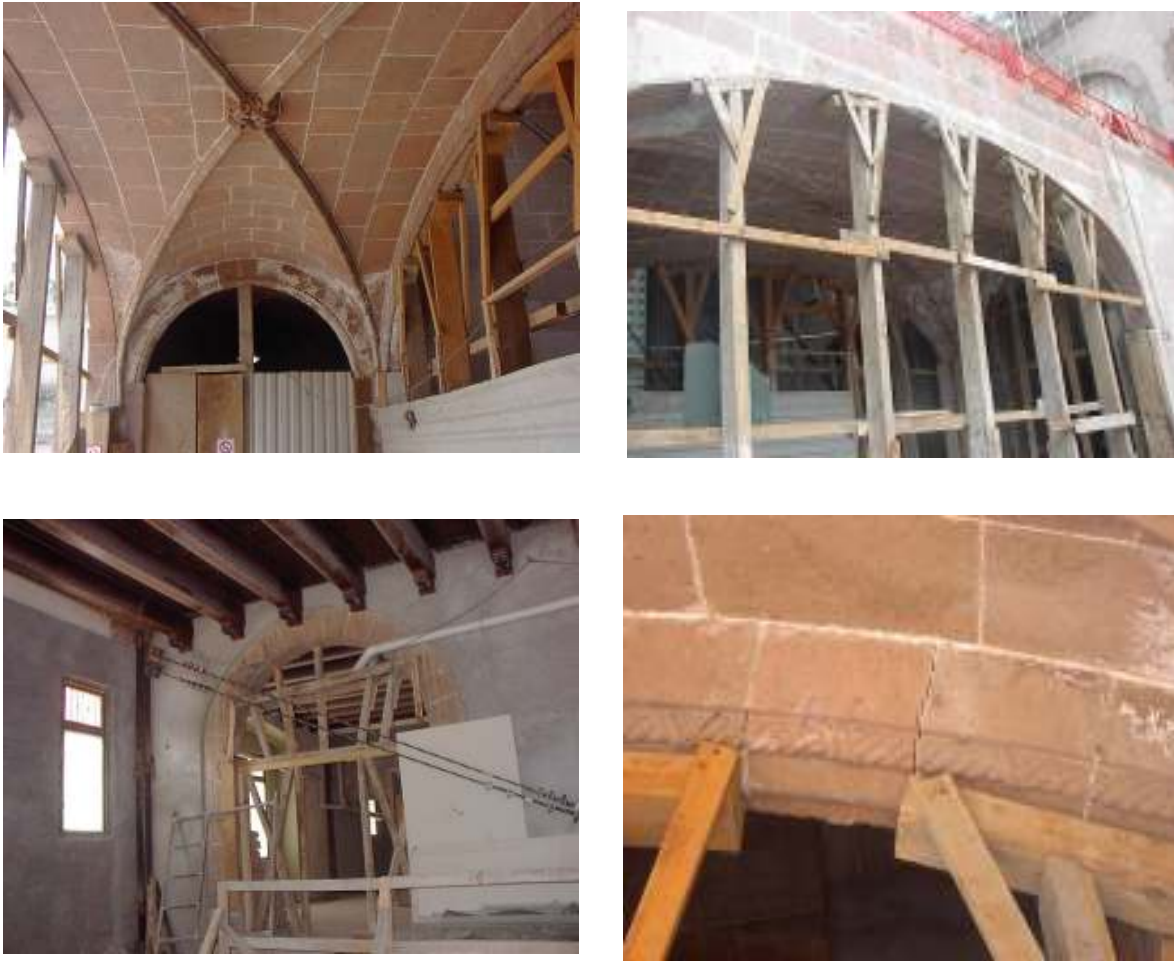
Figura 19. Apuntalamiento de arcos para evitar deformaciones.
