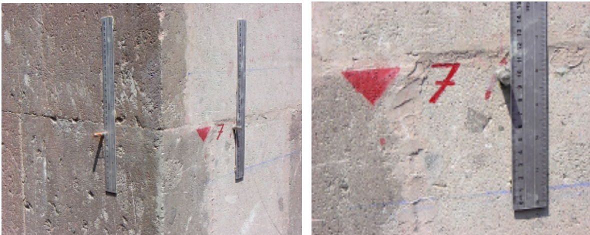
Figura 58. Reglas metálicas colocadas perimetralmente.
