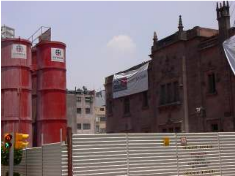
Figura 10. Fachada Poniente sobre Río Elba.
