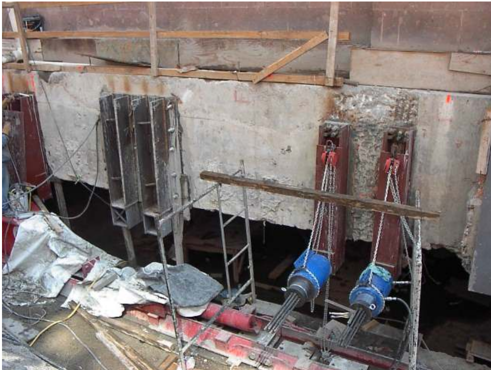
Figura 51. Tensión aplicada a cables de presfuerzo.
