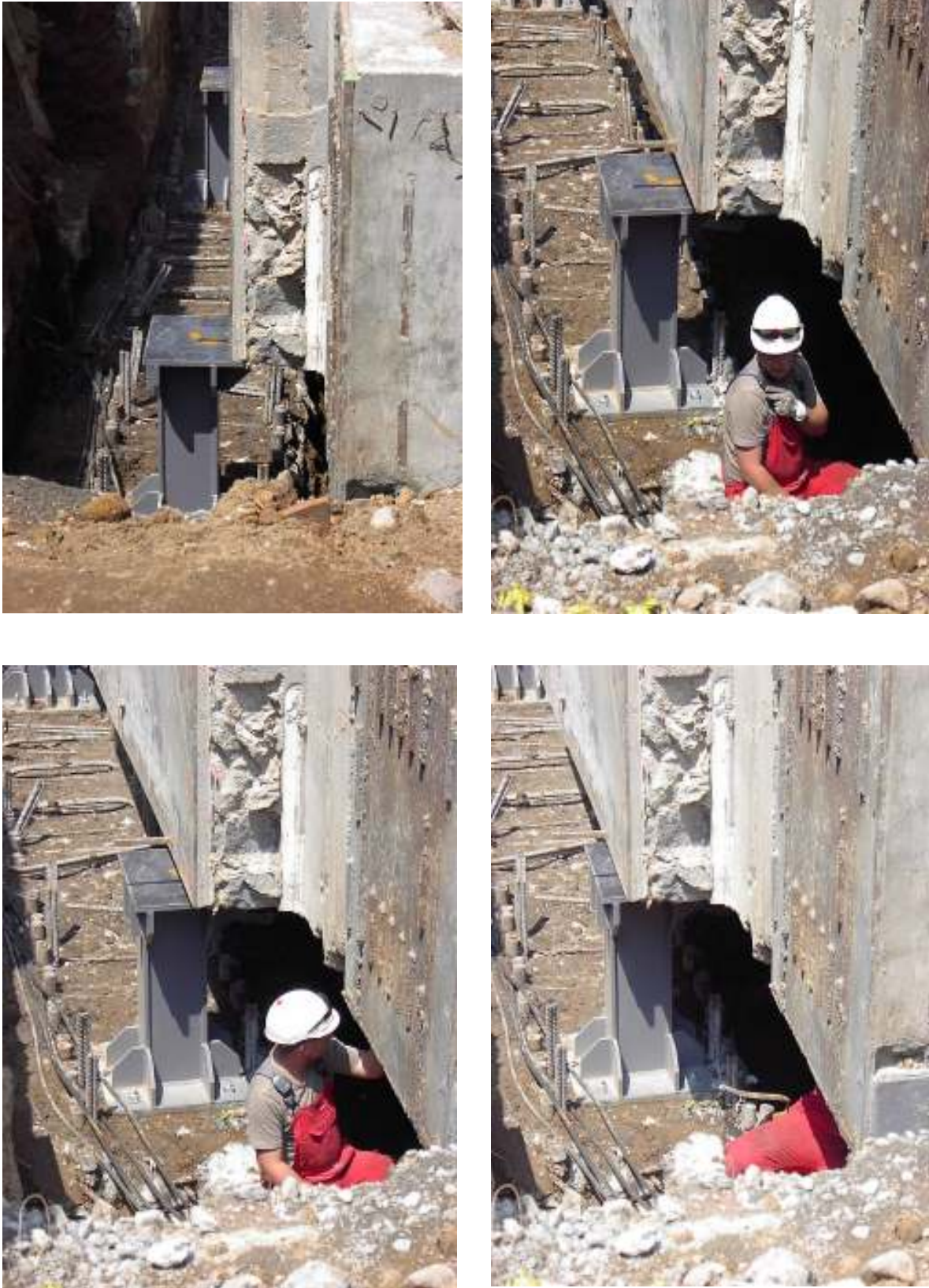
Figura 71. Muestra el avance de la casa tomando como referencia el apoyo metálico.
