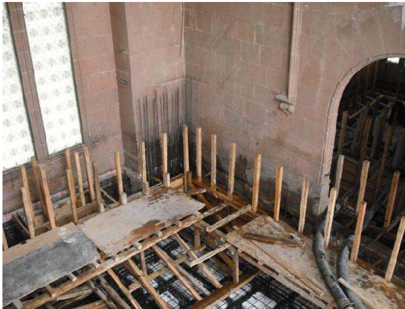
Figura 22a. Aligeramiento de losa empleando casetones de poliestireno.
