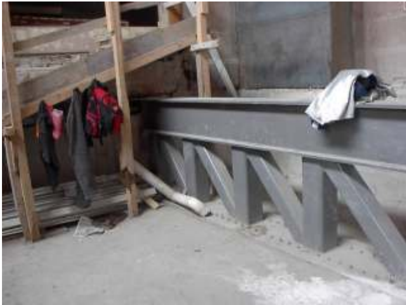
Figura 14b. Empleo de armadura y viga de acero para rigidizar el marco y sujetar tensores.
