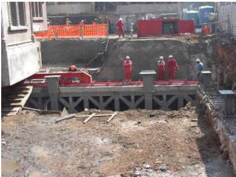
Figura 65. Personal de Ale Heavylift, con overol rojo, encargados de regresar la casa a su sitio original.
