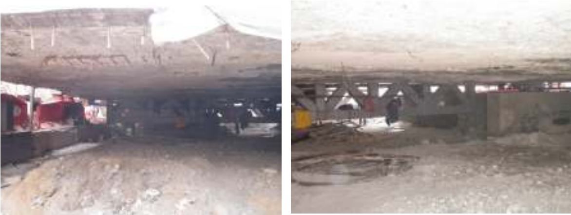
Figura 49a. Armadura metálica para controlar agrietamientos colocada debajo de la casa de oriente a poniente.
