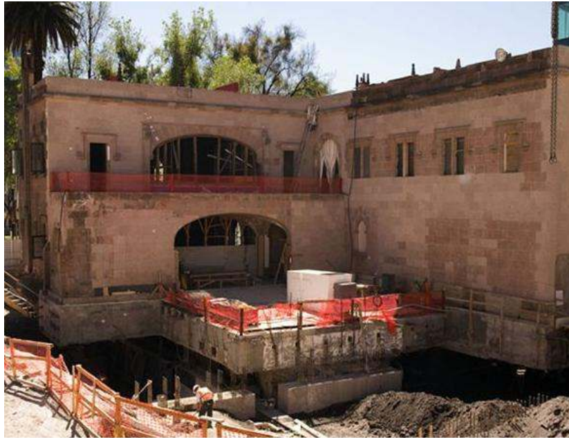
Figura 20. Charola de concreto (losa nervada) que sirvió para rigidizar la cimentación.
