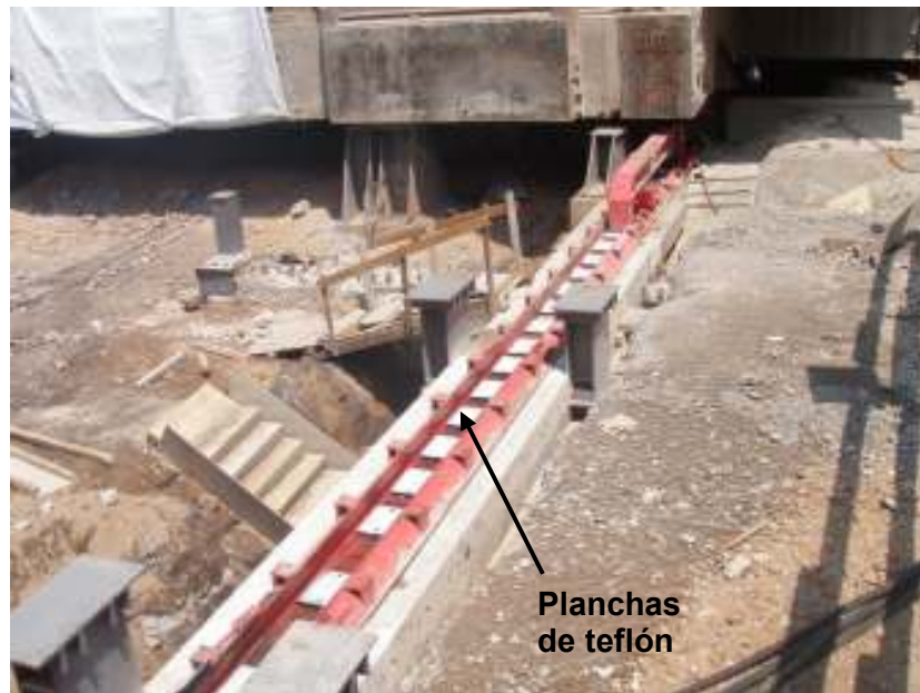
Figura 33a. Base horizontal para apoyar los carriles, observe sobre el carril el arreglo de las planchas de teflón.
