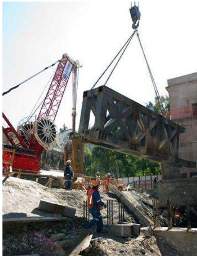
Figura 26a. Izaje de armadura metálica.
