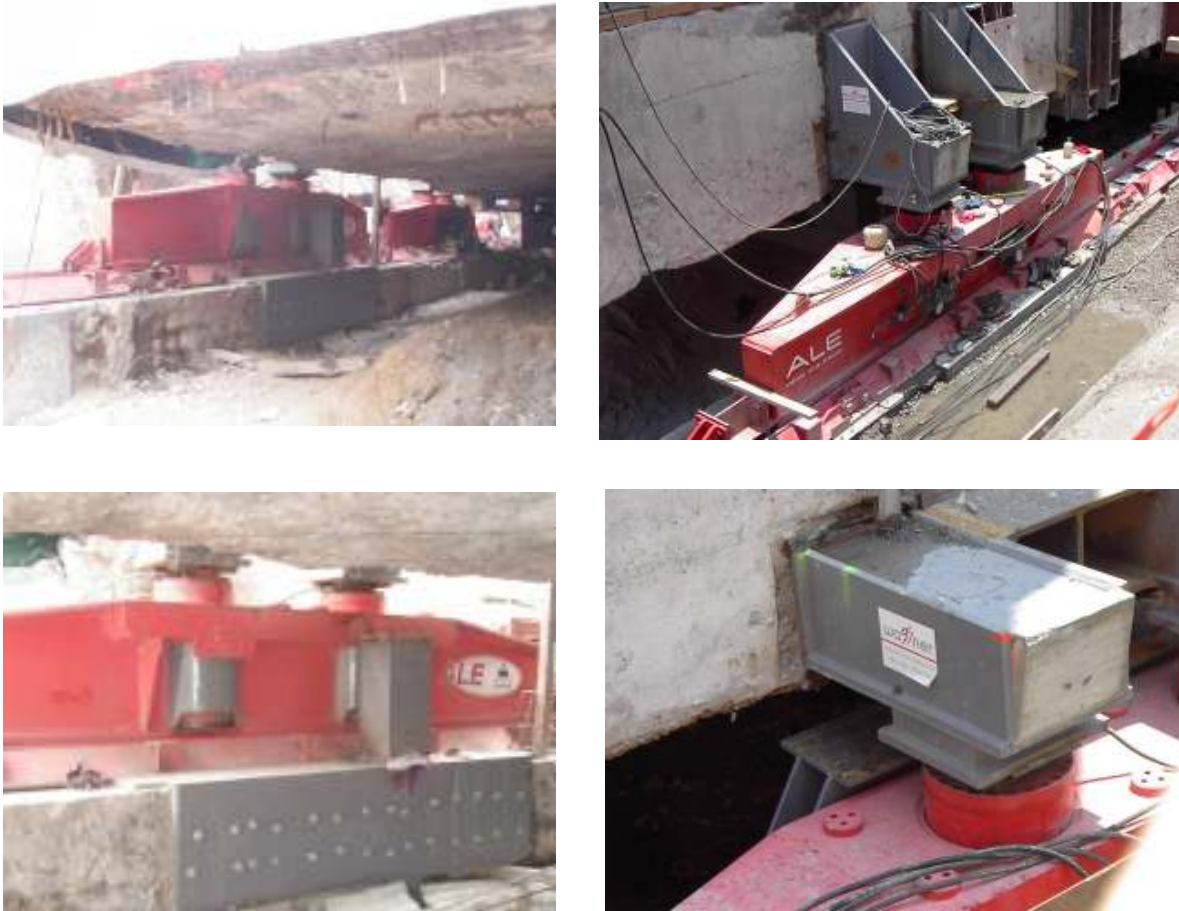
Figura 34. Transmisión de carga hacia los gatos hidráulicos.
