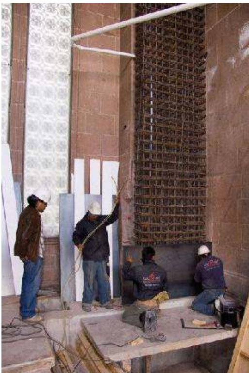
Figura 16b. Reforzamiento de muros con concreto armado y placa metálica.
