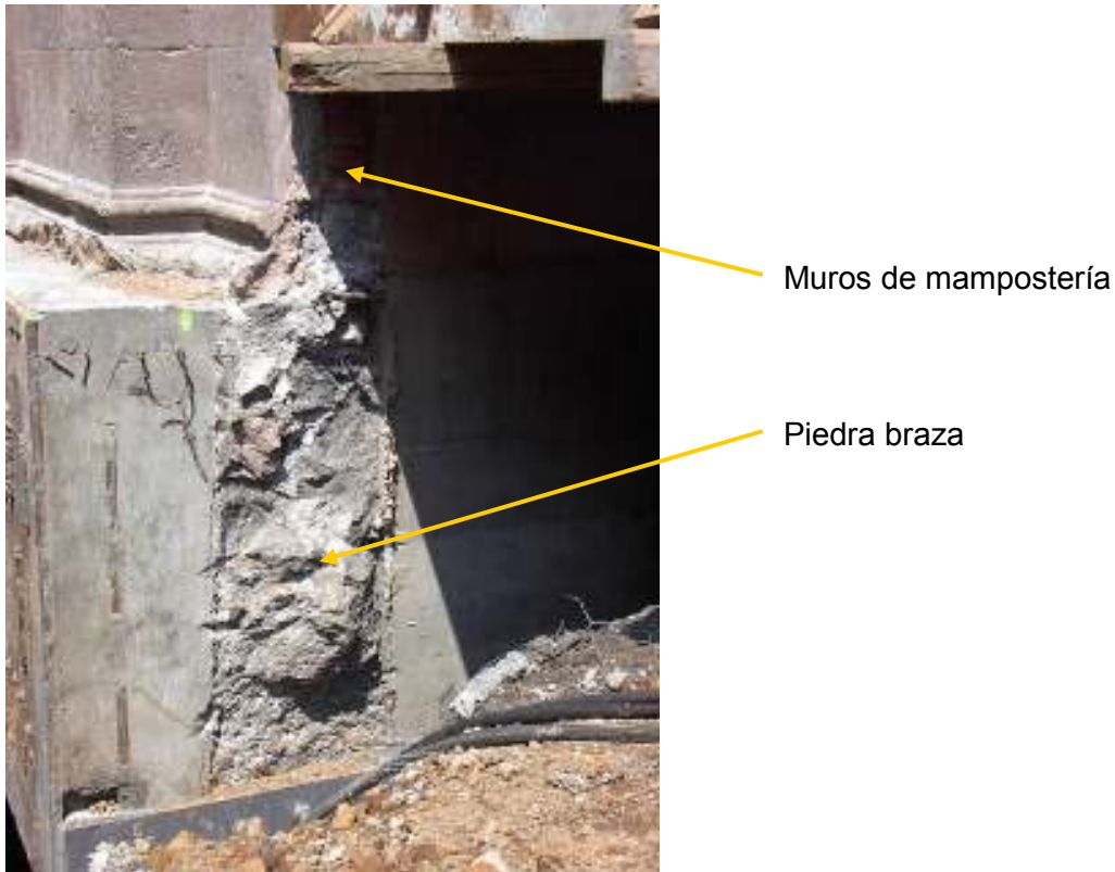
Figura 12. Cimentación original de la casa.
