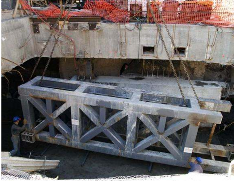
Figura 26b. Maniobras para bajar la armadura bajo la casa.
