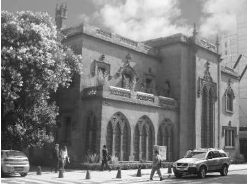
Figura 6. Detalle de la casa catalogada donde se observa su arquitectura.
