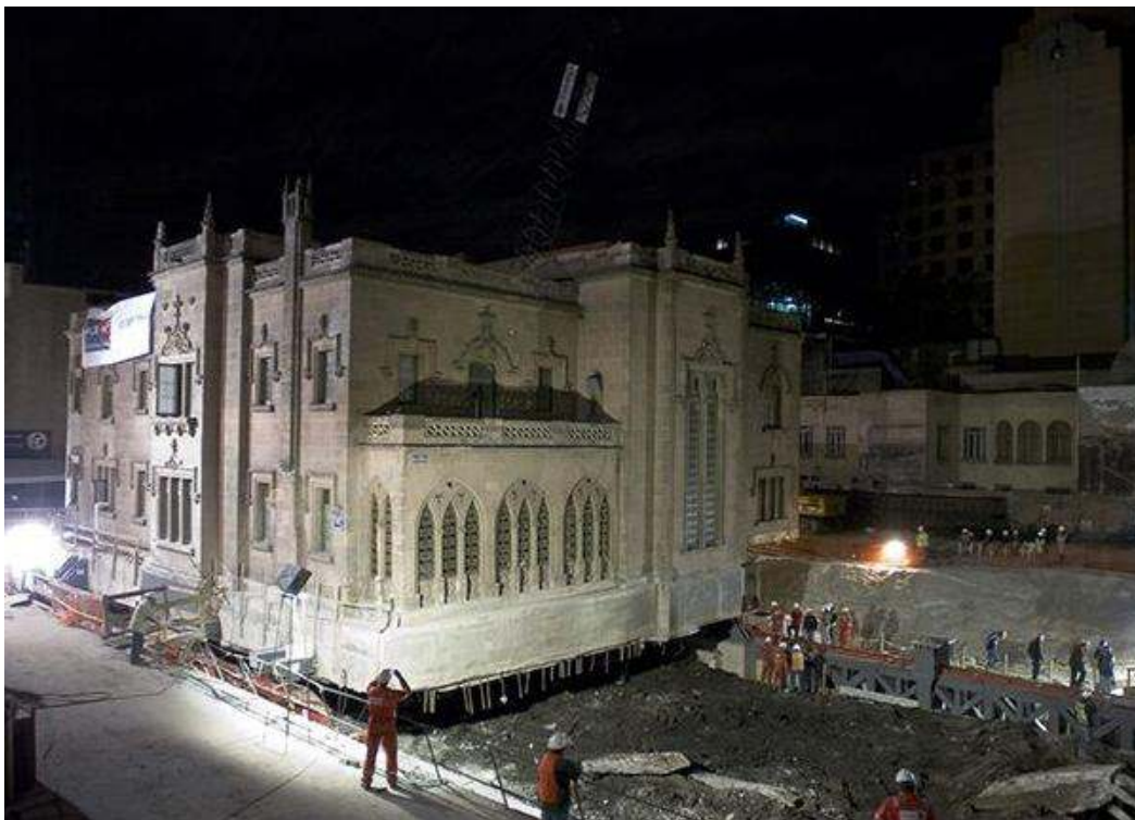
Figura 37b. Desplazamiento inicial de la casa efectuado el 13 de febrero de 2010.
