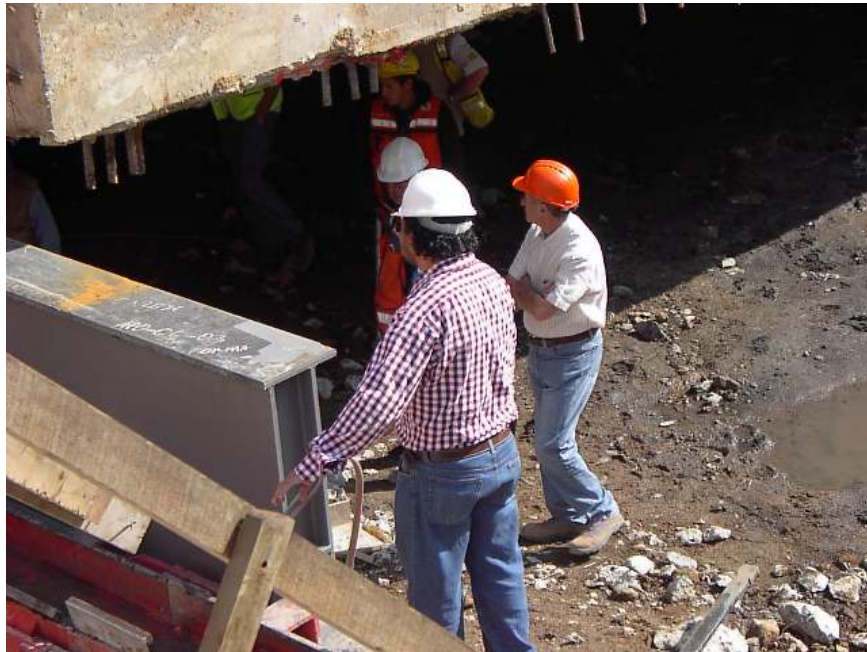
Figura 62. Inspección previa bajo la casa antes de su movimiento.
