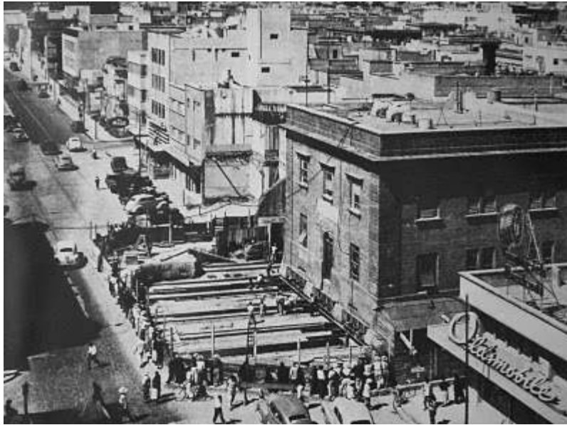
Figura 1. Desplazamiento del edificio de teléfonos en Guadalajara, Jal.
