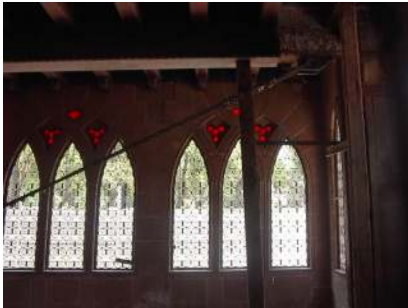
Figura 13. Tensores para rigidizar la estructura.
