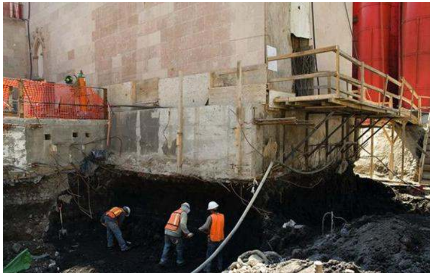
Figura 31a. Excavación a mano bajo la casa.
