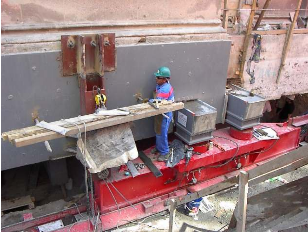
Figura 53. Obsérvese placa metálica para rigidizar la estructura.
