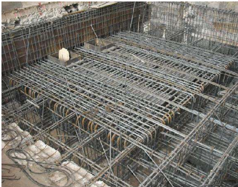
Figura 21a. Detalle de armado en losa de recimentación.
