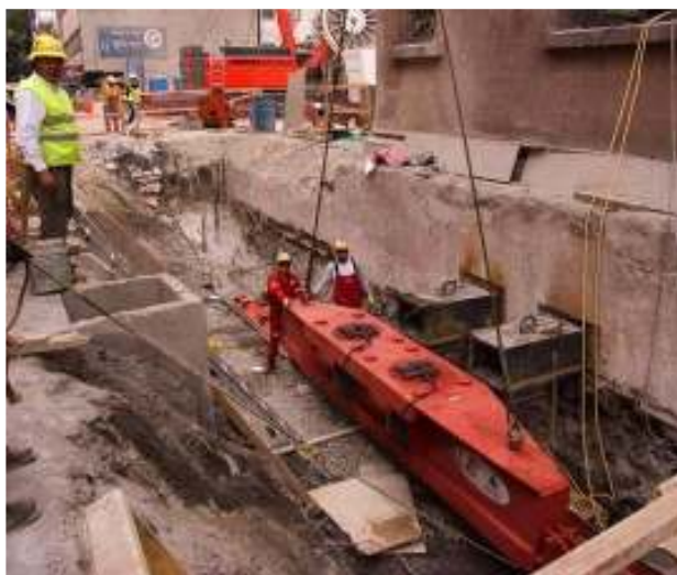
Figura 32a. Descenso de Skidshoe para desplazarse sobre el carril.
