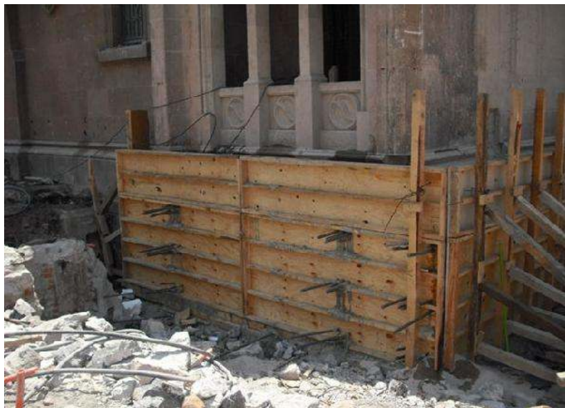
Fig. 23c. Detalle de la cimbra de contacto requerida.
