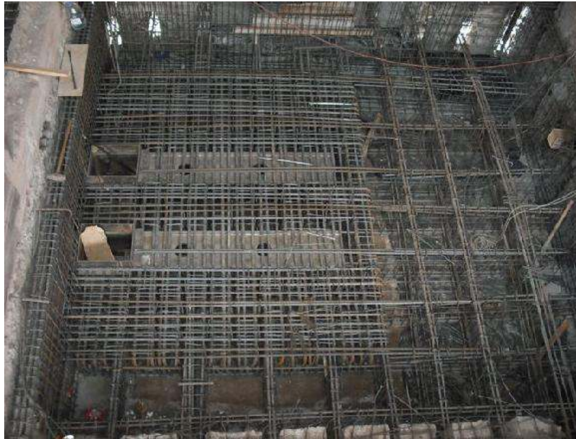
Figura 21b. Detalle de armado en losa de recimentación.
