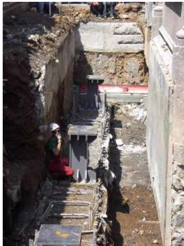
Figura 72. Escasos metros para concluir el movimiento de regreso de la casa.
