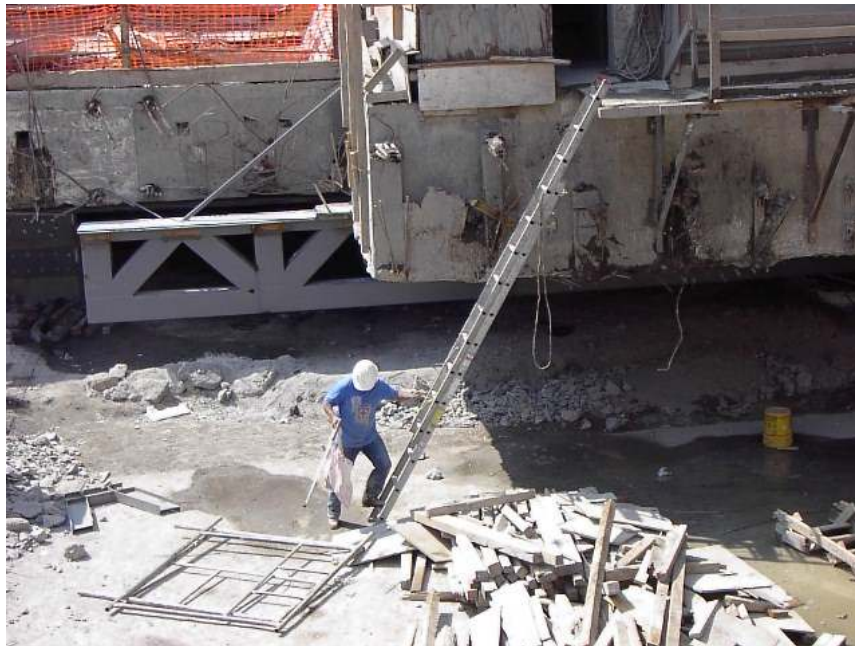
Figura 49b. Armadura metálica vista desde el exterior de la casa.
