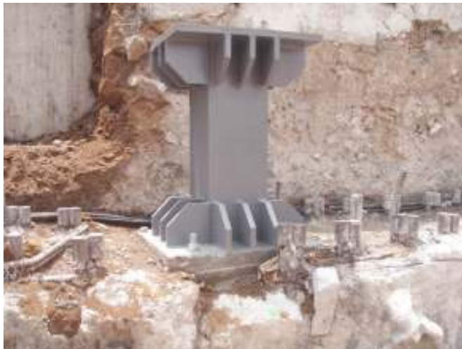
Figura 63c. Apoyos metálicos perfectamente alineados y listos para recibir la estructura.
