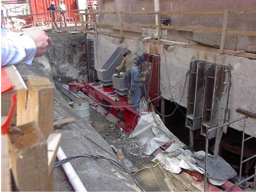
Figura 50. Preparativos para colocación de cables de presfuerzo, vista fachada poniente.
