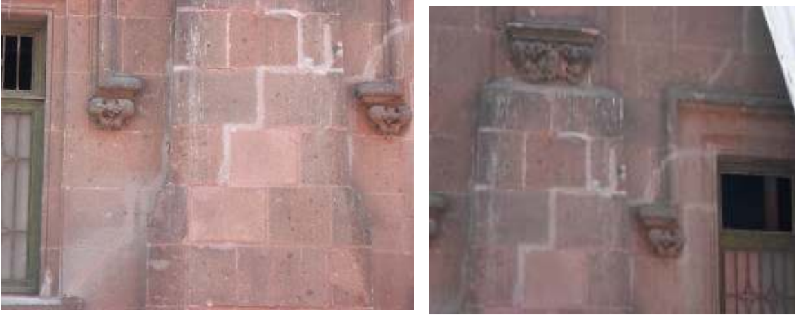
Figura 48. Reparación de agrietamientos mediante mortero.
