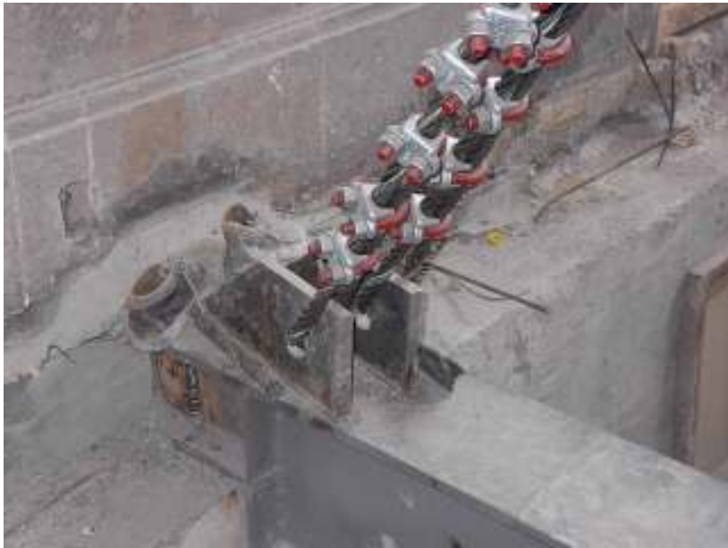
Figura 15. Unión de mensulas a armadura para sujetar tensores.
