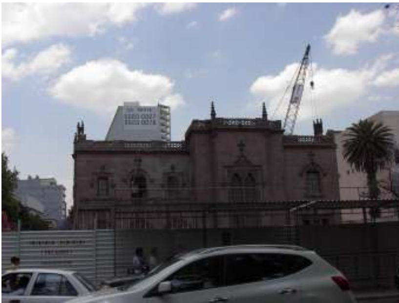
Figura 7 . Fachada Sur sobre Av. Reforma.
