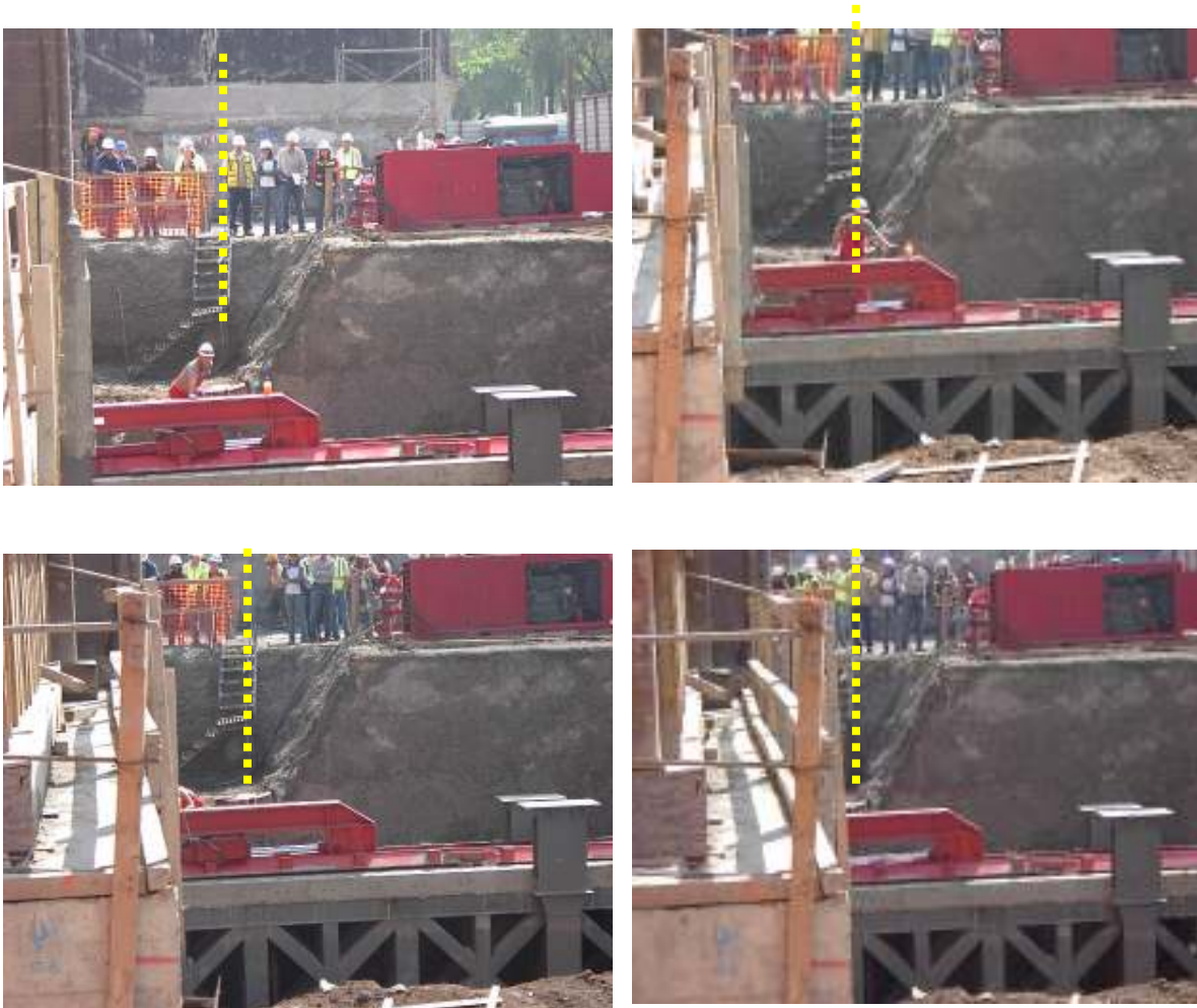
Figura 66. Secuencia donde se aprecia el movimiento de la casa tomando de referencia uno de los bordes de la escalera.
