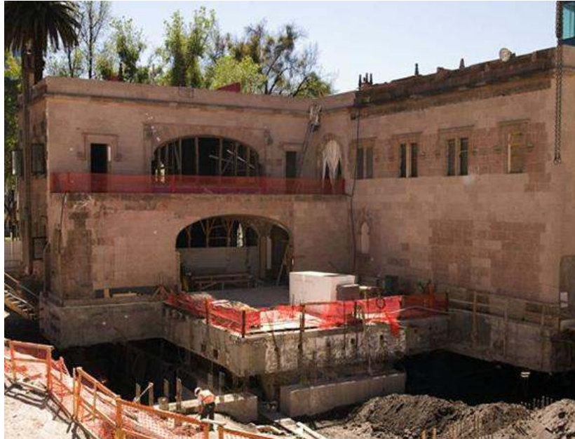
Figura 27a. Se observa uno de los ejes donde se colocó en algunas zonas el sistema de armaduras.
