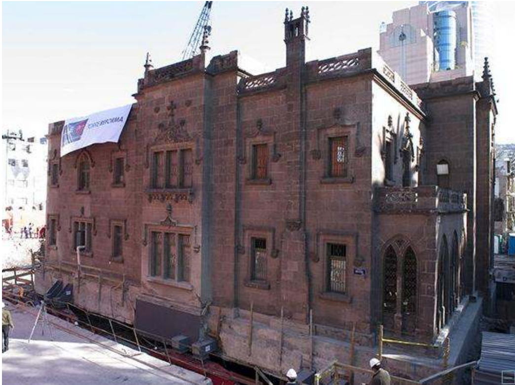
Figura 37a. Ubicación de la casa, antes de su movimiento.
