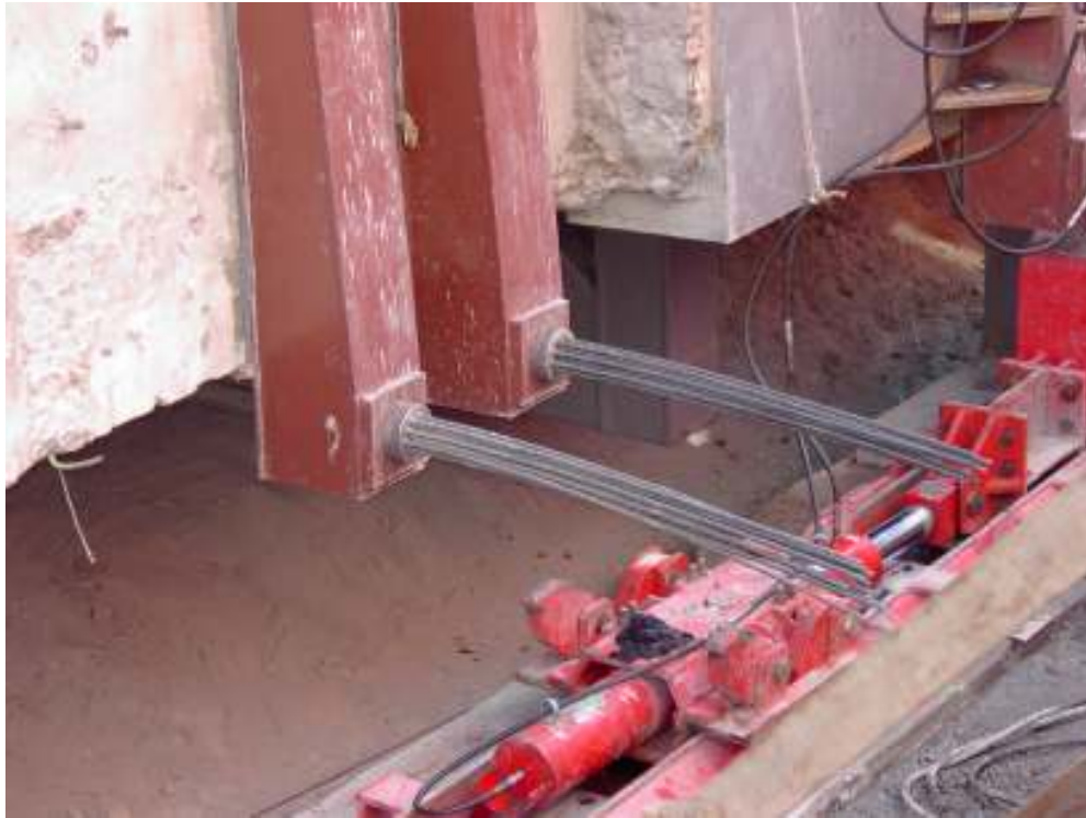
Figura 52. Cables de presfuerzo terminados.
