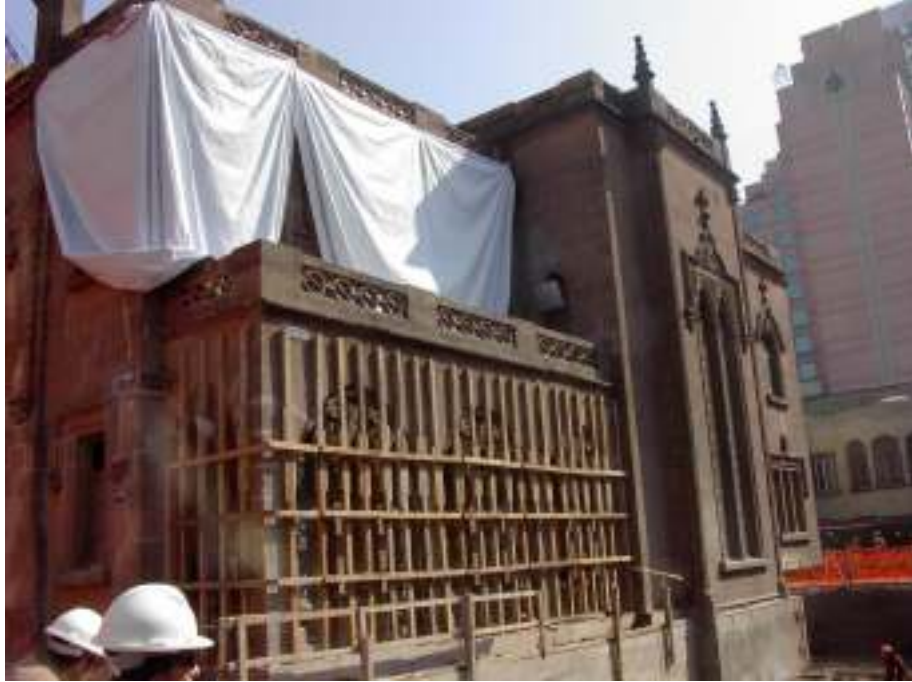
Figura 60. Apuntalamiento en fachada sur.
