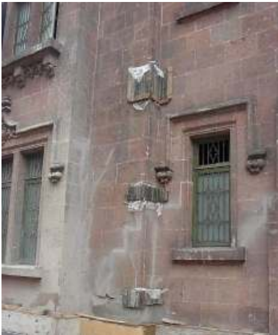
Figura 61. Placas y elementos metálicos para rigidizar fachada.
