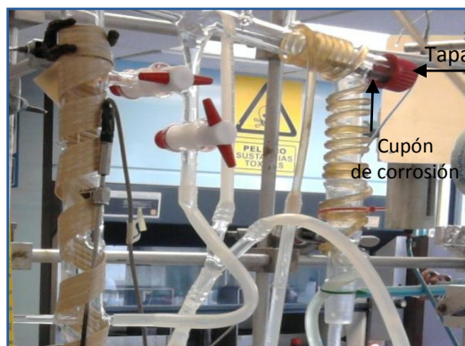
Figura 3.5 Ubicación del cupón de corrosión en la línea de domo
