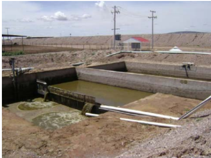
Figura 2.14 Construcción del digestor Granja Delicias, Chihuahua.
