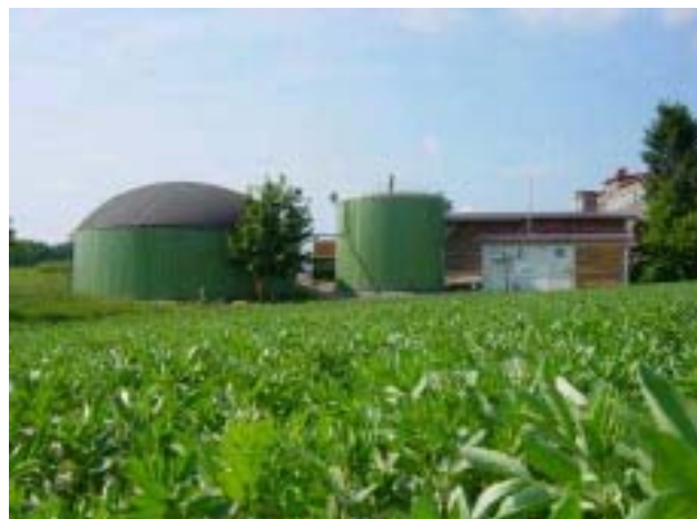
Figura 3.9 Planta de biogás en Alemania, procesadora de estiércol de cerdo [5].
