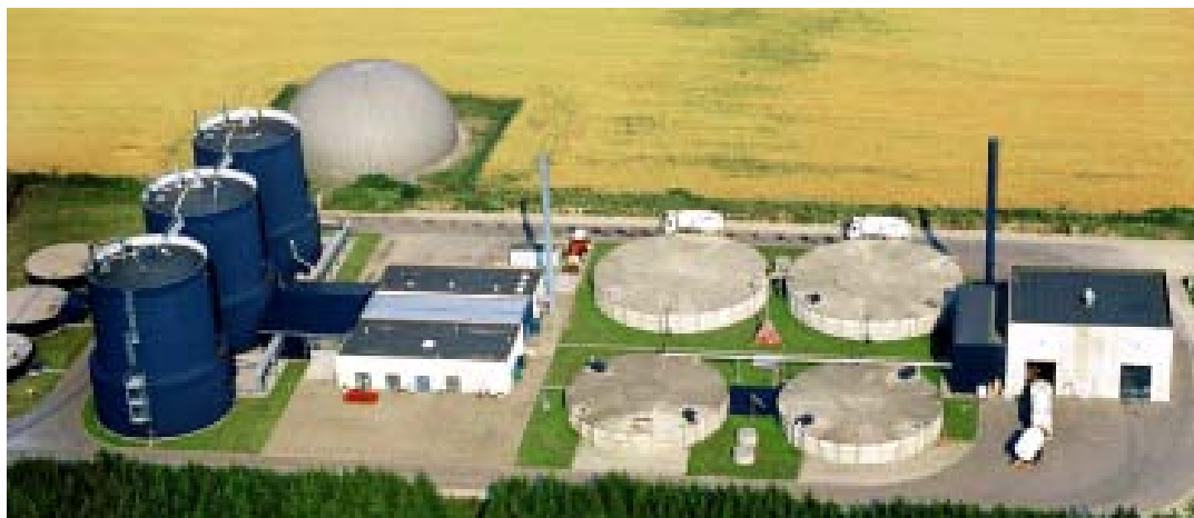
Figura 3.10 Planta de biogás en Dinamarca [5].
