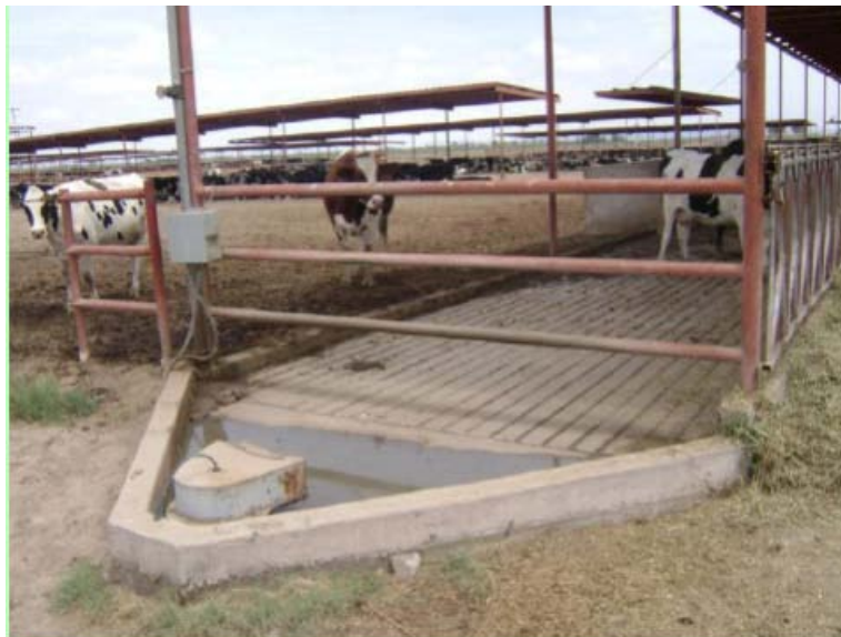
Figura 2.12 Sistema de captación de residuos vacunos. Torreón
