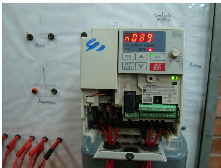
Figura 5.24.2 Función para escoger el porcentaje de inyección de cc
