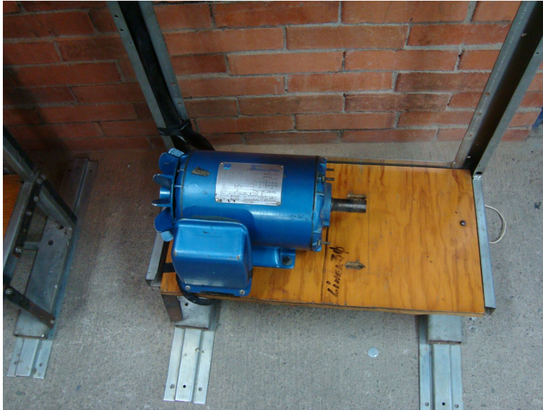
Figura 5.24.5 El motor continúa girando después del tiempo de desaceleración debido a la inercia del rotor
