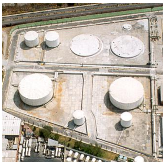
Figura 4.8 (fotografía aérea de los tanques de almacenamiento)
