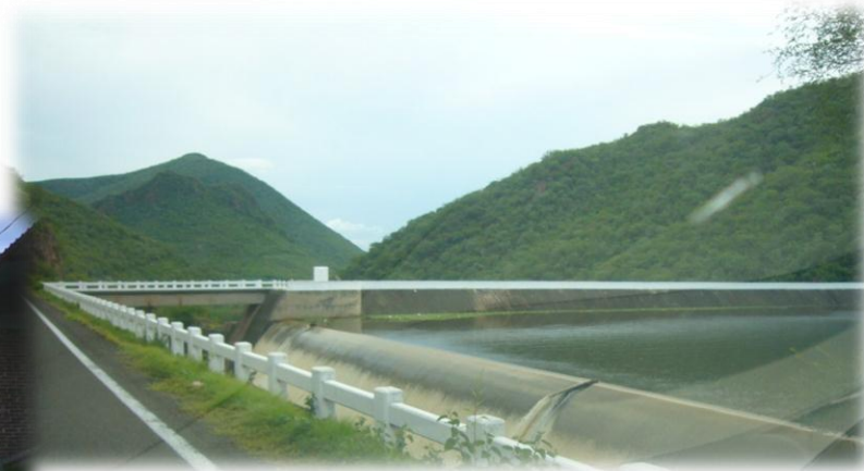
Estructura de la presa de Zicuirán localizada a 15 kilómetros de la población de la Huacana. ▲
