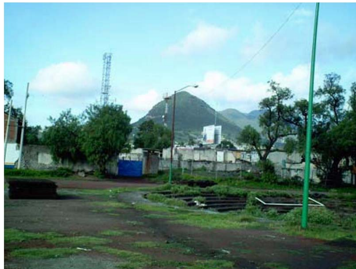
Crecimiento desordenado de la mancha urbana.
