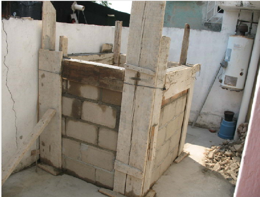
Figura 5.2.1 Construcción del aljibe.
