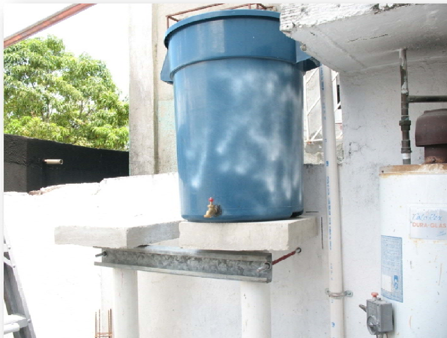
Figura 5.3.1 Tanque para filtro predecantador-aereador
