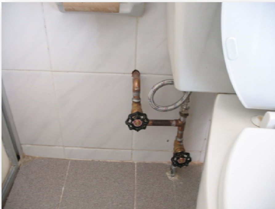
Figura 5.7.1 Tubería de conexión a retrete.
