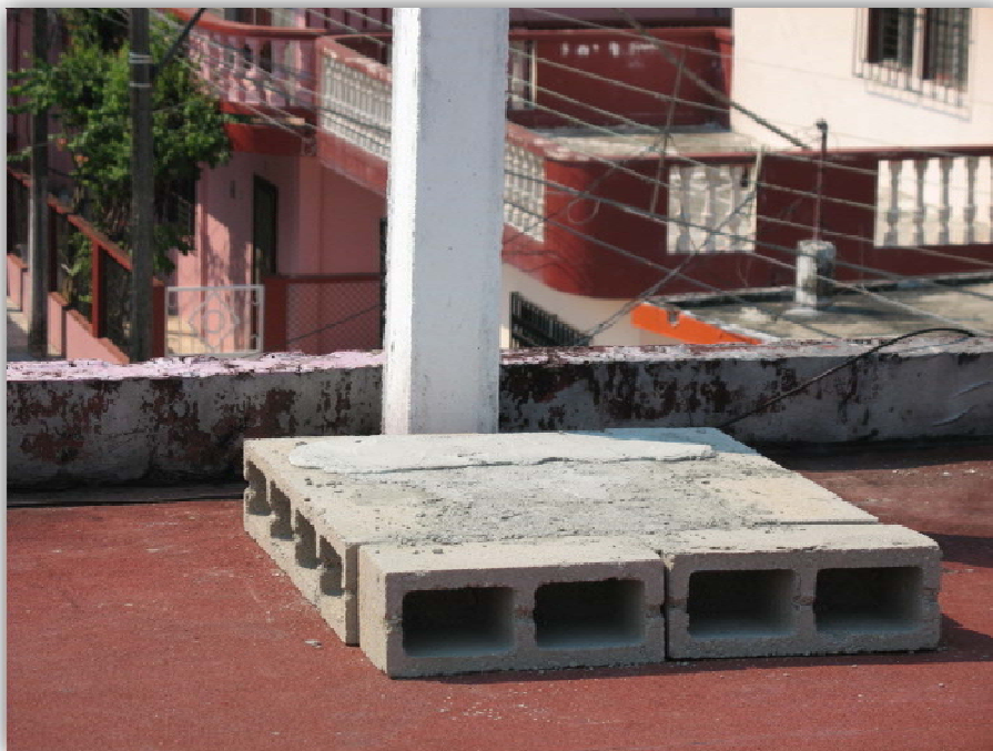
Figura 5.2.2 Construcción de base para tinaco.
