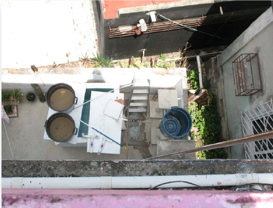
Figura 5.7.2 Vista superior de aljibe y filtros de arena.
