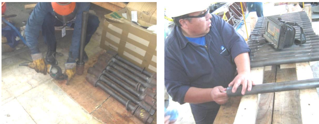
Figura 3.7. Limpieza de pernos de brida de tubos espaguetis
