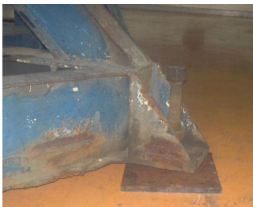
Figura 3.23. Se nivela perfectamente la altura de los rodillos de balanceo
