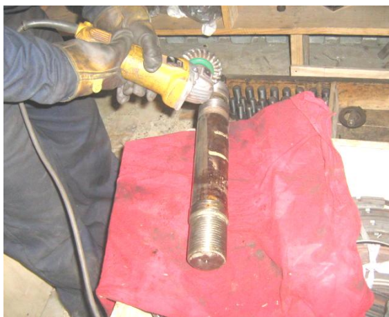
Figura 3.8. Limpieza de pernos de brida de válvulas de paro.
