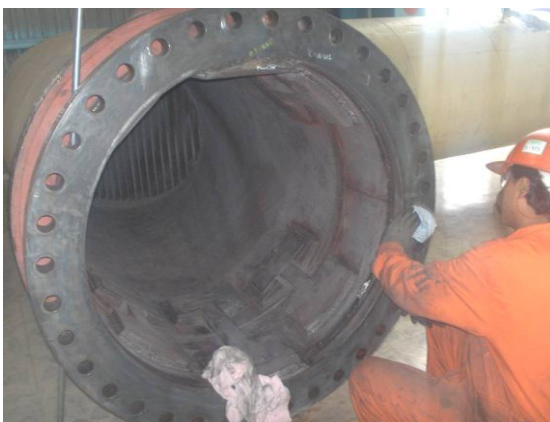
Figura 3.9. Limpieza de bridas
