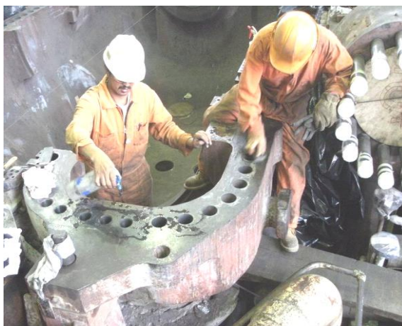
Figura 3.1. Inspeccion visual de la carcasa
