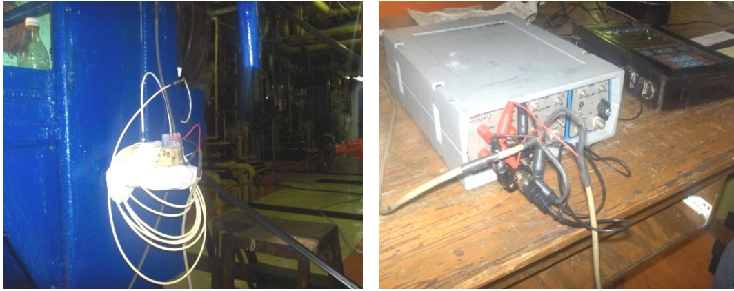
Figura 3.25. Instalacion de sensores de desplazamiento, tacometro y analizador de vibracion
