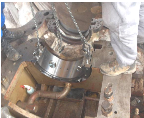
Figura 3.18. Montaje de chumacera
