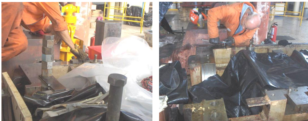
Figura 3.10. Limpiar y pulir junta horizontal y vertical
