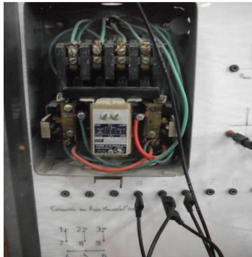
**Fig.3. 48** Bobina de control del segundo arrancador
