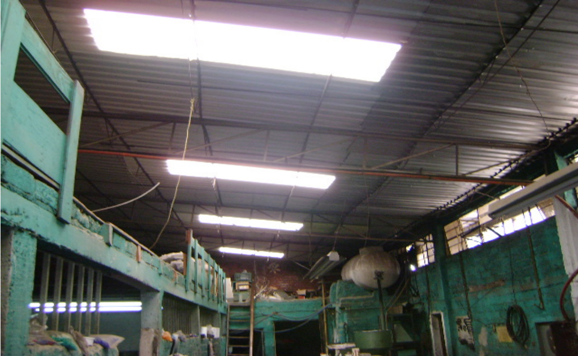
Foto 4.5. Se muestra como la empresa utiliza luz natural por medio de láminas traslucidas.
