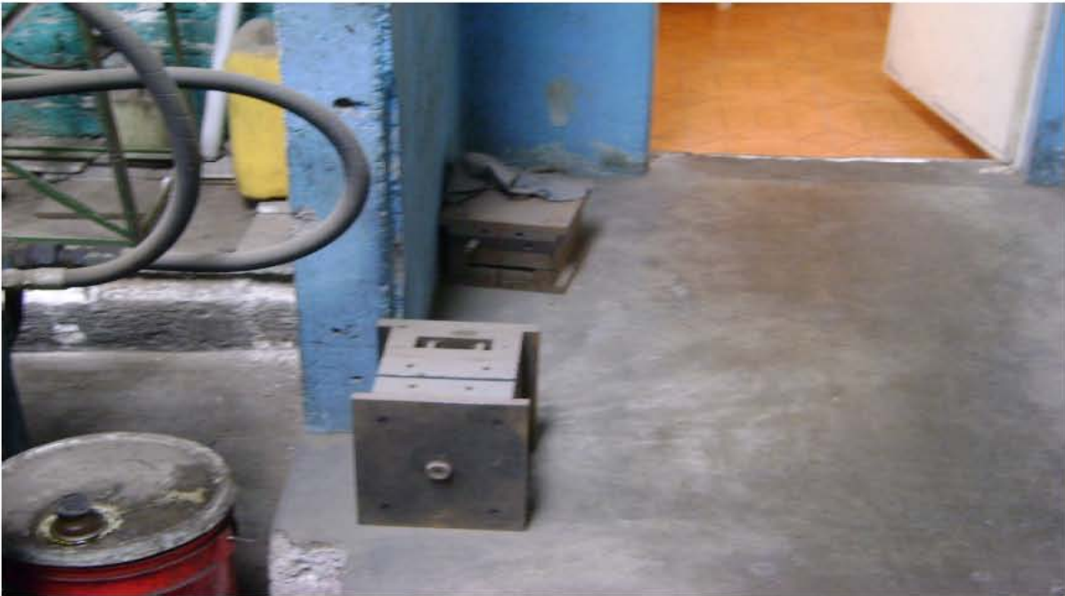
Foto 4.8 Algunos objetos en el piso representan riesgos.
