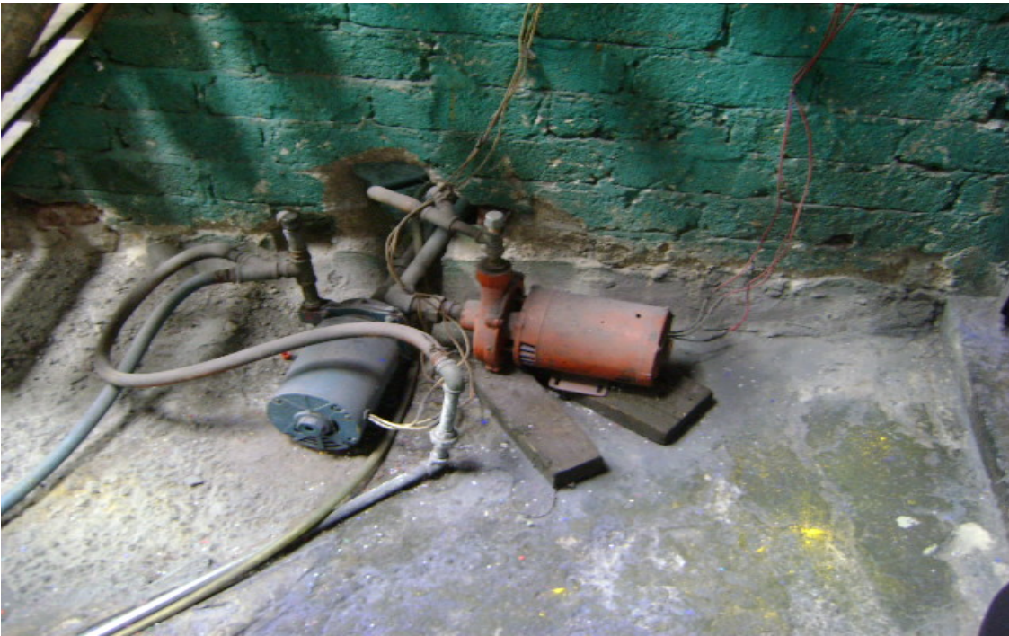
Foto 4.13. Bombas de agua en el piso con mangueras sin protección en el piso.
