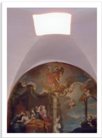
6. Domo sobre un pasillo
