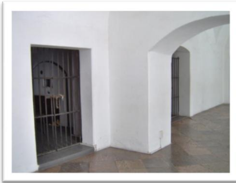
1 .Cava y frigorífico
