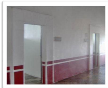
6. Sanitarios del Mirador
