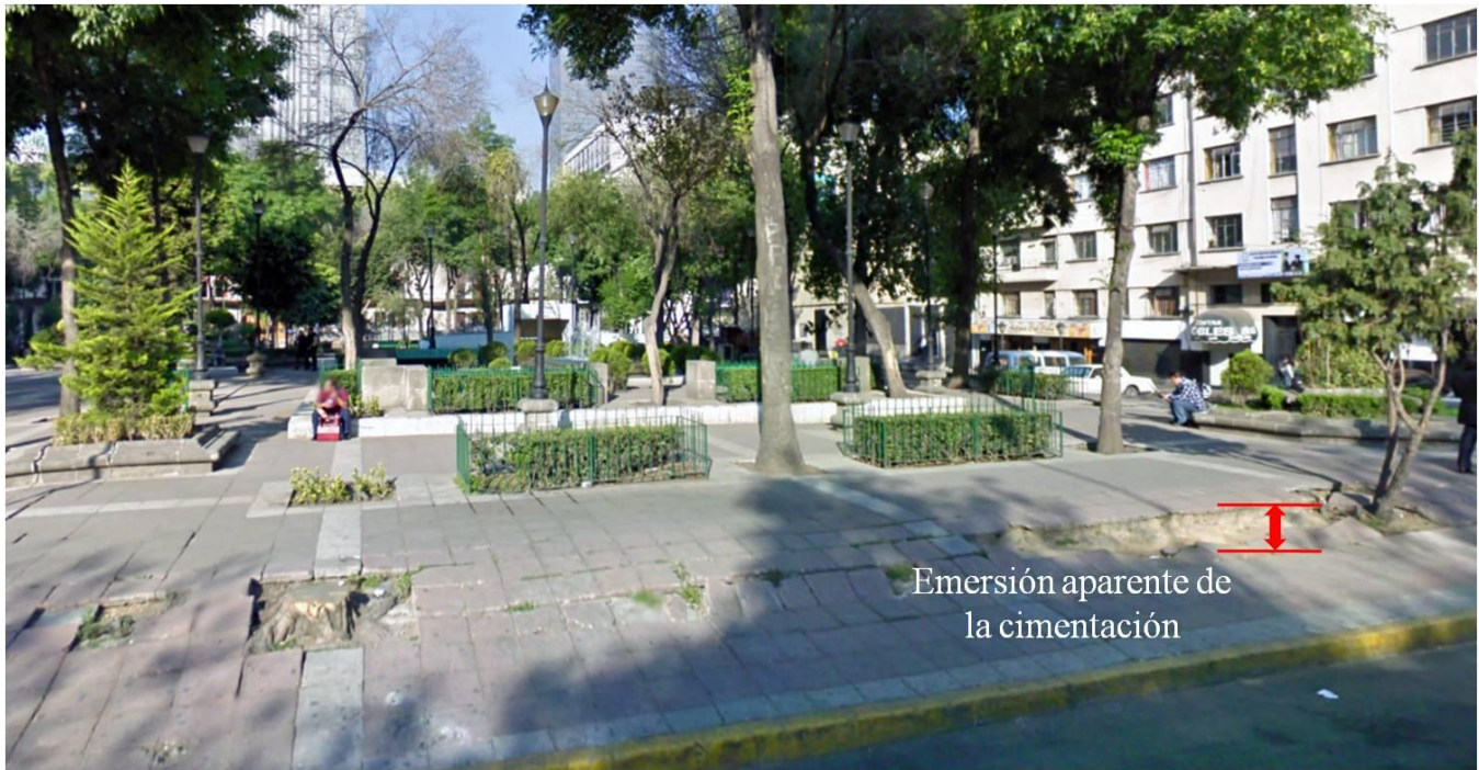
Figura 2.63. Emersión aparente de la cimentación del antiguo Hotel Regis.
