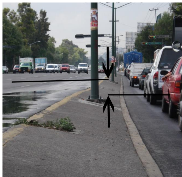
Figura 2.44. Calzada Vallejo, en donde se observa la emersión de los rellenos de la calzada prehispánica.
