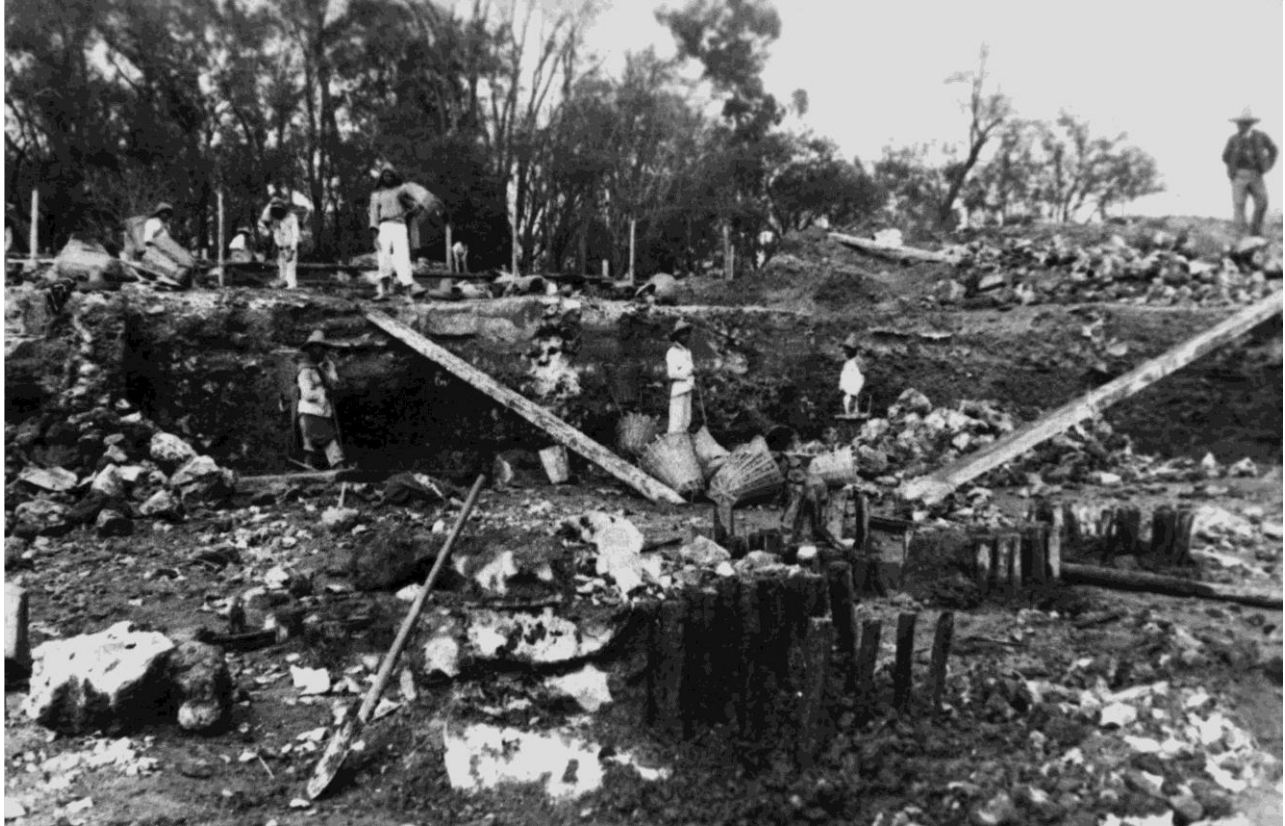
Figura 2.60. Construcción del Palacio de Bellas Artes en donde se encontraron los vestigios de una cimentación colonial, 1904.
