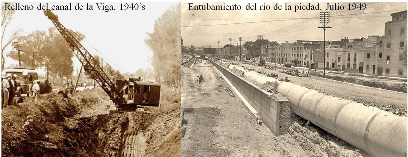
Figura 2.58. Relleno y entubamiento de canales a mediados del siglo XX.
