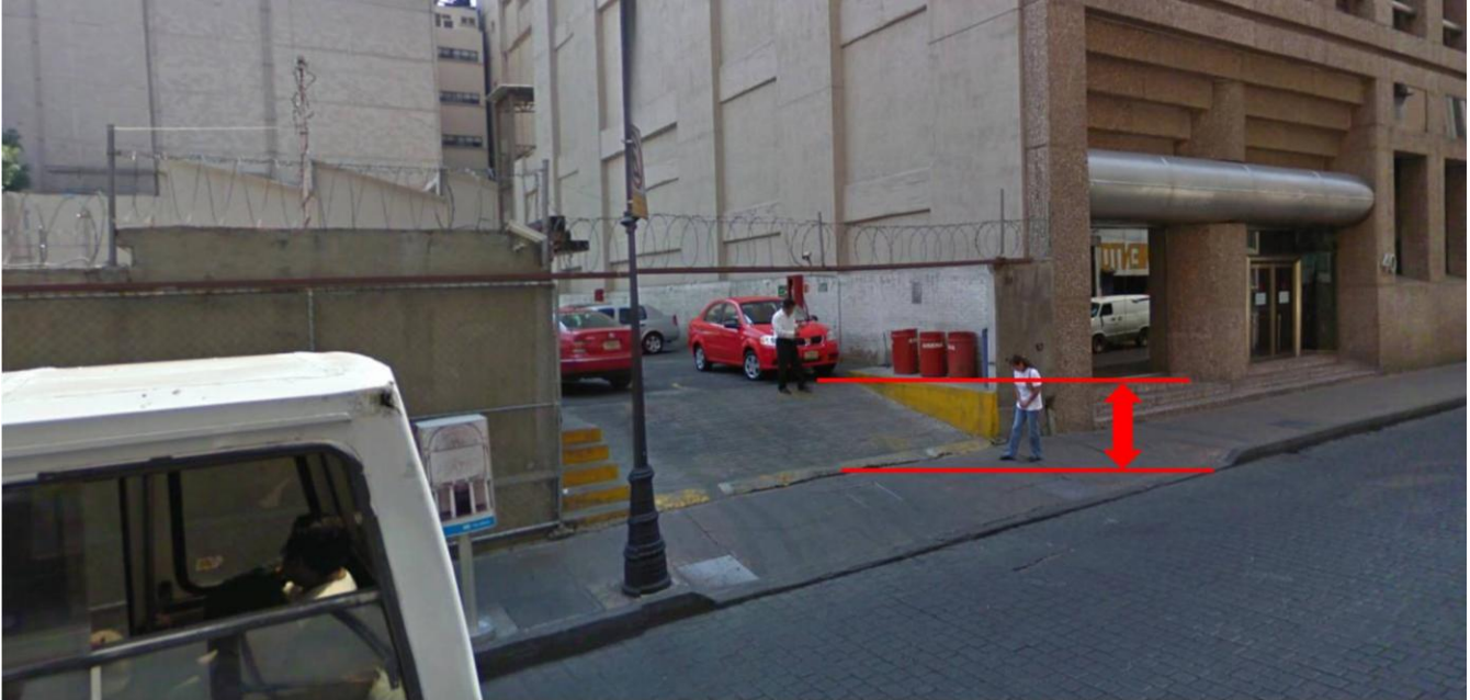
Figura 2.67. Emersión aparente de una cimentación abandonada en el centro de la ciudad.
