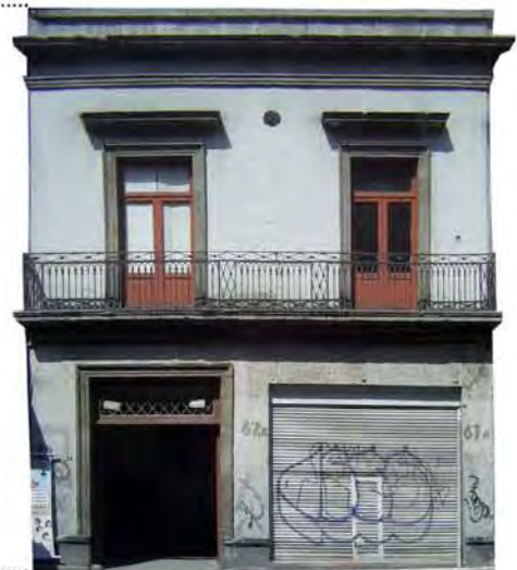
Fachada del edificio de estudio enfrentada al Oriente, ubicado sobre Isabel La Católica, en el Centro Histórico de la Ciudad de México
