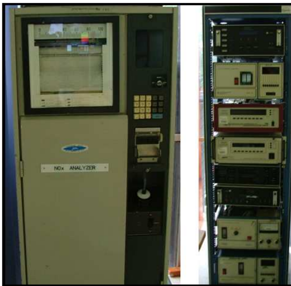
Figura 8. Analizadores de contaminantes de décadas anteriores, resguardados en las oficinas del SIMAT.
