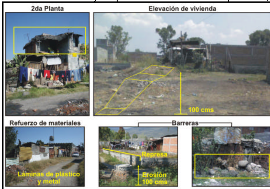
Figura 5.14 Modificaciones y adaptaciones en las viviendas precarias, MZGS
