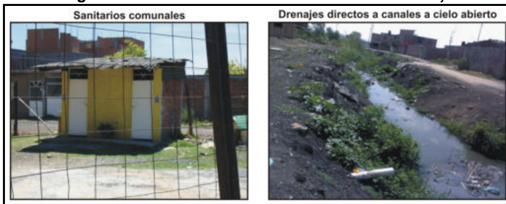
Figura 5.5 Sanitarios comunales sin conexión a drenaje
