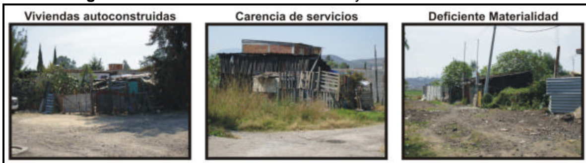
Figura 4.10 Viviendas auto-construidas y carencia de servicios
