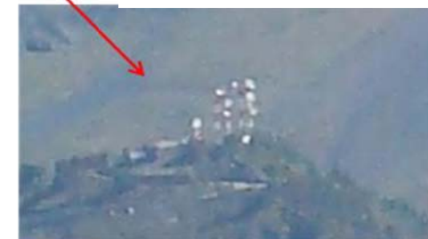
23. Antenas en Tlamacas
