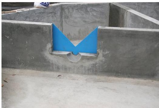
Fig 3.7 Vertedor triangular de pared delgada.
