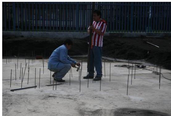
Fig 3.4 Nivelación de la varillas.
