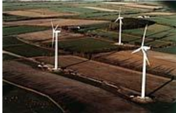
Ilustración 39. Torres de celosía © NEG-Micon A/S 1998
