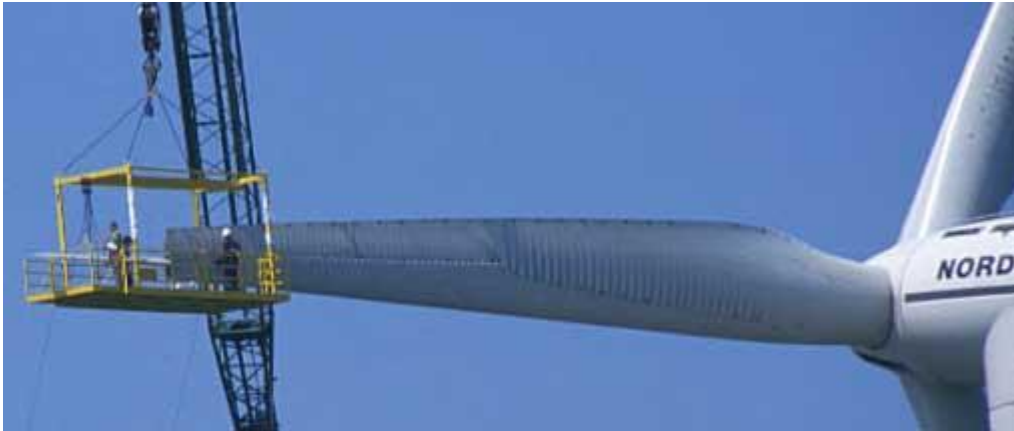
Ilustración 41. Personal de mantenimiento trabajando en una pala de 32 m de un aerogenerador de 1,5 MW Fotografía Christian Kjae© 2000 DWIA
