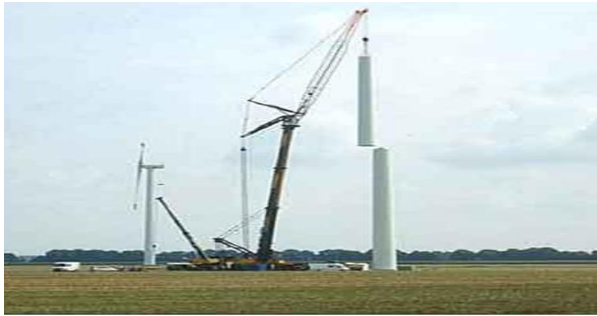
Ilustración 54. Momento de izado de las partes de la torre de un aerogenerador
