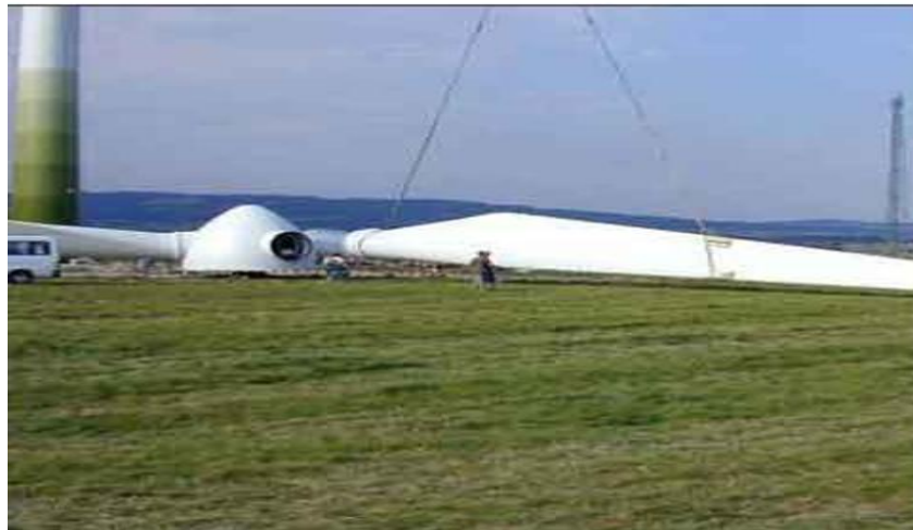
Ilustración 55. . Ensamblaje de las palas en el buje del rotor
