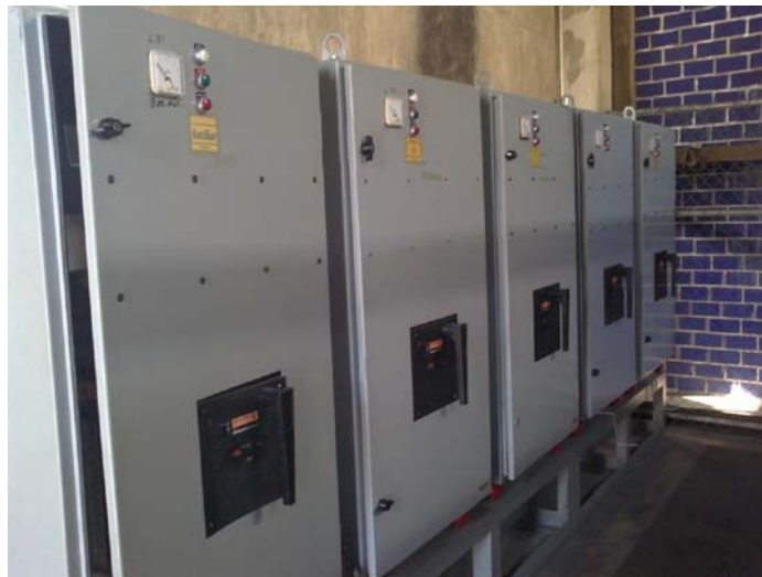
Fig. 2.13 Interruptores ultrarrápidos derivados.
