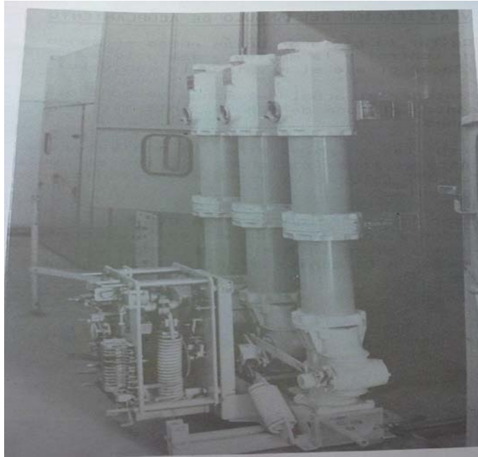
Fig.2.3. Interruptor de potencia en pequeño volumen de aceite.
