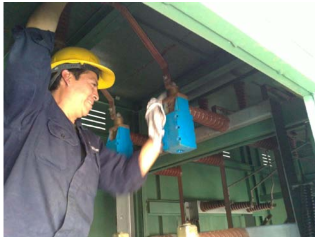
Fig. 3.8 Zona sin distancia de aislamiento porque se desconecta totalmente.
