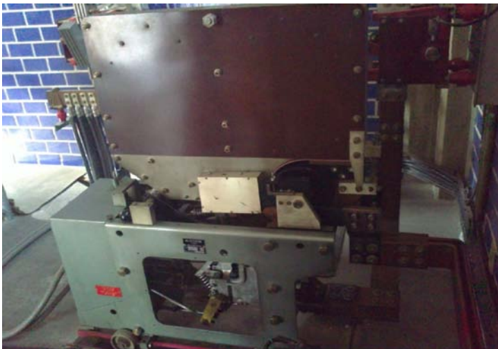
Fig. 2.12 Interruptor ultra rápido principal.
