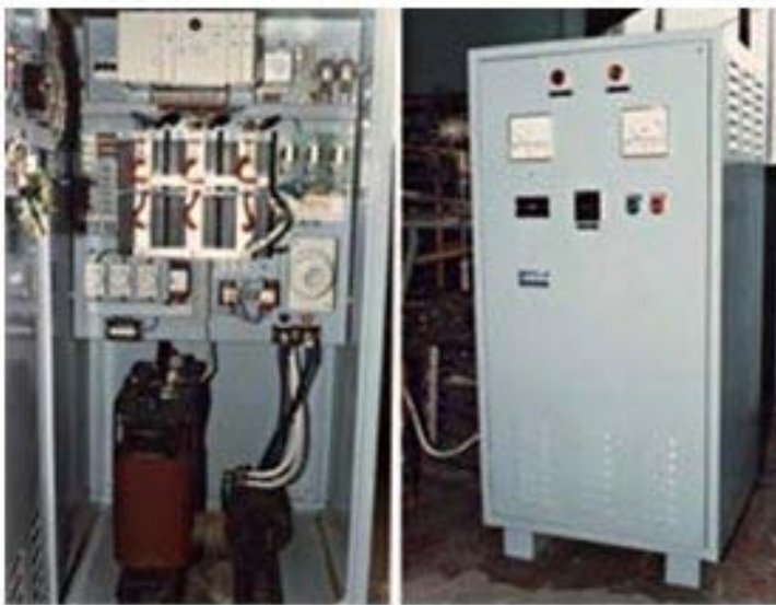
Fig.1.27 Cargadores de baterías.
