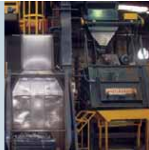
3.-Granallado: está compuesto por dos maquinas llamadas Wheelabrator que realizan un proceso de limpieza denominado samblaseado, que consiste en limpiar las piezas en mal estado dentro de una gran olla cuyo interior es de titanio, material que soporta la abrasión constante que produce el bombardear las piezas con un grano metálico.
