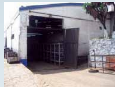
Vista de la salida de material terminado en embarque [Archivo personal].
