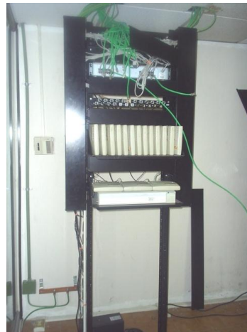
Fig. 94 Distribuidor RAS Modem
