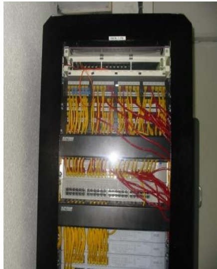
Fig. 86 Distribuidor Secundario
