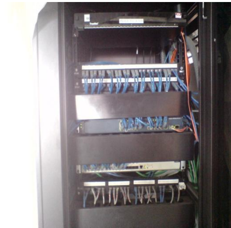
Fig. 81 Fibra óptica en distribuidor secundario
