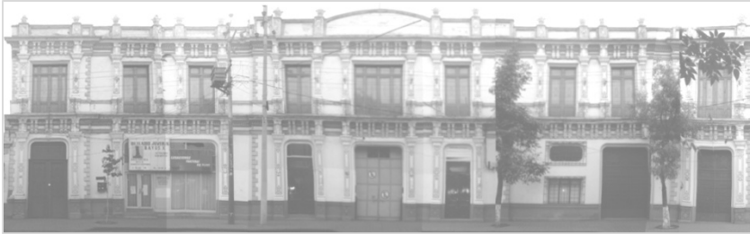
F53. Av. Villada 103-105-107 (antes calle de la Ley 4, 6 y 8) el proyecto consistió en la remodelación de las fachadas con la finalidad de unificarlas, ya que al interior se comunican entre sí. Actualmente este edificio es la sede del INAH Toluca.
