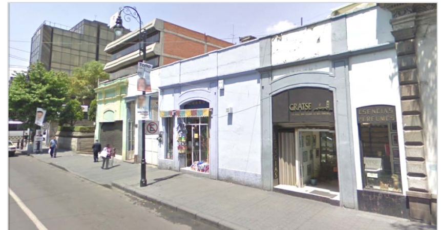
F59. Av. Villada esquina con Morelos, fachadas de la acera poniente. Observamos el predominio del sector terciario de la economía (referente a servicios), lo cual se repite a lo largo de la avenida.
