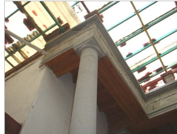
F84. En la mayoría de las casas los patios han sido cubiertos para ser protegidos de la intemperie con domos improvisados que dañan visual y estructuralmente a la construcción.
