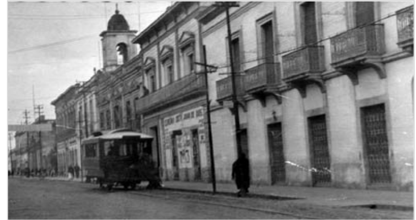
F32. Fachadas de Casas ubicadas en la primera manzana de la calle Ley, donde se observan las ventanas y balcones angostos y la inexistencia de elementos decorativos para bajadas de agua.
