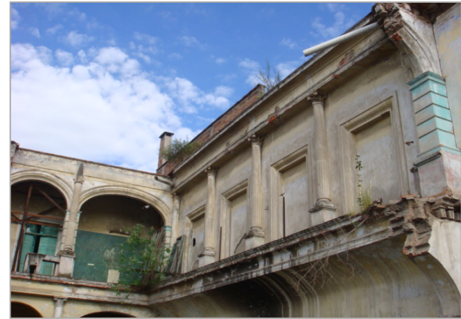
F88. Este inmueble poseía elementos como: columnas adosadas al muro y pilares que reciben la carga de los arcos. En dicho muro, orientado al sur se tienen cuatro ventanas ciegas.
