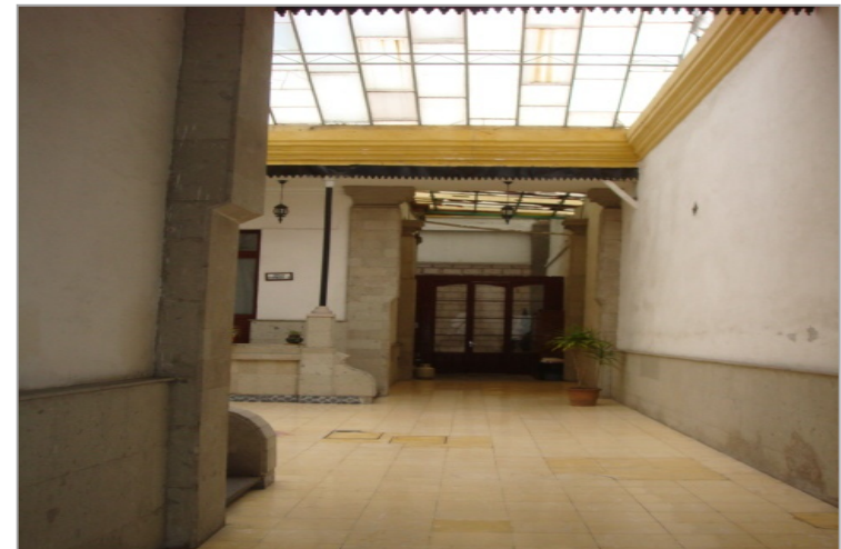
F93. En el patio lateral se encuentran elementos como el murete que enmarca las escalinatas para subir al nivel habitacional, sobre el cual se desplantan las columnas de hierro.
