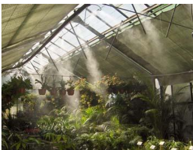
Fig. 2.17 Sistema de nebulización en un invernadero. 27
