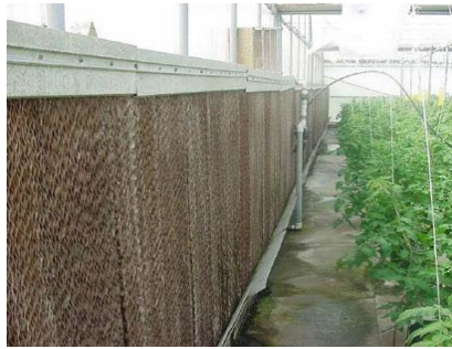
Fig. 2.18 Pantalla evaporadora colocada en un invernadero. 28
