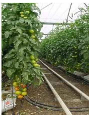
Fig. 2.7 Invernadero con cultivo de jitomate donde se muestran las tuberías de calefacción a nivel de suelo. 17
