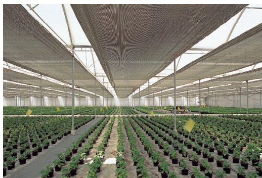
Fig. 2.12 Colocación de la pantalla térmica que favorece la conservación del calor y libera al cultivo de plagas. 22
