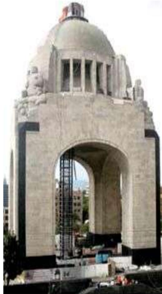
Monumentos a la *Independencia y Revolución Mexicana*, con intervención superficial y agregados, sin resolver problema fundamental; su *Estabilidad*. Problema de origen: Mecánica de suelos con alteración y cimentación profunda, ambos con fragilidad en un evento sísmico. Fotos *Wikipedia* y *Excelsior*, 21/VIII/2010.<sup>40</sup>
