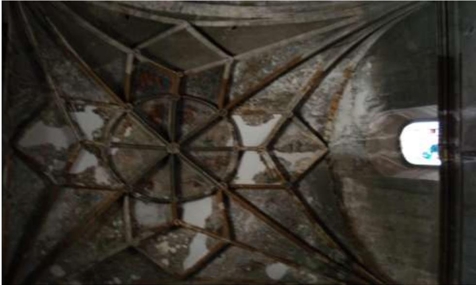
Fisuras en bóveda de la nave de *Metztitlán* por desplazamiento de apoyos al fallar el terreno sustentante.
