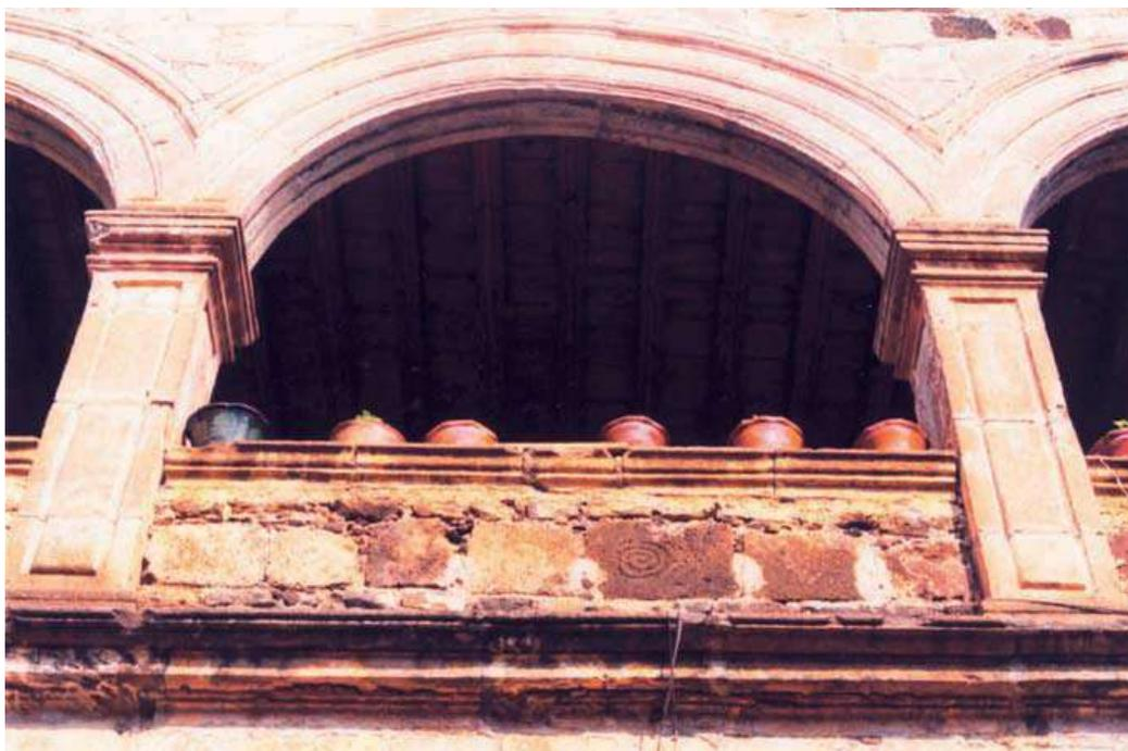
Claustro de Tzintzuntzan con alteración por sistema de vigas de concreto. *Imagen: Kalipedia.*
