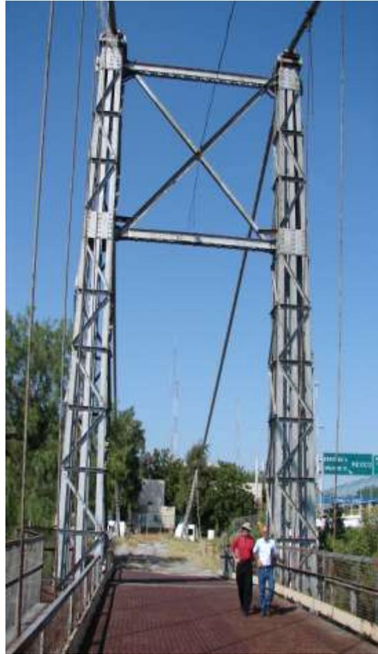
Mástiles o postes de apoyo: Carenarías destensadas.
