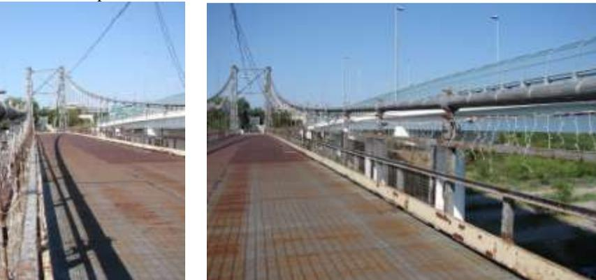
Corrosión de paneles colocados en 1948 (Veinte años después de su construcción).
