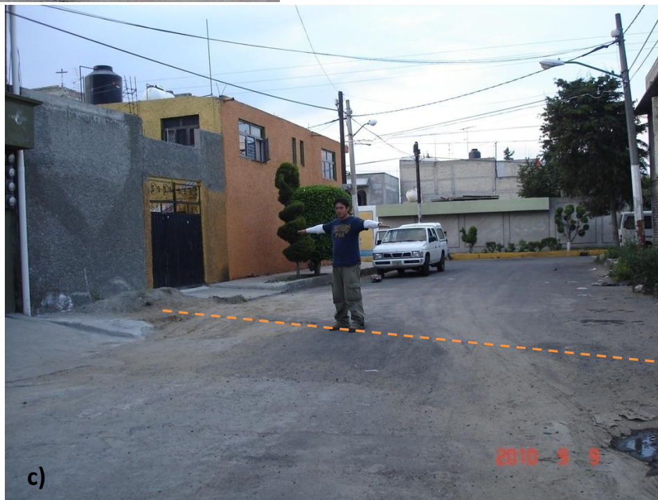
Figura 3.17 a, b, c. Afectaciones que han provocado los agrietamientos en la colonia Del Mar.
