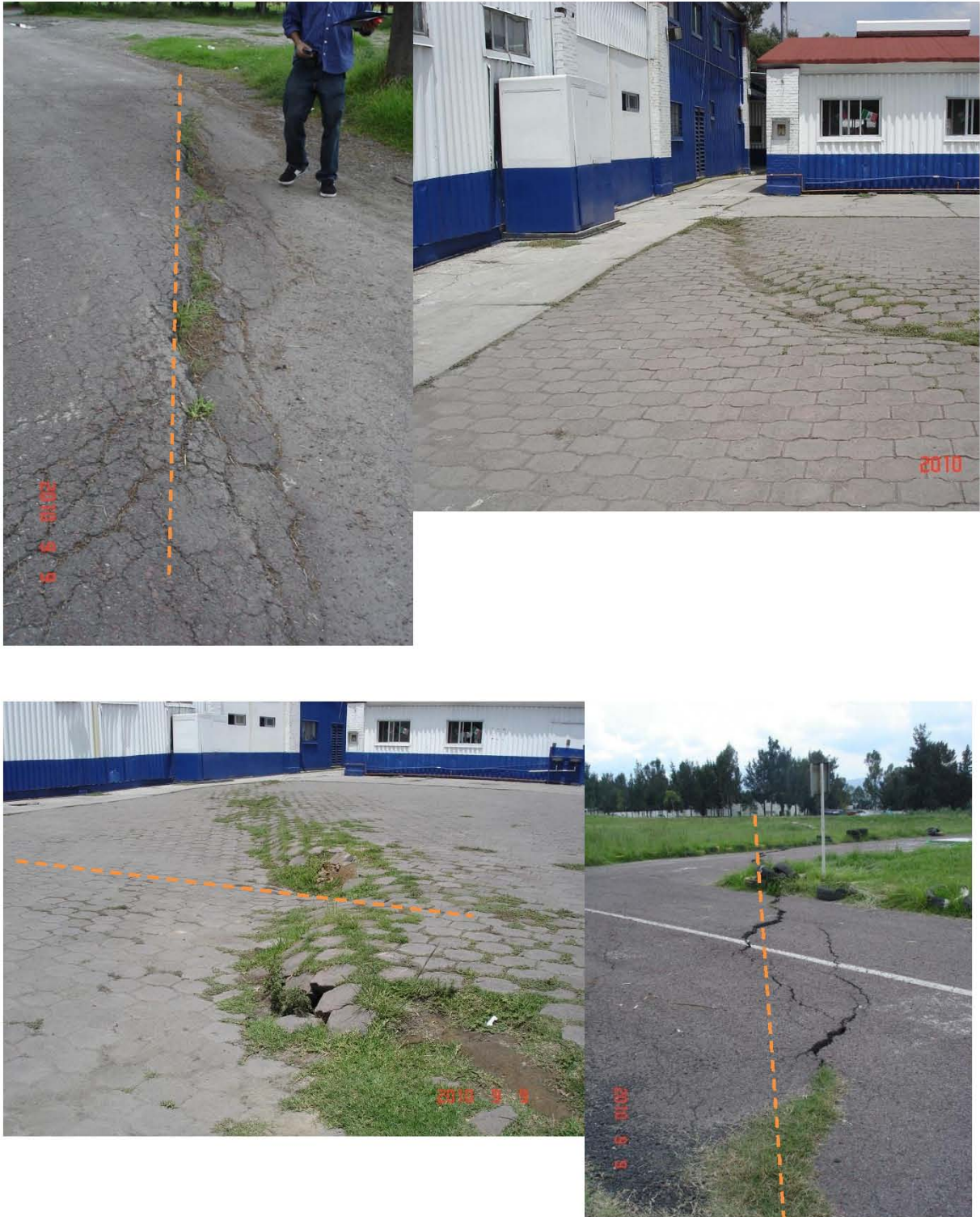
Figura 3.16. Afectaciones en las instalaciones del Agrupamiento Fuerza de Tarea. Se verifica la presencia de escalones; algunos han sido rellenados con asfalto para paso vehicular.
