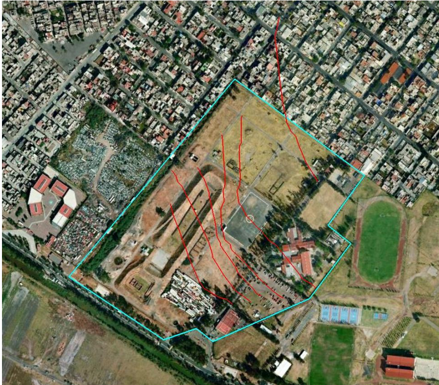
Figura 3.15. Zona de estudio. Las líneas en azul delimitan al predio. Las líneas en rojo muestran las grietas que afectan la zona de estudio.
