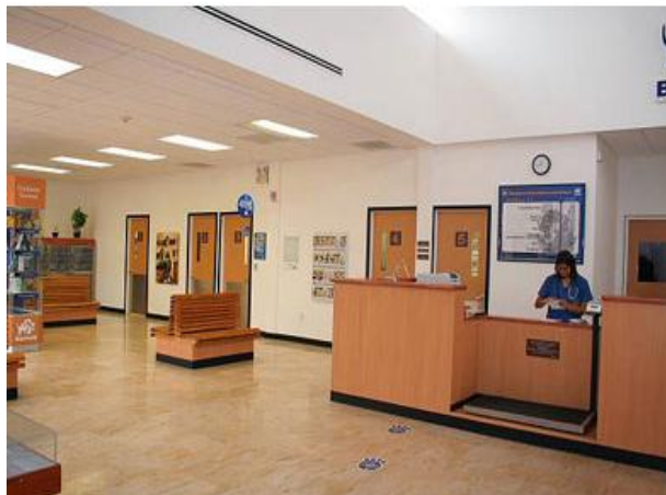
Recepción y sala de espera. Tiene mobiliario de madera. Los muebles de la sala de espera son fáciles de limpiar ya que no contienen ningún material textil. El piso es de loseta vinílica imitación madera.
