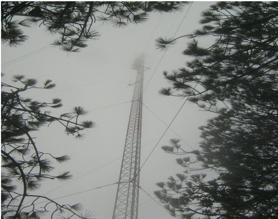
Fig. 3.1. Aspectos de las condiciones climatológicas en estación repetidora Corral de Piedra
