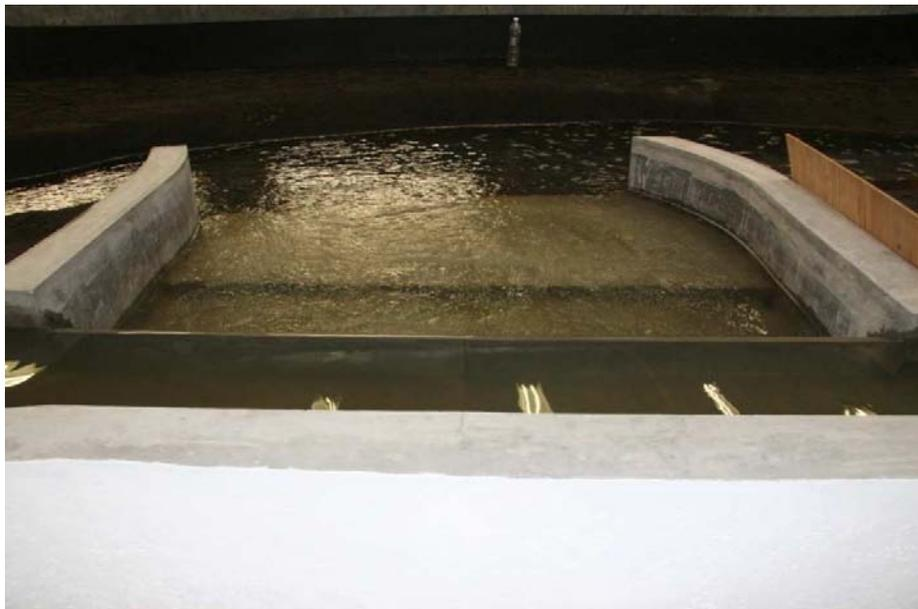
Fig. 5.1.2 Detalle del vertedor de excedencias del TEO
