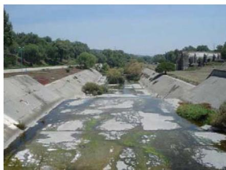
Fig. 2.1.9 Rectificación del río El Salto
