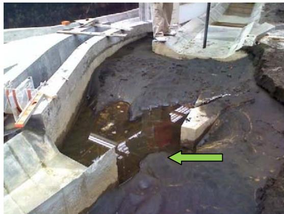
Fig. 9.3.2.5 Socavación en el sitio 3
