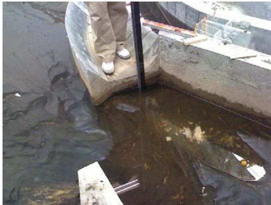
Fig. 9.3.2.3 Socavación en el sitio 1
