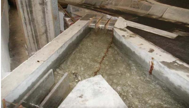
Intersección de canales del TEC y TEO, en dirección al distrito de riego, con un gasto en TEC de 0 m<sup>3</sup>/s y TEO de 50 m<sup>3</sup>/s. Obsérvese la gran turbulencia del flujo. Las compuertas de entrada al túnel están totalmente abiertas.
