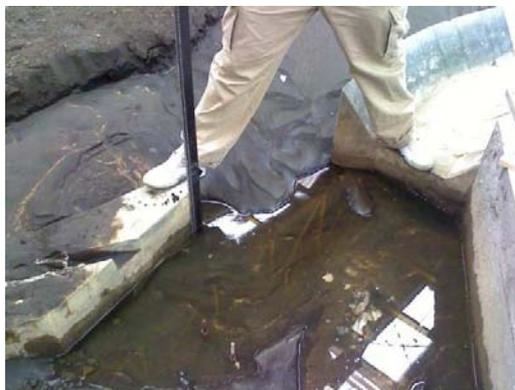
Fig. 9.3.2.4 Socavación en el sitio 2
