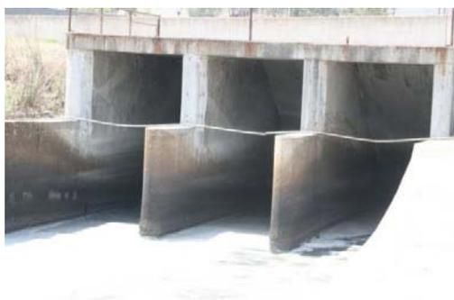
Fig. 2.1.8 Túnel alcantarilla bajo el río El Salto
