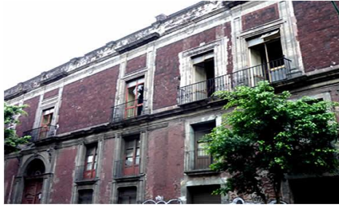
Vista interior y detalle de fachada
