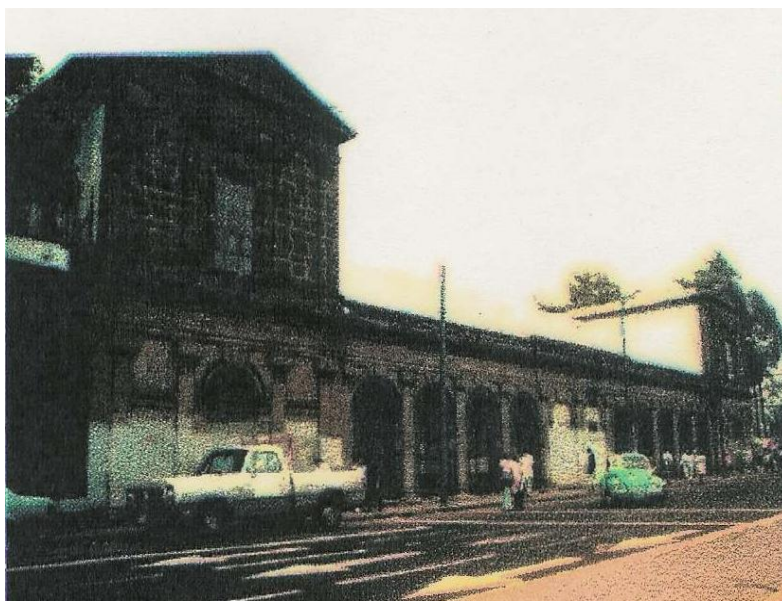
Detalle de Fachada Principal. Antigua Escuela de Medicina Veterinaria
