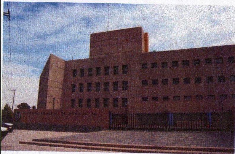
Vista de fachada principal
