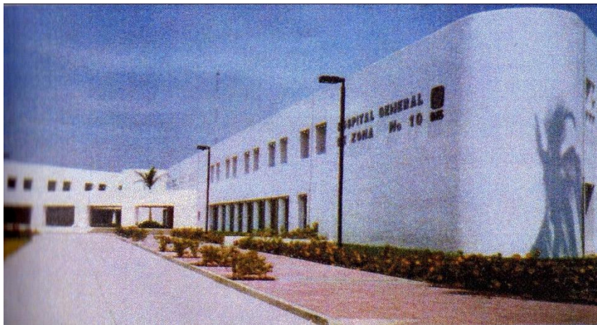
Vista de la plaza de acceso a entrada principal Revista Enlace
