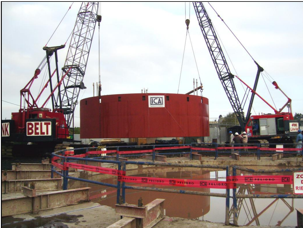
LUMBRERA FLOTADA TUNEL RIO DE LA COMPAÑIA
