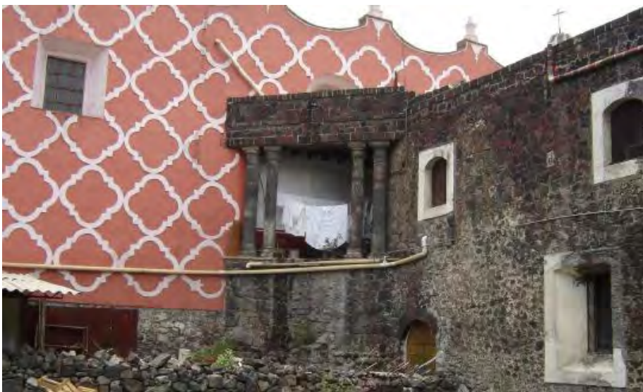
FIGURA 36 B. Fachada norte del conjunto, fachada frontal del convento que quedó interior a la fachada principal del conjunto. Fotografía de Irene Pérez Rentería, 2008.
