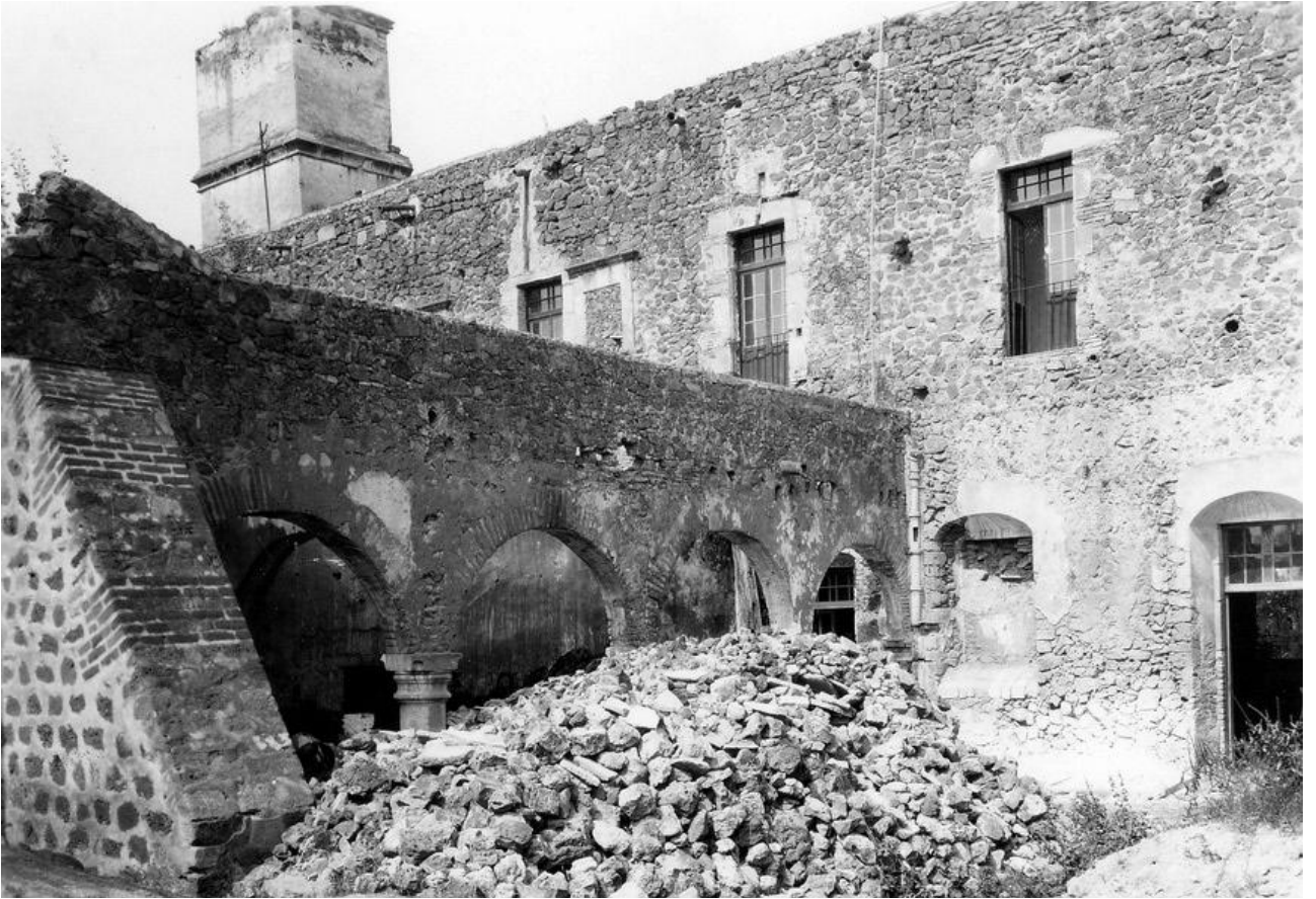
FIGURA 170. Manuel Ramos (atribuida), Interior del convento de San Juan Bautista, en Coyoacán, Ciudad de México, 1921-1923. Área posterior del convento, antigua huerta y corral, después se sustituiría por oficinas administrativas del convento franciscano. 200
