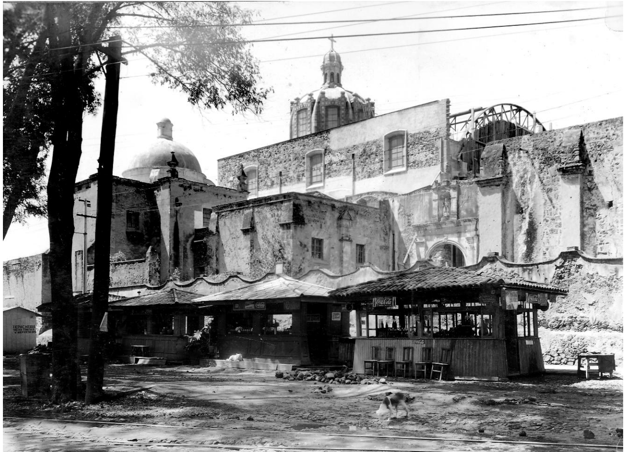
FIGURA 174. Luis Limón, Obras en la fachada norte de la parroquia de San Juan Bautista Coyoacán, Ciudad de México . Fachada norte del templo, continúa la construcción de los muros laterales. En la foto se muestra el avance de la obra: “...y convendría conservar cuidadosamente la unidad del conjunto en el exterior y el carácter de la época...” 607
