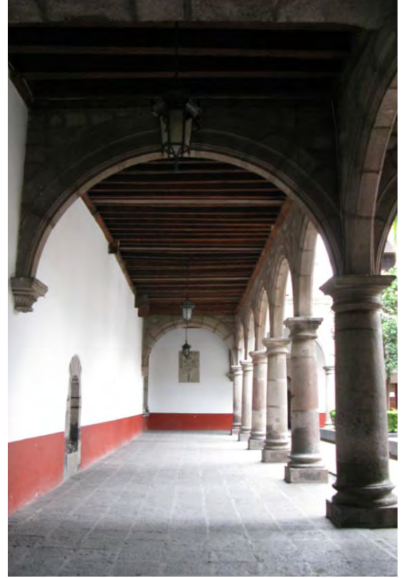
FIGURA 192. Pasillo norte del claustro bajo. Es un so de viguería al igual que el resto de los forjados de piso (sobrepuesto a la losa de concreto armado) de este nivel. En el fondo se encuentra la quina en donde estaría el artesonado al que se fieren. Fotografía de Irene Pérez Rentería, 2009.
