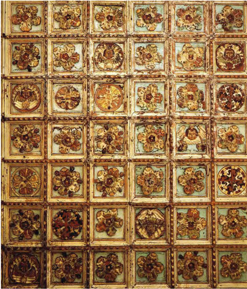
FIGURA 359. Javier Hinojosa, Detalle de la cubierta del claustro bajo , San Juan Bautista, en Coyoacán, Ciudad de México. 1080
