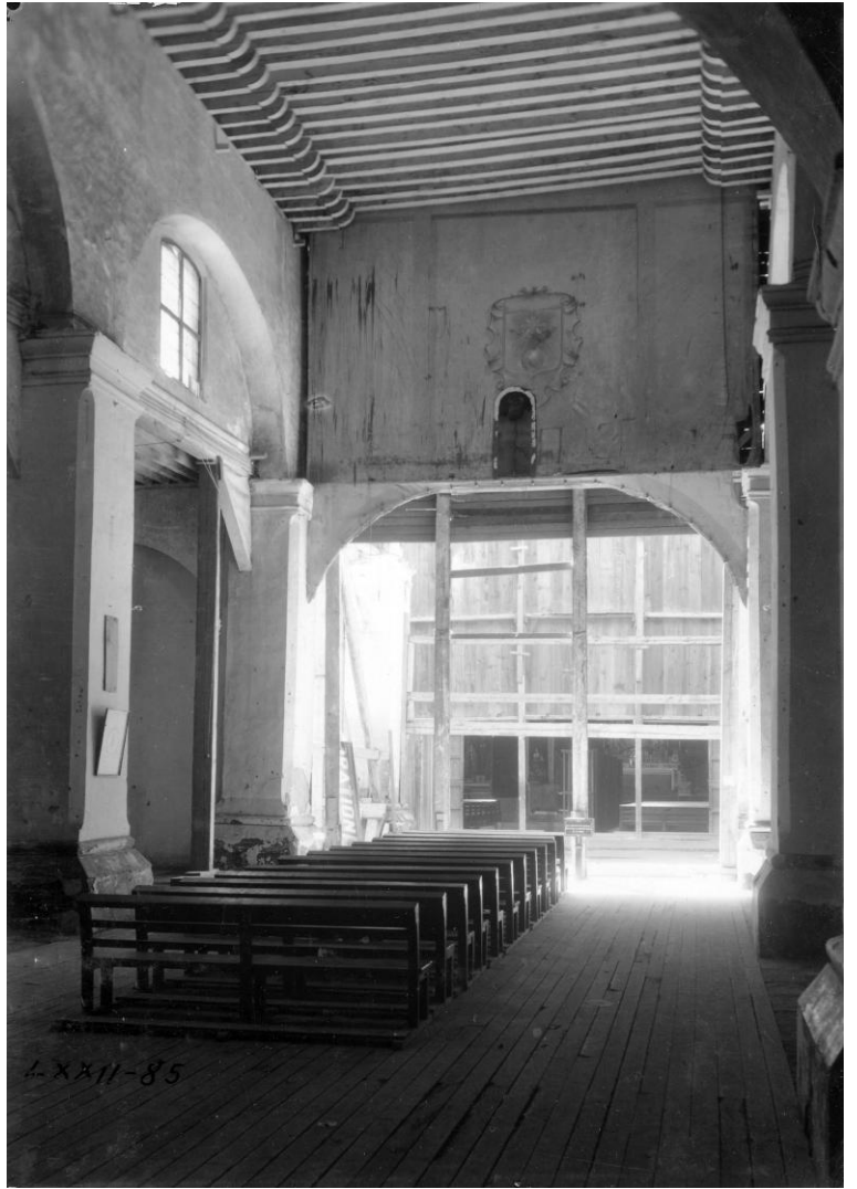
FIGURA 171. El interior del templo durante las obras, s/f. 305 Nótese el espacio destinado a los fieles y el avance de la construcción.
