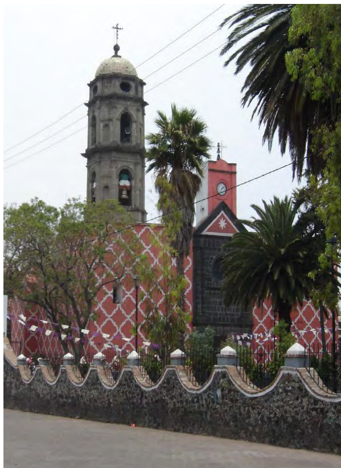
FIGURA 35. Lateral del conjunto y fachada principal del templo de San Pedro, Tláhuac. Fotografía de Irene Pérez Rentería, 2008.
