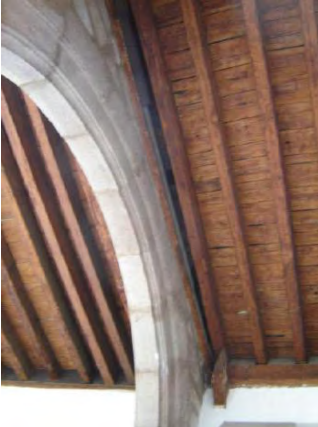
FIGURA 191. En 1939, Se realizan reparaciones en el artesonado, “...en el interior de la Iglesia del lado casi de la sacristía se efectúan reparaciones en uno de los artesonados dorados o sea uno de los colaterales, de lo que se alcanza apreciar en el mismo lugar”. 654 El artesonado que se menciona ya no existe y ha sido sustituido por un alfarje de mala factura. Fotografía de Irene Pérez Rentería, 2009.
