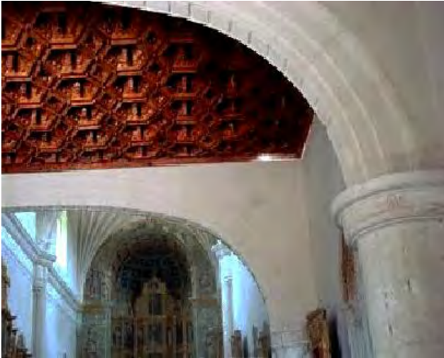
FIGURA 243. Templo dominico en Yanhuítlan, Oaxaca. Sección del techo del sotocoro con artesones hexagonales, atrás se percibe la cúpula semi esférica del altar mayor con casetones pintados, 1590. 796
