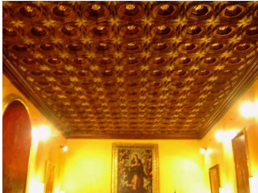
FIGURA 365. Artesonado en la antigua sacristía del Hospital de Jesús. Fotografía de Irene Pérez Rentería, 2009.
