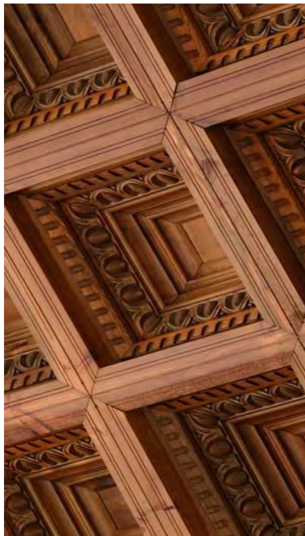
FIGURA 251. Detalle del artesonado de las galerías del Alcázar de Toledo. 813
