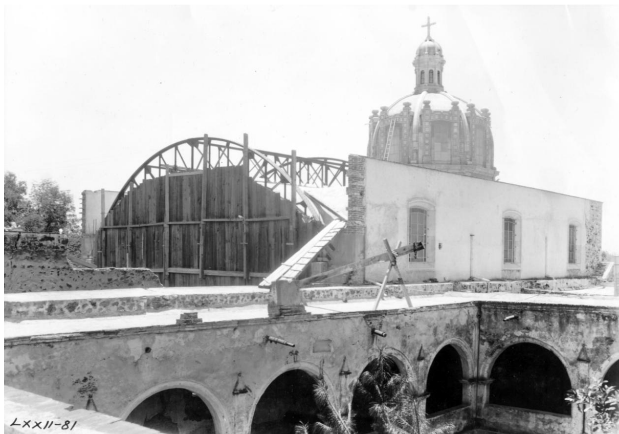
FIGURA 175. Anónimo, estructura soporte para la bóveda de medio cañón y los muros laterales levantándose. Vista desde la azotea poniente del convento, s/f. 698
