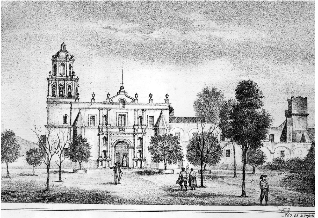
FIGURA 146. Murguía, Coyoacán, Iglesia parroquial en el ex convento de los Dominicos, ca. siglo XIX. 518 En la litografía se percibe la barda del antiguo cementerio sin el arco barroco, la cubierta del segundo nivel del claustro como una armadura de cubierta a dos aguas y sólo se ven tres de los arcos del portal de peregrinos.
