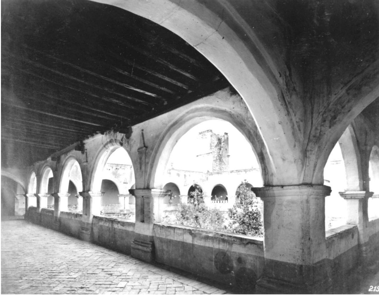
FIGURA 180. Anónimo, claustro alto del convento, s/f. 619 Su techumbre es un forjado de piso y el suelo es un pavimento de petatillo de ladrillo. Al fondo se ve la torre original del conjunto, s/f.
