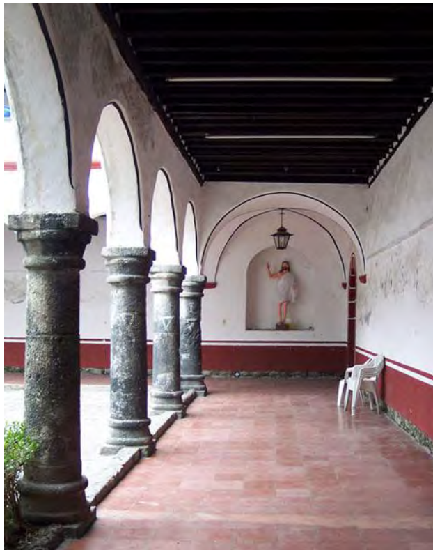
FIGURA 37. Alfárje en la galería del claustro bajo del convento de San Pedro, Tláhuac. Al fondo se ve la bóveda de crucería (con una altura muy baja). Fotografía de Ismael Rangel Gómez, 2010. 295
