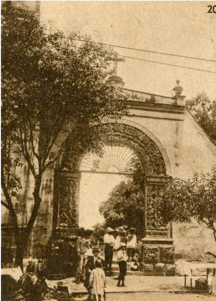
FIGURA 152. Anónimo, la portada lateral de la barda atrial una vez reubicada en la fachada principal del templo. 531 Con el traslado, las proporciones cambiaron, ahora es más alta porque construyeron una base de basalto que antes no se existía (posiblemente para igualar el nivel de la fachada).
