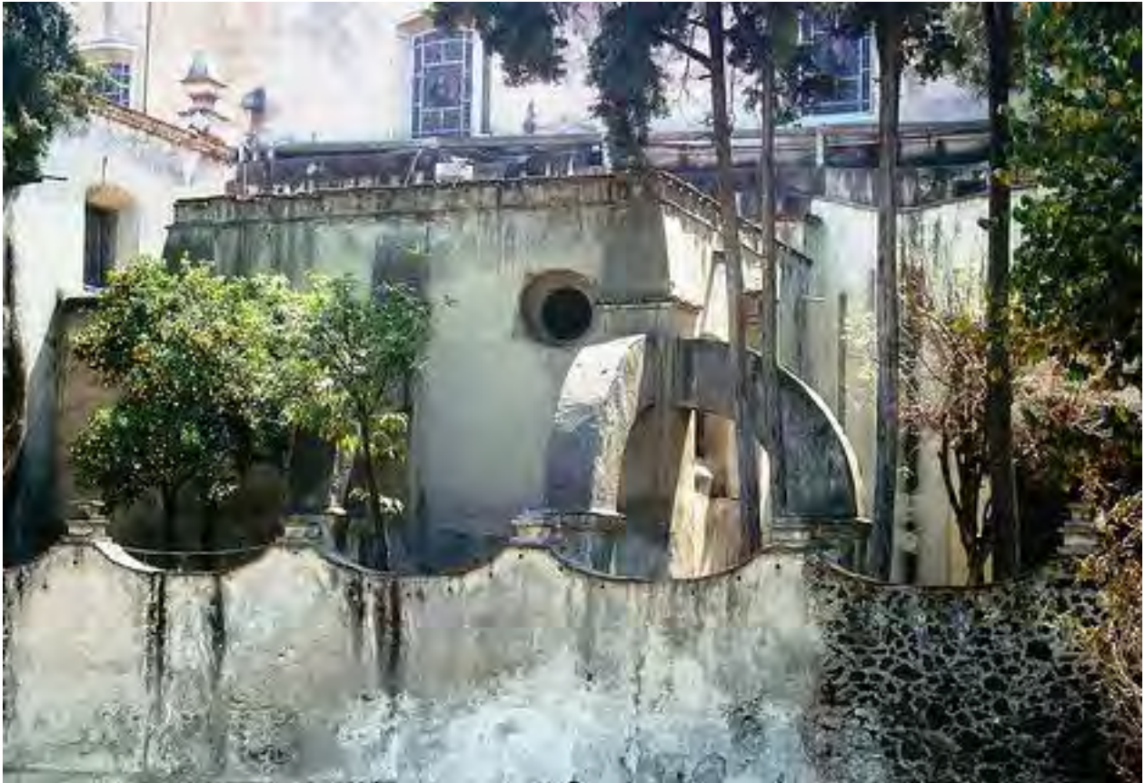
FIGURA 194. Antigua Capilla del Inmaculado Corazón de María, posteriormente sería la Capilla de Nuestra Señora de Fátima. 655 Aún permanecen con el sistema constructivo original, arcos botareles y los remates son muy similares a las perlas isabelinas que tienen en su remate el muro de la torre original.
