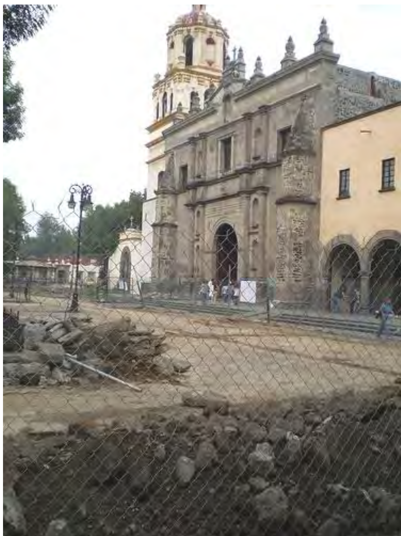
FIGURA 225. Obra de remodelación en el Jardín Hidalgo y en el atrio del convento, marzo de 2009. 709
