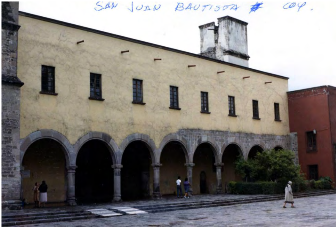
FIGURA 220. Fachada poniente del convento de San Juan Bautista. Se muestra el portal de peregrinos y el primer piso del convento, así como, la torre del siglo XVI, 74 ca. 1982.
