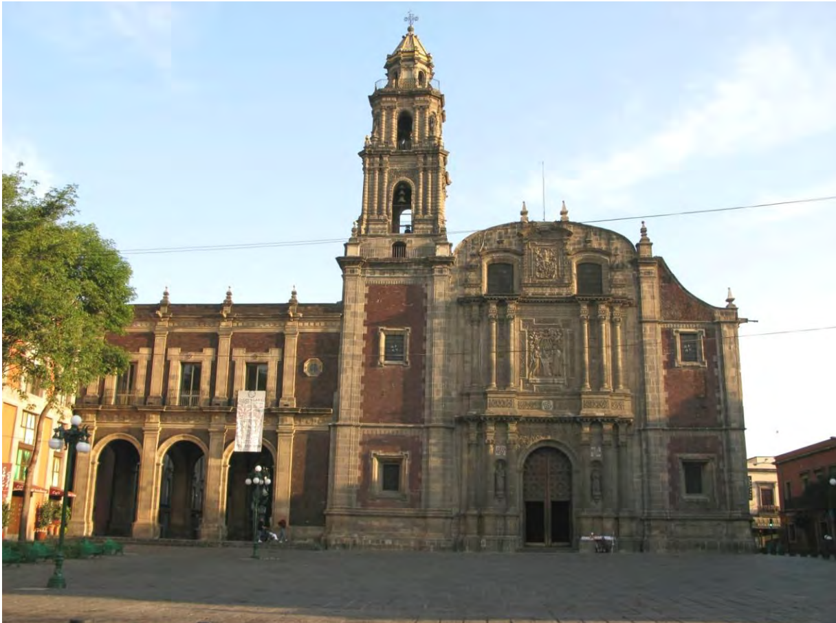
FIGURA 4. Santo Domingo de México, en la Ciudad de México. Vista frontal de la fachada principal, calle de Belisario Domínguez. Fotografía de Irene Pérez Rentería, 2009.
