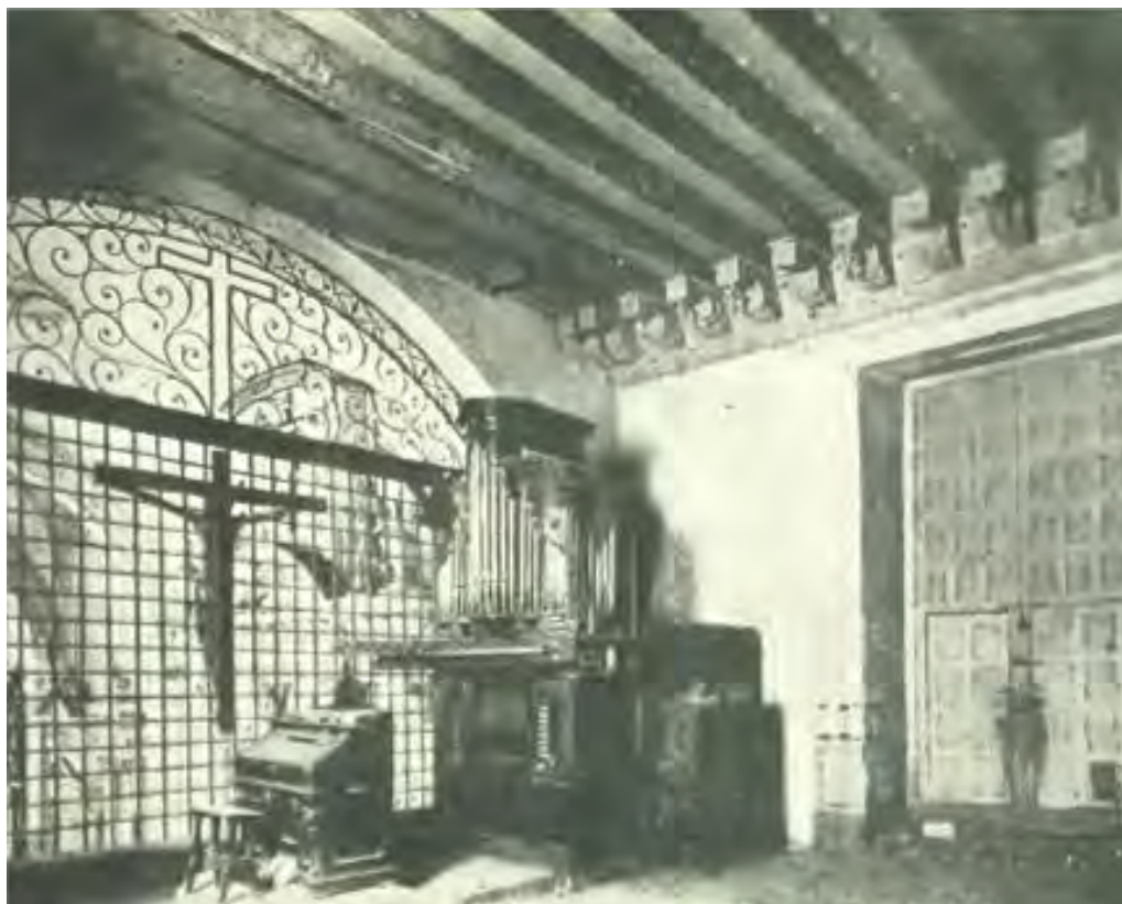
FIGURA 334. Coro de la iglesia de Santa Catalina de Siena 1024 . “La cubierta de este coro es de madera apoyada en vigas, sostenidas a su vez por hermosas zapatas, con hojas de acanto, talladas en relieve y rematadas con pñjantes tallados también en madera. Y en los espacios entre viga y viga se observan los símbolos de la Orden de Santo Domingo...” 1025
