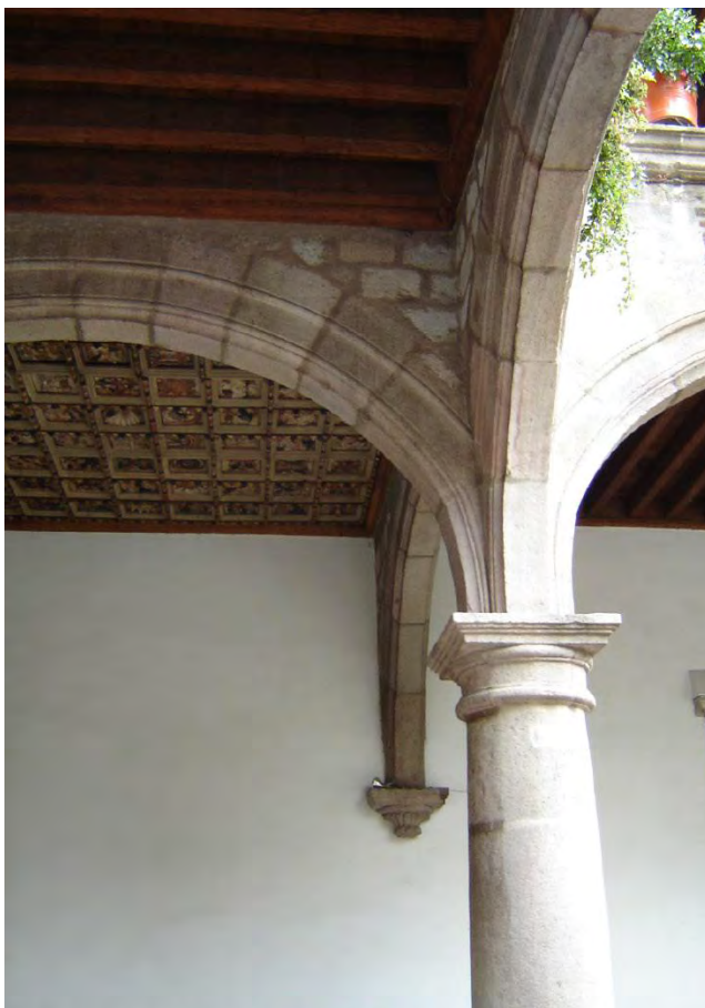
FIGURA 141. Artesonado en la esquina sur poniente del claustro bajo. Fotografía de Irene Pérez Rentería, 2010.
