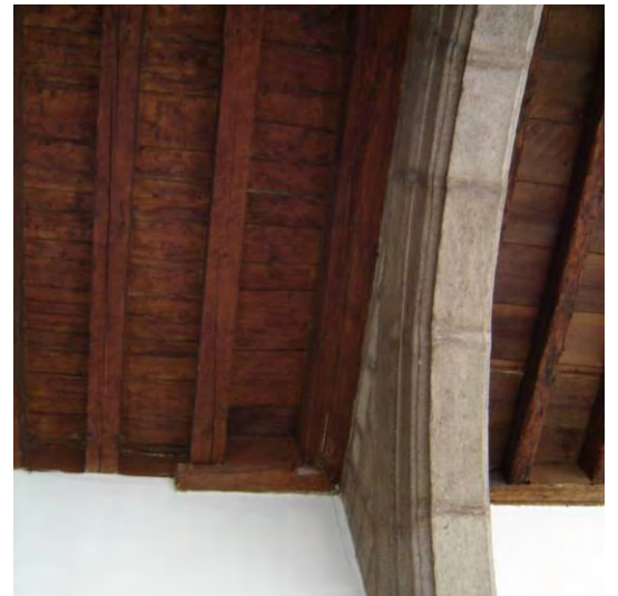
FIGURA 320. Detalle del forjado de piso en el convento de San Juan Bautista. Fotografía de Irene Pérez Rentería, 2009.
