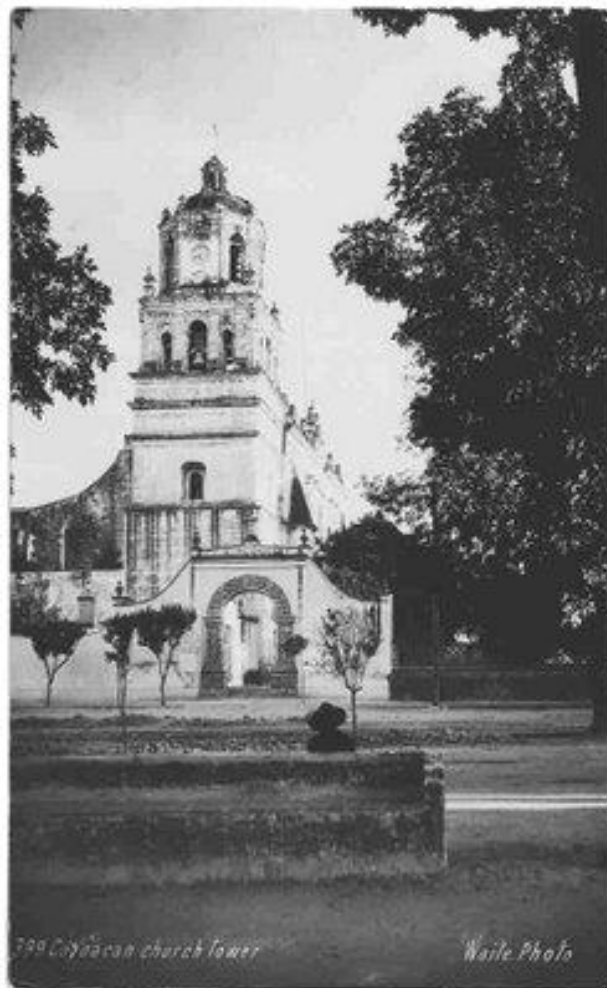
FIGURA 148. C. B., White, Coyoacan church tower, ca. , anterior a 1914. El arco barroco que daba acceso al cementerio, aún se encuentra en su ubicación original; sin embargo, la barda atrial (norte) ya no es como era originalmente. 522
