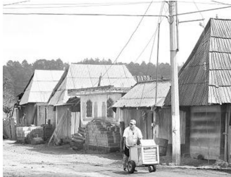
FIGURA 321. Iván Sánchez, casas en San Antonio Tierras Blancas, Michoacán, 998 techos con armaduras de limas formadas por cuatro faldones.
