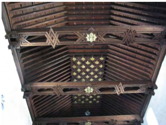
FIGURA 326. Alfarje con almizate de lazo, techumbre del templo de San Francisco. Fotografía de Irene Pérez Rentería, 2009.
