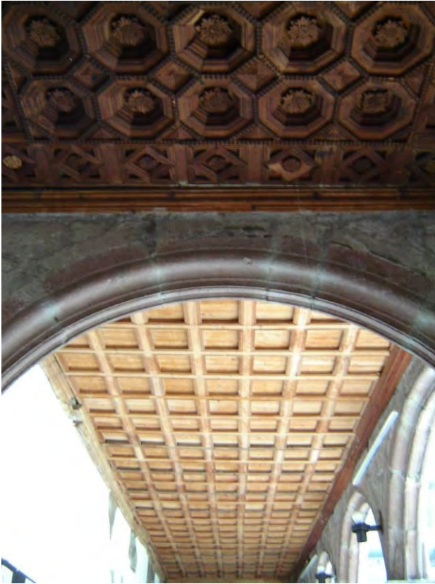
FIGURA 318. Ejemplo de techo plano con artesonados, convento de los Santos Apóstoles Felipe y Santiago, en Azcapotzalco. Fotografía de Irene Pérez Rentería, 2008.
