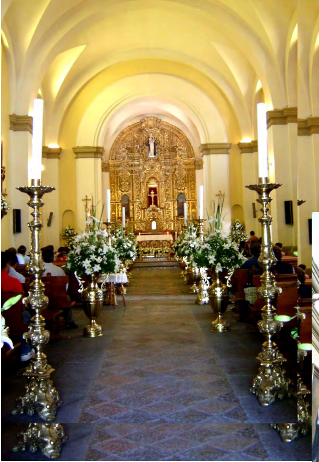
FIGURA 17 B. Interior del templo. Los arcos fajones y el arco triunfal sin decoración alguna y la nave cubierta con una bóveda de cañón corrida con lunetos. Fotografía de Irene Pérez Rentería, 2009.
