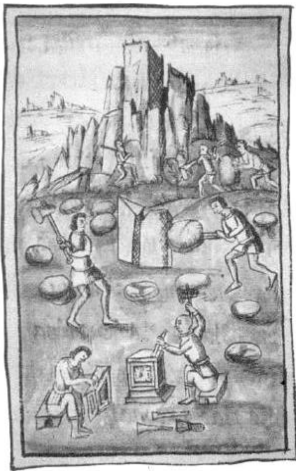
FIGURA 111. Extracción de material y fabricación de columnas por canteros. 403
