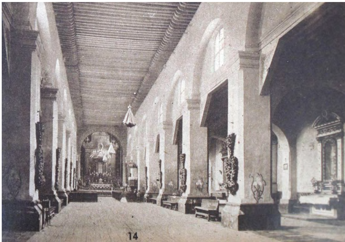
FIGURA 145. Anónimo, interior del templo con sus tres naves y cubierta de alfarje, s/f. 517 En 1880, Manuel Rivera Cambas refiere sus tres naves, con techumbre de vigería y sus columnas cuadradas. Se ve el decorado, los misterios y los altares originales del templo.
