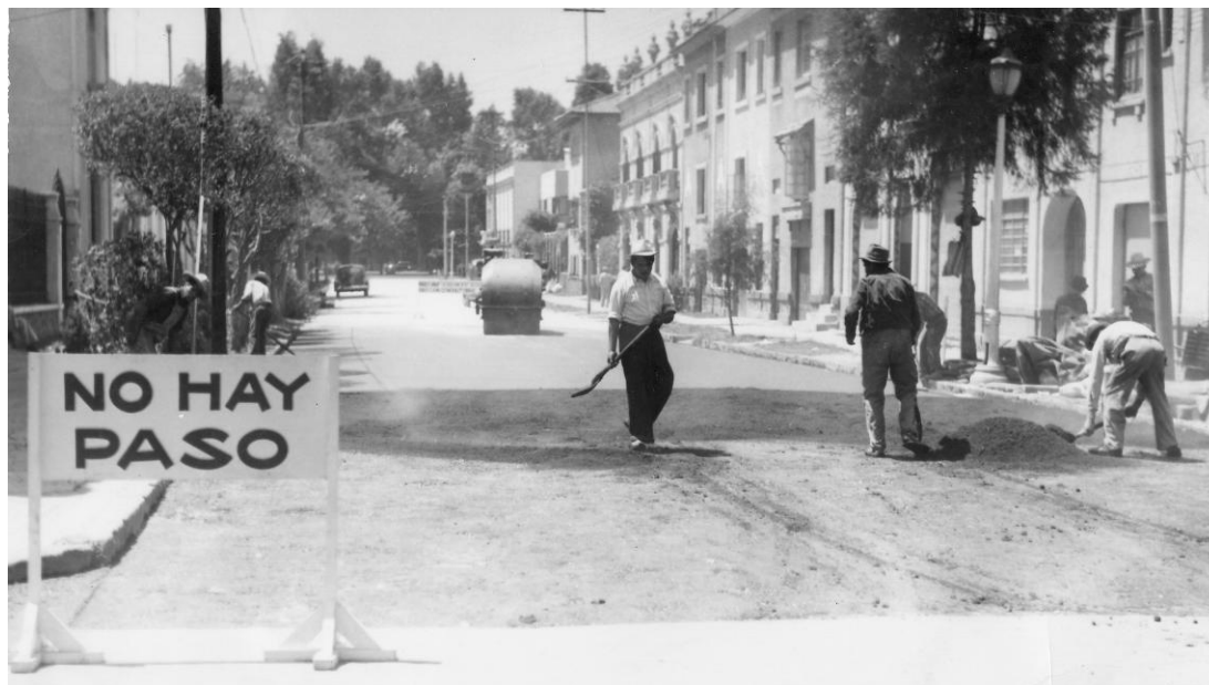
FIGURA 125. Anónimo, sin título, s/f. Pavimentación de las calles en el centro de Coyoacán y alrededores. Riego para compactar para posteriormente tirar las emulsiones asfálticas. 437
