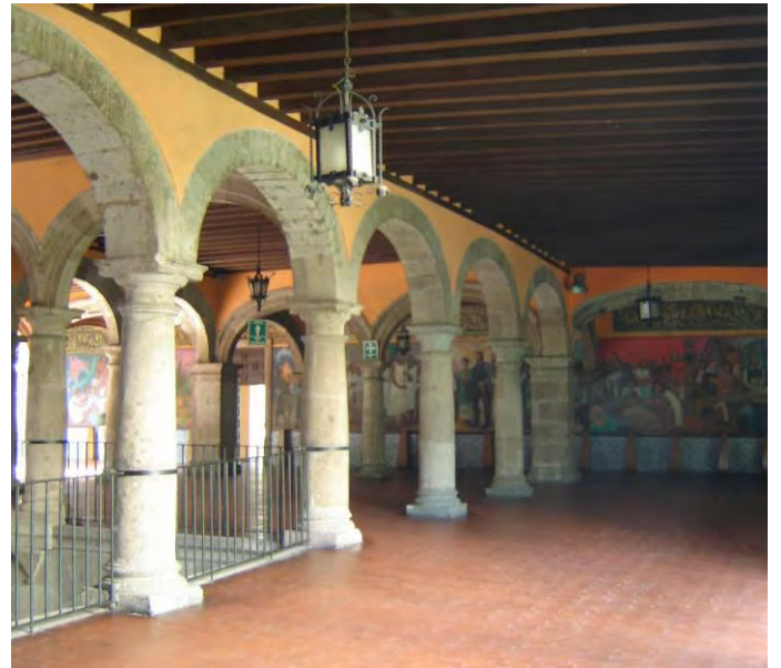
FIGURA 233. Forjado de piso en un pasillo de planta alta del Hospital de Jesús. Fotografía de Irene Pérez Rentería, 2007.
