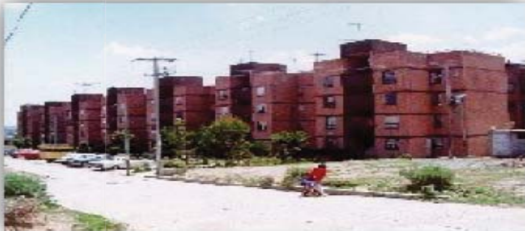
VIVIENDA TERMINADA DE INTERES SOCIAL
