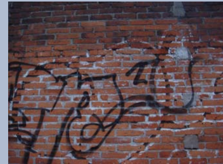
Cañada # 145 Uso: Habitacional Tipo de graffiti : Tag Soporte: Tabique
