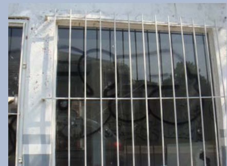
Calz. Las Águilas # 363 Uso: Comercial Abandonado Tipo de graffiti : Tag (Etching Acid) Soporte: Vidrio
