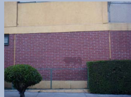
Cañada # 149 Uso: Habitacional Tipo de graffiti : Tag Soporte: Tabique
