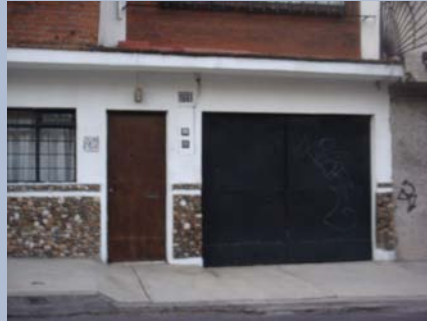
Cañada S/N Uso: Habitacional Tipo de graffiti : Tag Soporte: Metal
