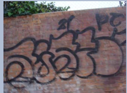
Cañada # 181 Uso: Habitacional Tipo de graffiti : Tag Soporte: Tabique
