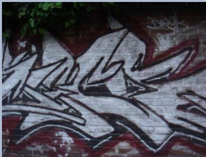
Cañada S/N Uso: Habitacional Tipo de graffiti : Tag Soporte: Tabique
