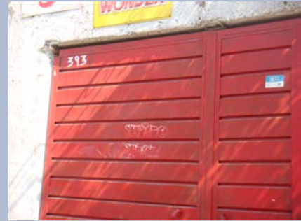
Calz. Las Águilas # 393 Uso: Habitacional Tipo de graffiti : Tag Soporte: Metal
