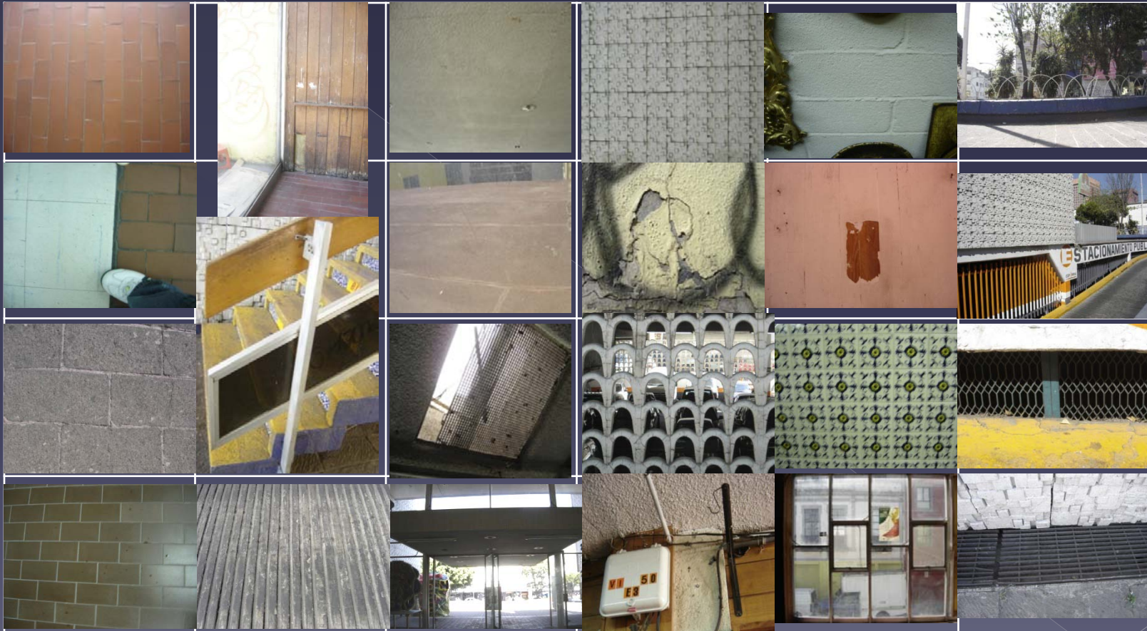
LEVANTAMIENTO DE MATERIALES
