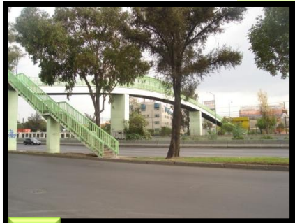
3 VISTA HACIA EL PUENTE PEATONAL
