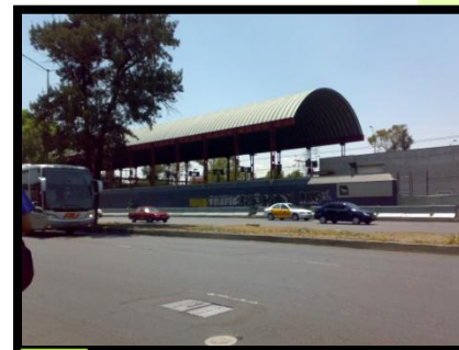
3 METRO CANAL DE SAN JUAN
