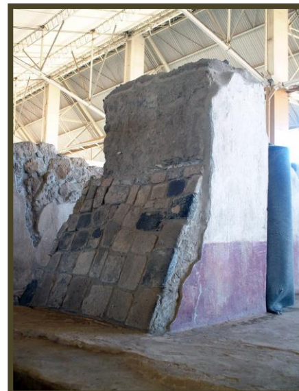
▲ FOT. HUGO HERNÁNDEZ H. Detalle de columna-talud, del sistema constructivo a base de piedra-estuco y pintura, en la Zona Arqueológica de Cacaxtla, Tlaxcala
