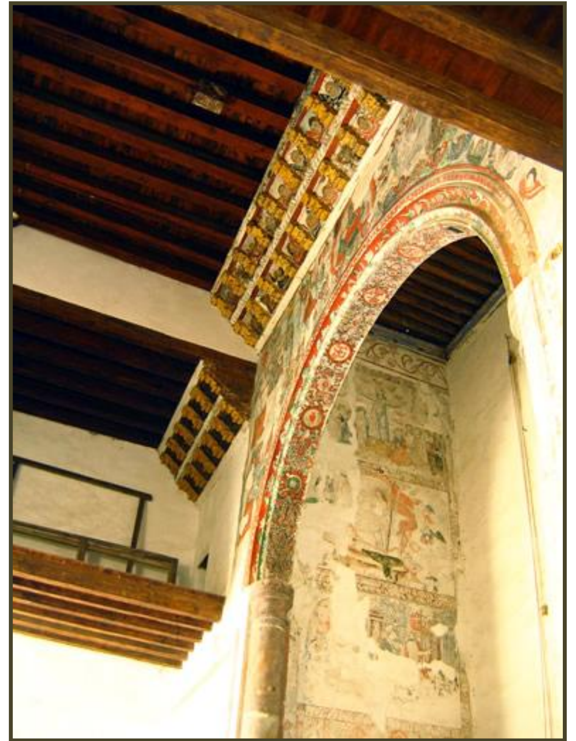
▲ FOT. HUGO HERNÁNDEZ. Vista interior de la capilla, donde se muestra el tapanco para el coro y las pinturas sobre el arco triunfal y ábside del presbiterio.
