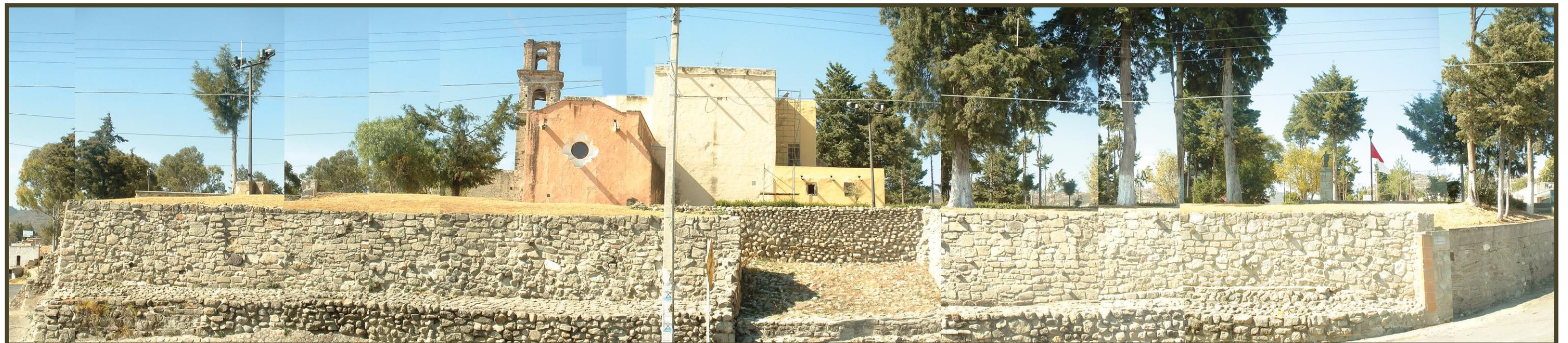
▲ FOT. HUGO HERNÁNDEZ. Composición de fotografías donde se observa la Fachada Posterior Oriente de la Capilla Abierta de Tizatlán sobre la
