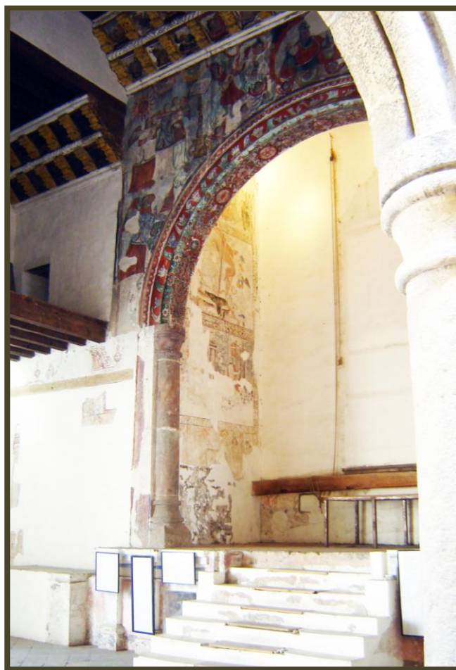
FOT. HUGO HERNÁNDEZ. Vista desde el interior de la capilla, hacia el exterior, se puede ver el muro testero o final de la parroquia del siglo XIX que bloquea la fachada de la capilla abierta.
