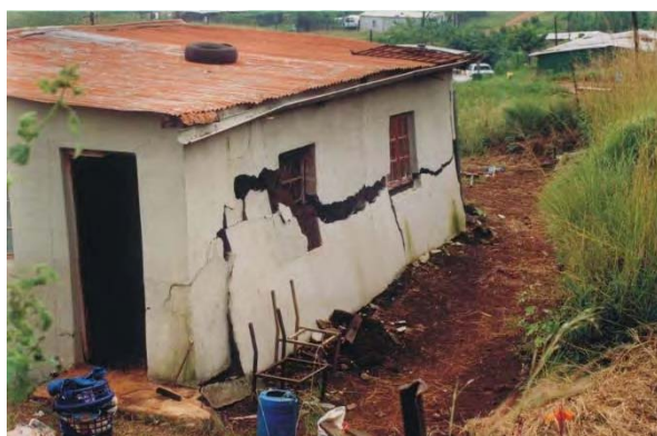
Imagen I.1. Daños debido a las arcillas expansivas. África y Australia respectivamente. (Abajo)
