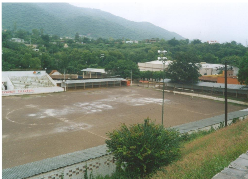
Foto 10: Unidad deportiva en Jalpan de Serra
