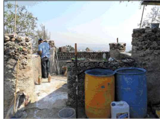
Construcción alternativa con PET
