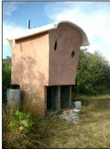
Figura 72. Modelo de sanitario compostero de doble cámara.
