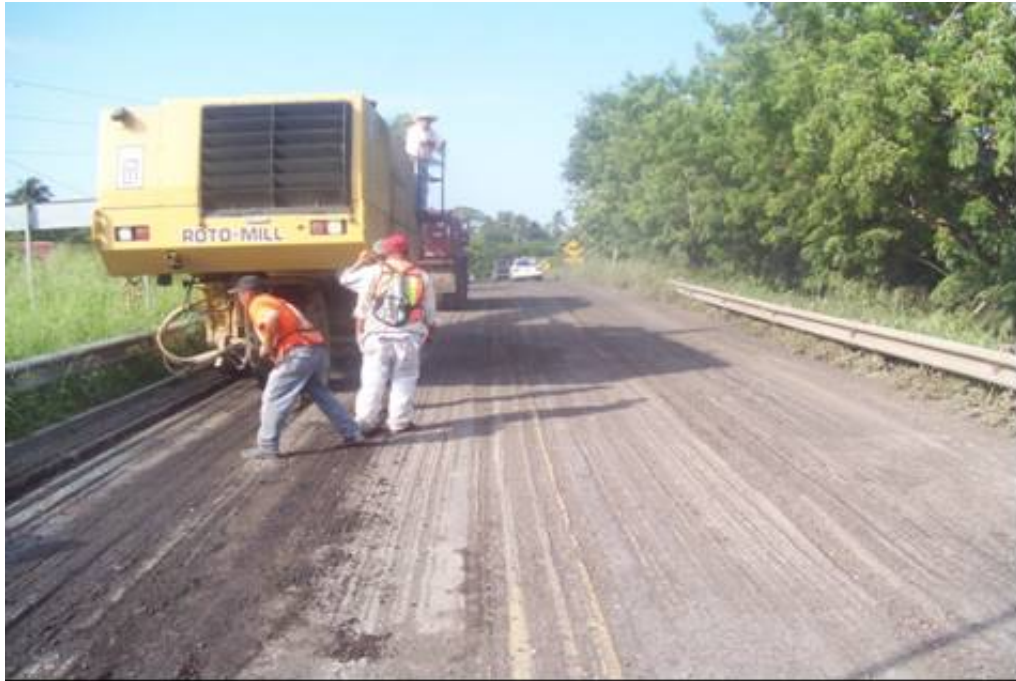
Recuperación de pavimento.
