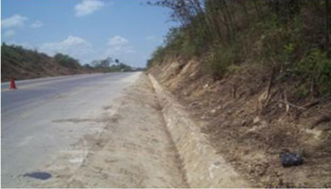
Derrumbe totalmente retirado.
