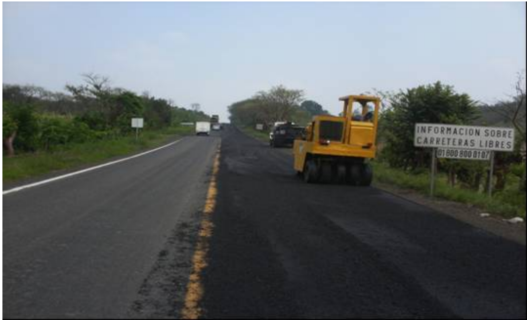
Compactación de la carpeta asfáltica.
