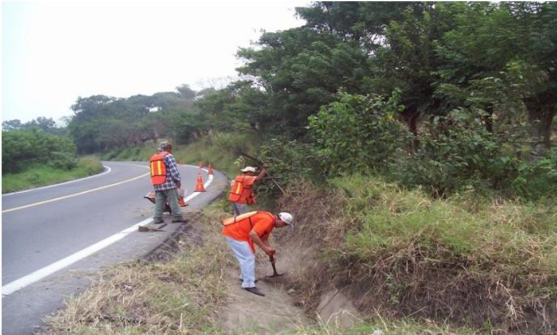
Trabajos de desazolve.
