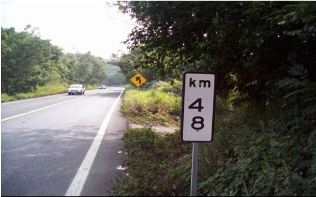
Poste de kilometraje repuesto.
