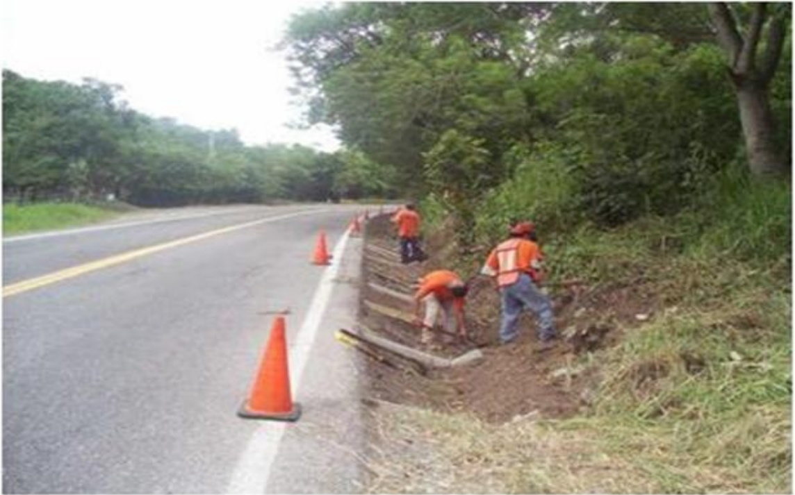
Trabajos de perfilado para la construcción de la cuneta
