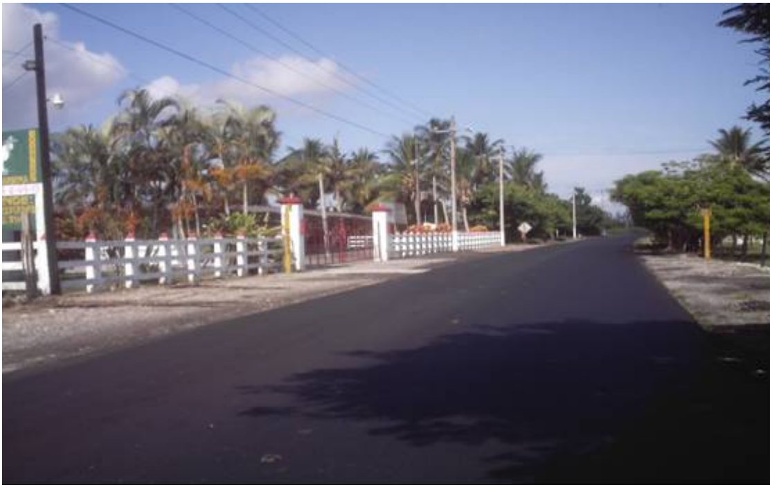
Sobre carpeta dentro de los trabajos de conservación periódica.
