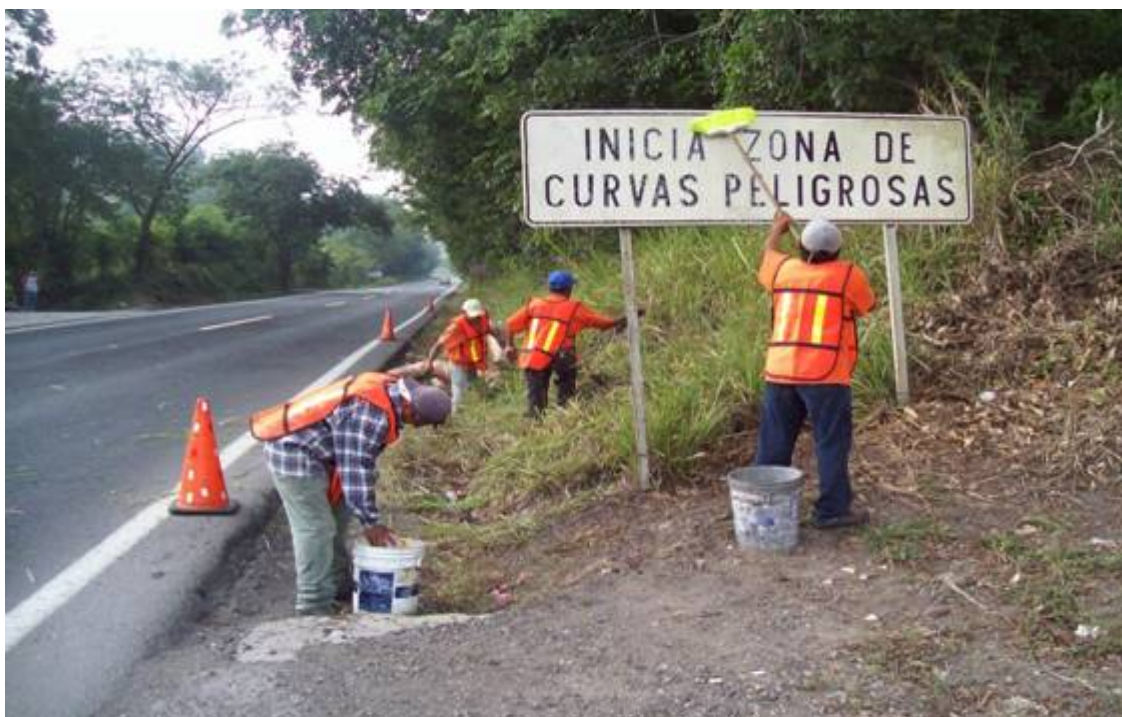
Personal limpiando la señal y desyerbando la zona de influencia a la señal.
