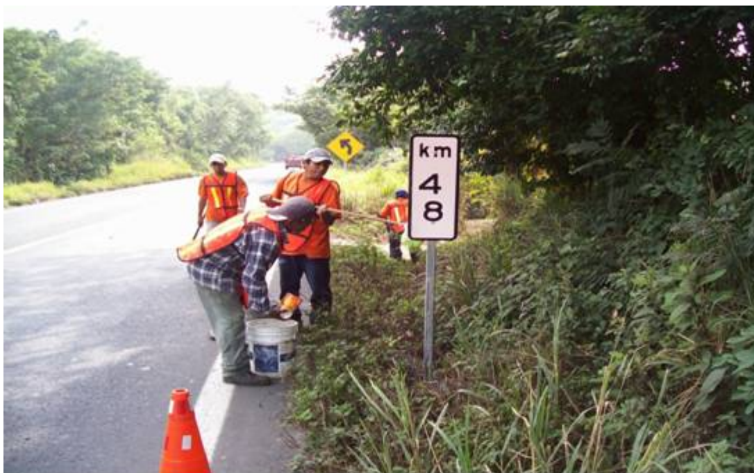
Poste de kilometraje colocado, limpieza alrededor de la señal.
