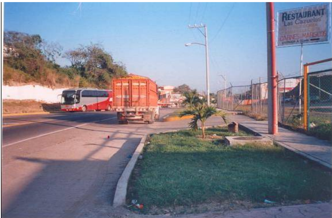
Retiro de señal dañada.
