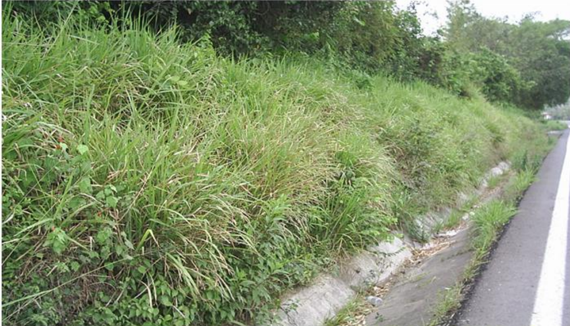
Derecho de vía, enyerbado en terreno irregular
