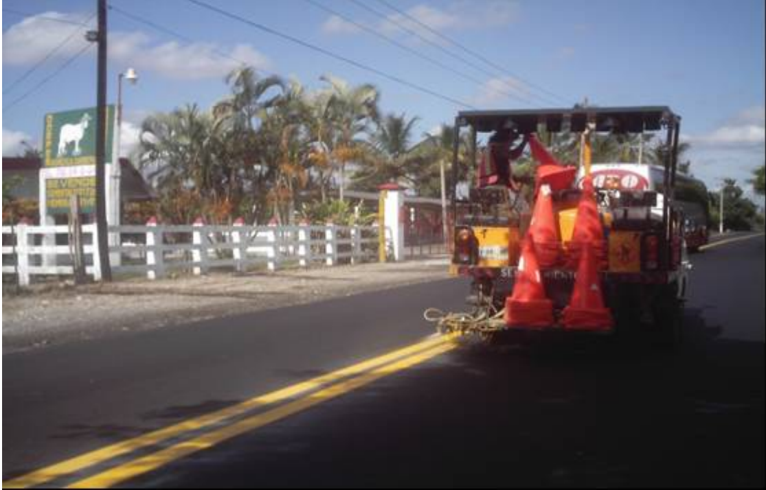
Pintura de doble raya central.
