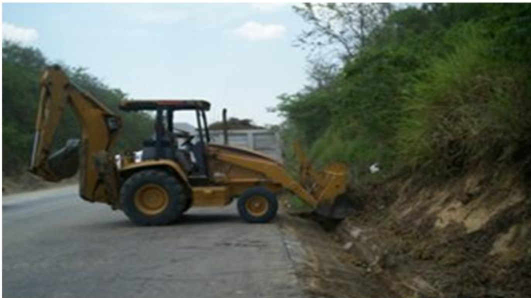
Trabajo realizado con equipo para retiro de derrumbe.
