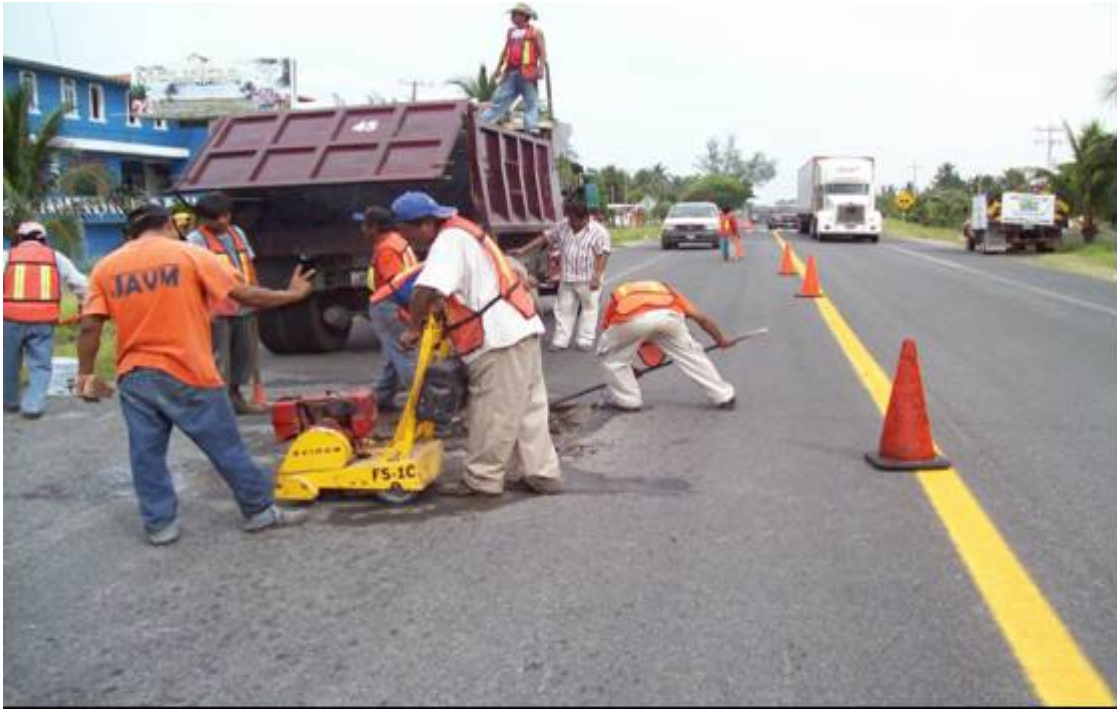
Trabajos de retiro del material agrietado.
