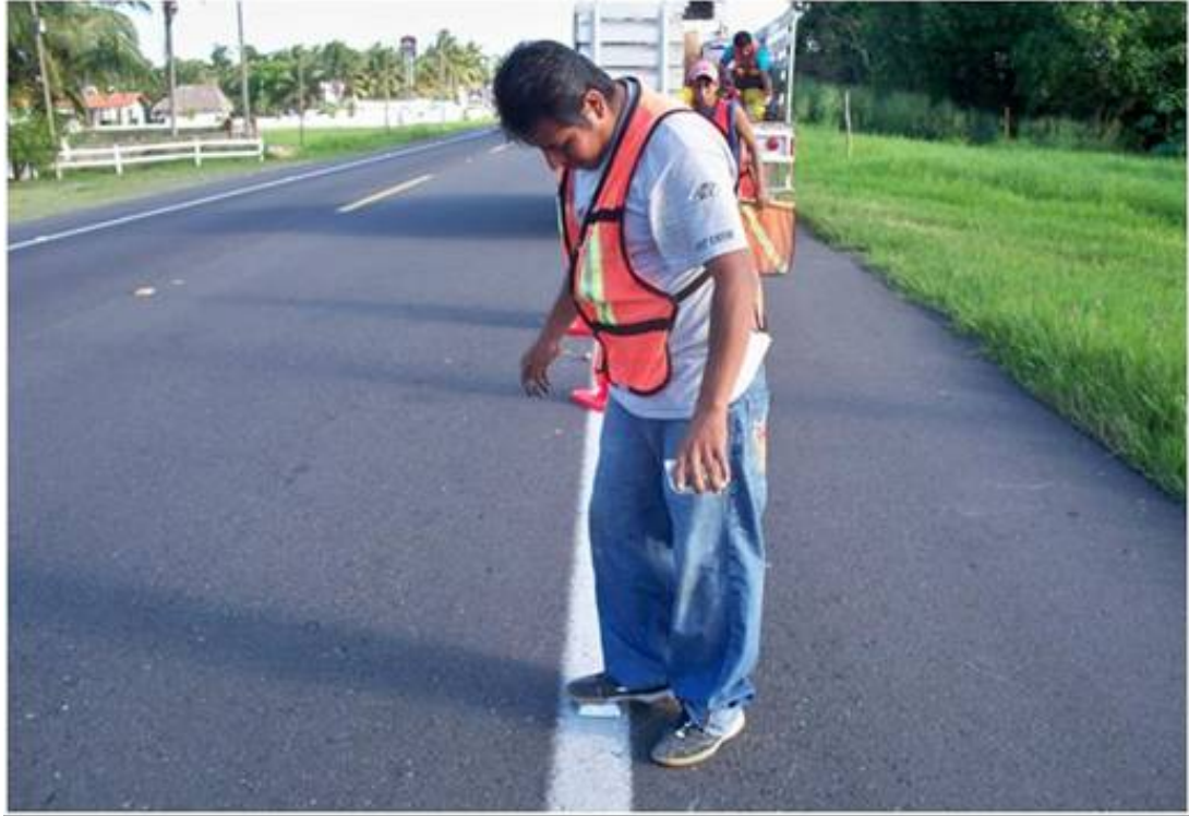
Colocación de vialeta.
