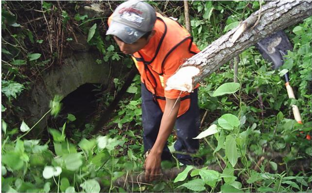
Trabajos de limpieza y desazolve.
