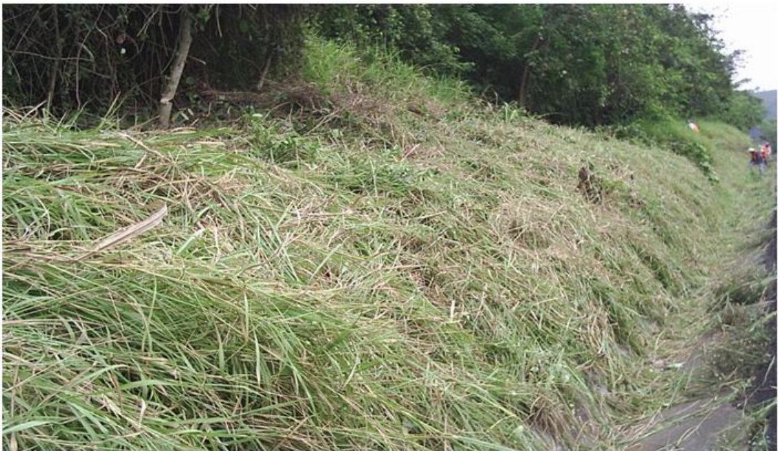
Aspecto del derecho de vía desyerbado
