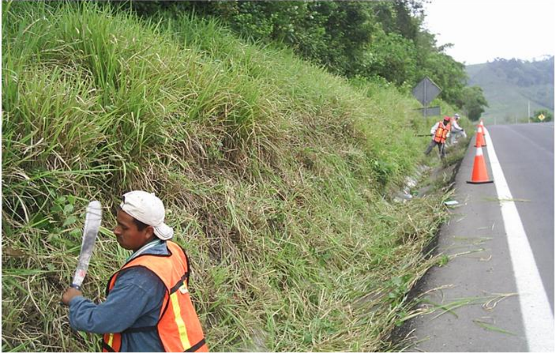
Desyerbe de derecho de vía con mano de obra
