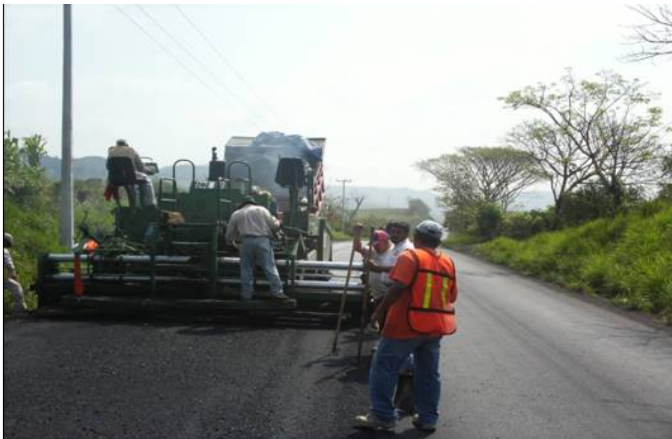
Proceso de tendido del concreto asfáltico.
