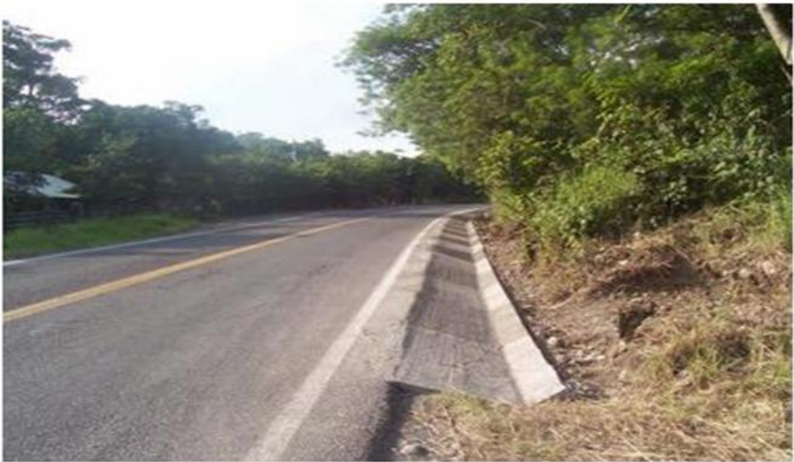
Cuneta zampeada con concreto hidráulico terminada
