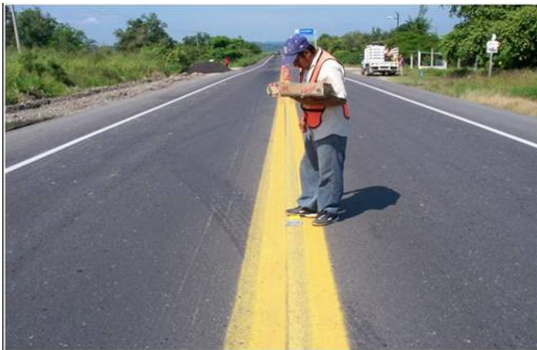
Trabajo previo a la colocación de vialeta (aplicación de resina epóxica)
