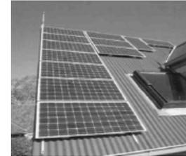
Incorporación de paneles fotovoltaicos para generación de energía eléctrica en la vivienda.
