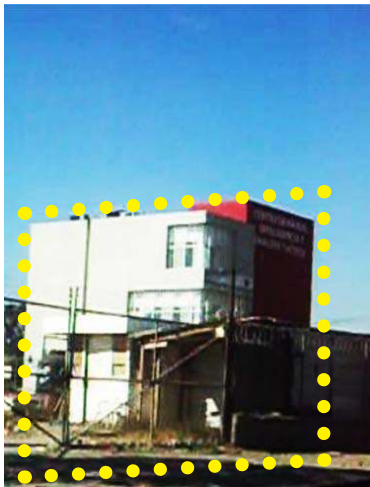
Imagen 118:Edificio nuevo sobre el camellón Fotografía tomada en el sitio.
