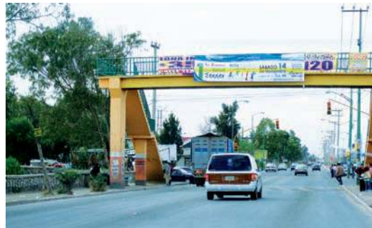
Imagen 128: Puente peatonal que no es utilizado, sobre el Bordo de Xochiaca. Fotografía tomada en el sitio.
