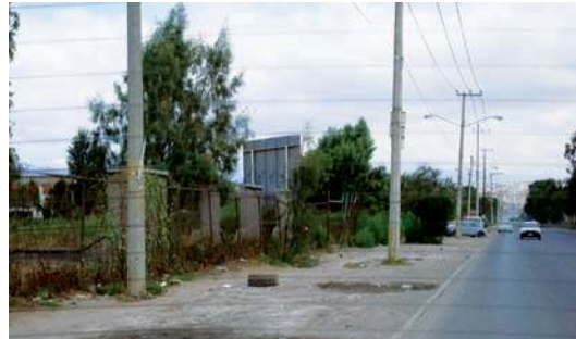
Imagen 130: Se muestra la falta de infraestructura para la circulación peatonal. Fotografía tomada en el sitio.
