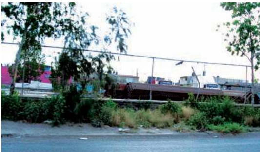
Imagen 129: Barrera física. Fotografía tomada en el sitio.
