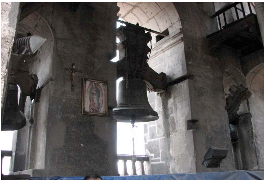
Figura 12. Interior del campanario izquierdo de la catedral metropolitana construido en el siglo XVIII. La campana es del siglo XVI. (foto Lourdes Turrent/ Gonzalo Latapí. 2007)
