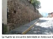
La Huerta se encuentra delimitada en todos sus lados, por un muro de piedra y cerámica de altura variable de entre 3 y 4 m, impidiendo así, las visuales tanto del interior al exterior como del exterior al interior.
