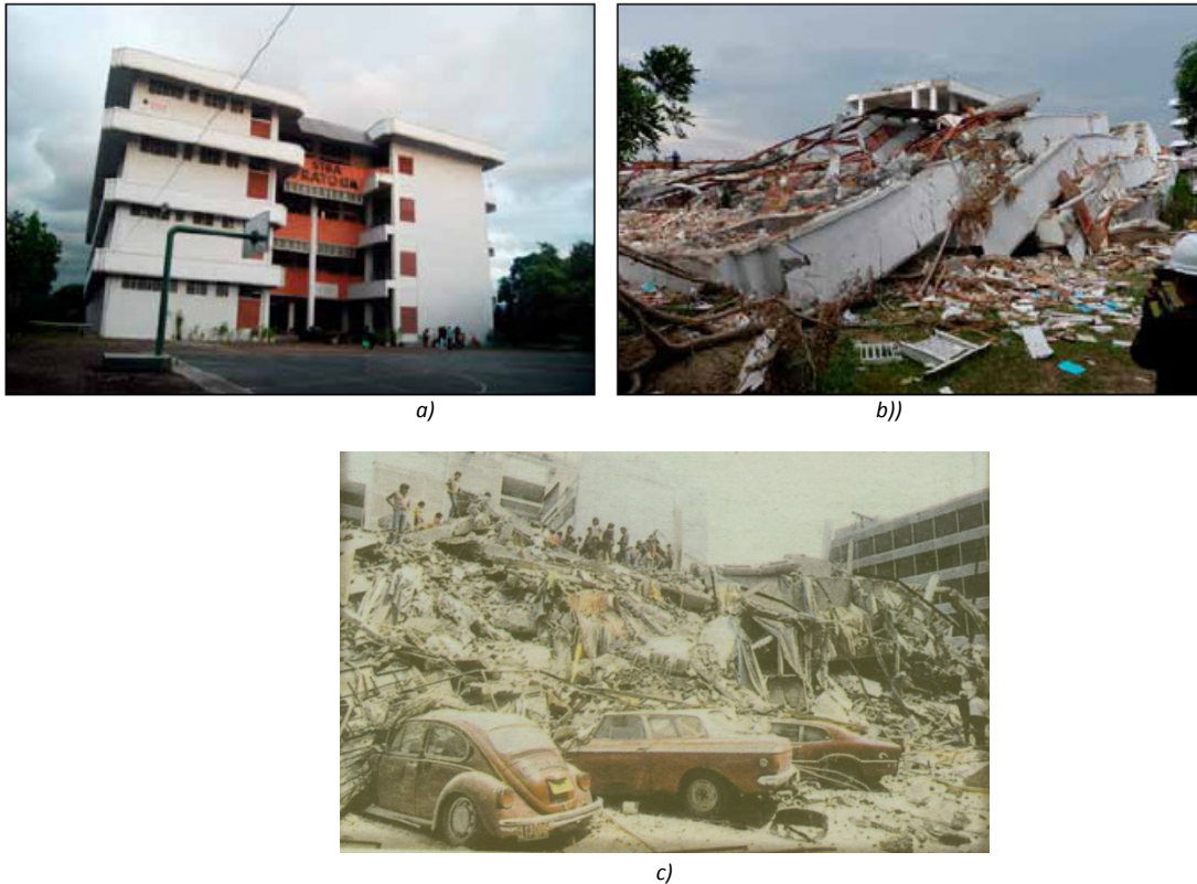
Figura. 2.2 Colapso tipo apilamiento a) y b) Fotografías de la escuela de Lenguas de Prayoga EERI et al (2009). c) CONALEP de Humboldt. Novedades (1985)
