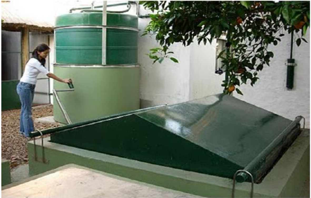
Figure 1.8: Biodigestor tipo fosa [4]
